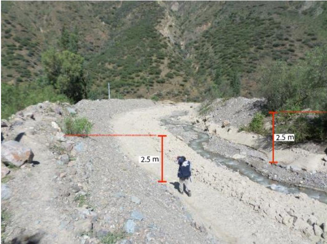
**Figura 16.** Vista de las barreras de contención con 2.5 m de altura, producto del material arrimado en ambas márgenes del cauce del flujo de detritos.
