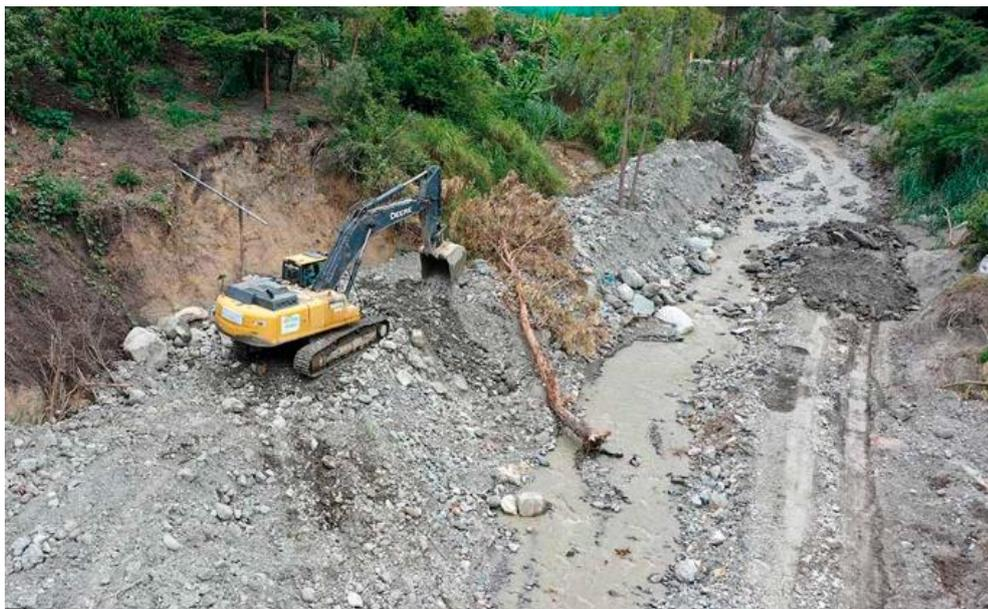
Fotografía 8. Descolmatación y limpieza del cauce de una quebrada, afectada por flujo de detritos.
