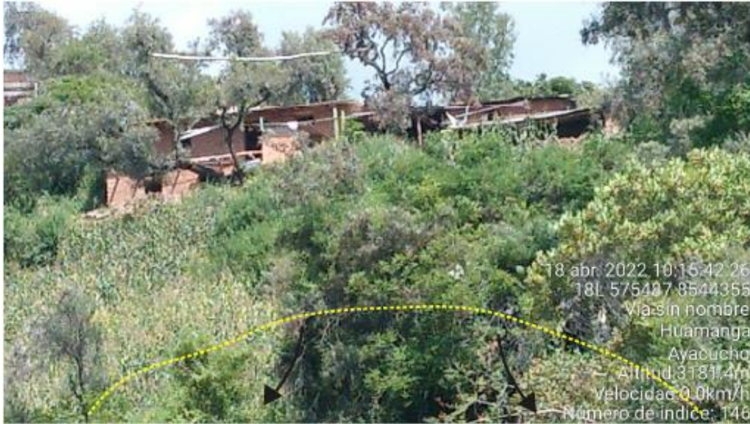
Figura 26. Se observan 4 casas ubicadas sobre la corona del deslizamiento.
