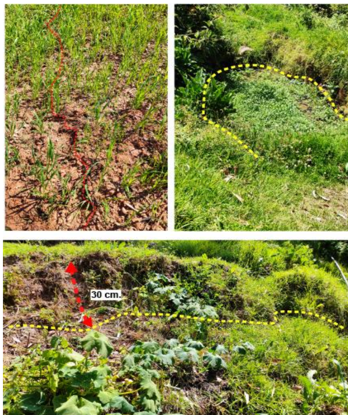
Figura 19. Agrietamientos transversales de hasta 4 m de longitud, ubicada a 5 m del deslizamiento rotacional, con dirección NW-SE, con saltos de 0.30 cm.
