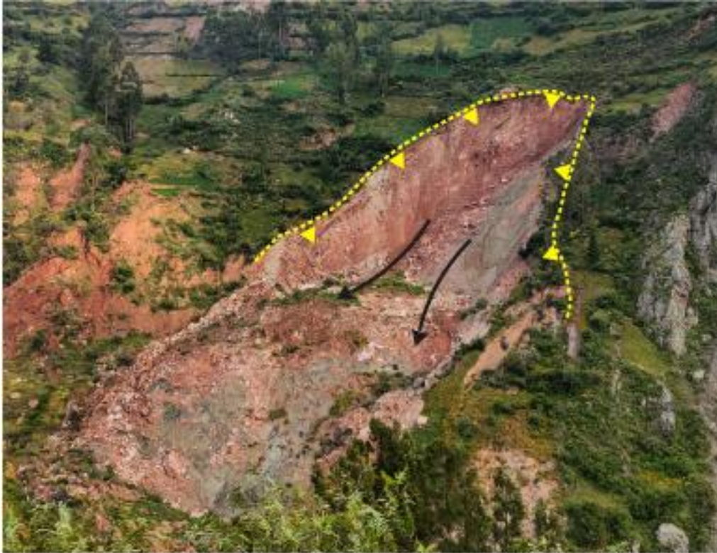
Figura 16. Vista del deslizamiento ocurrido en enero del 2021, se delimito la escarpa de color amarilla.
