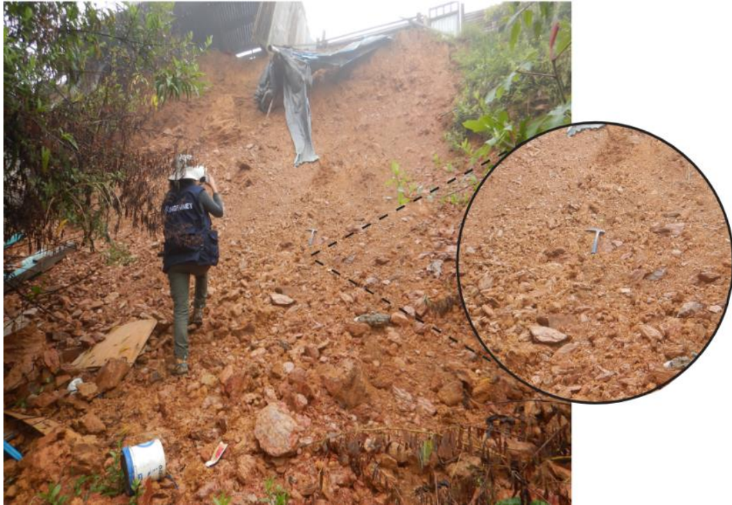
Figura 7. Material de depósito coluvio-deluvial compuesto por fragmentos de roca angulosos a subangulosos de tamaños variables (0.04 a 0.09), envueltos en una matriz limo-arcillosa.
