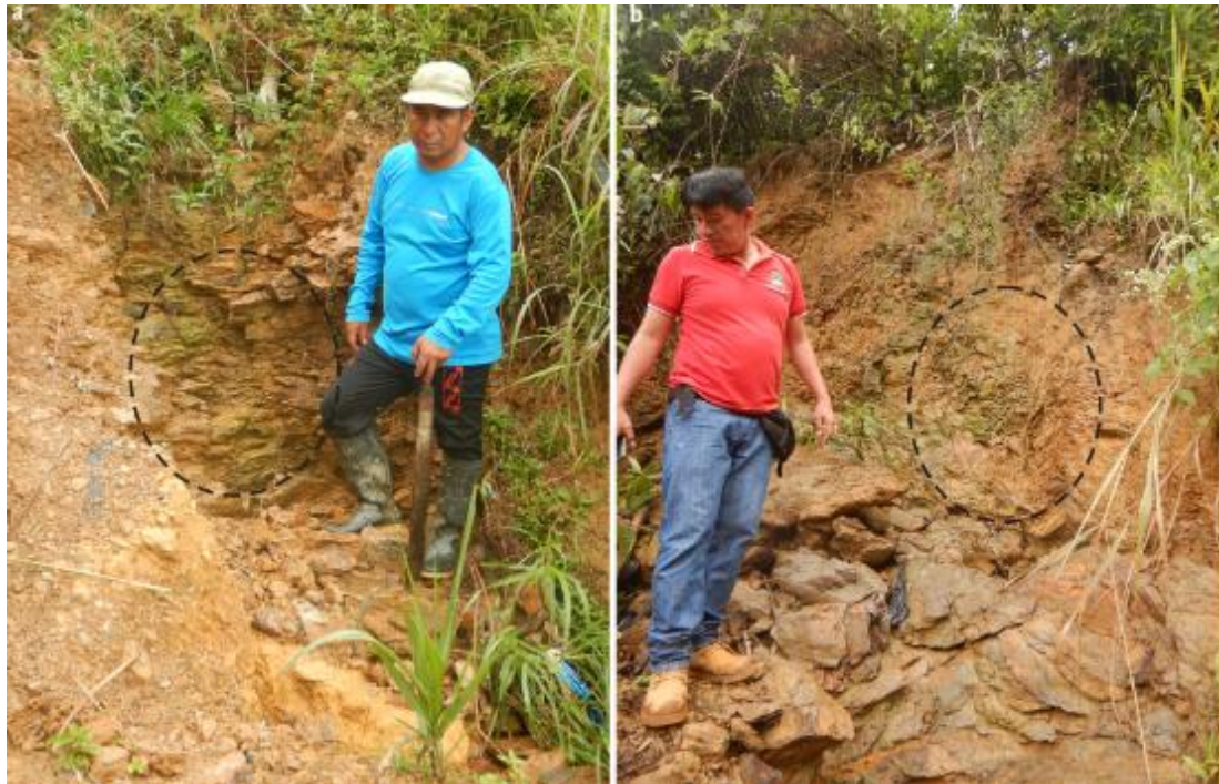
Figura 6. Sustrato rocoso conformado por una secuencia de limoarcillitas beige a grises las cuales se encuentran muy fracturadas, con espaciamentos próximas entre sí (0.06 – 0.25 m), además se presentan altamente meteorizado.
