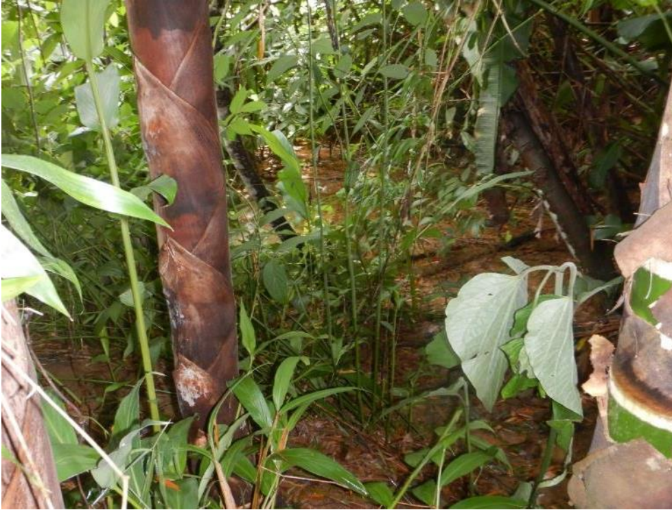
Fotografía 5. Se observa emanación de agua en el cuerpo del deslizamiento, esta apareció hace más de 10 años, según indican los pobladores de la zona, esta pequeña lagunita (con dimensiones aproximadas de 8x4m), el cual es permanente.
