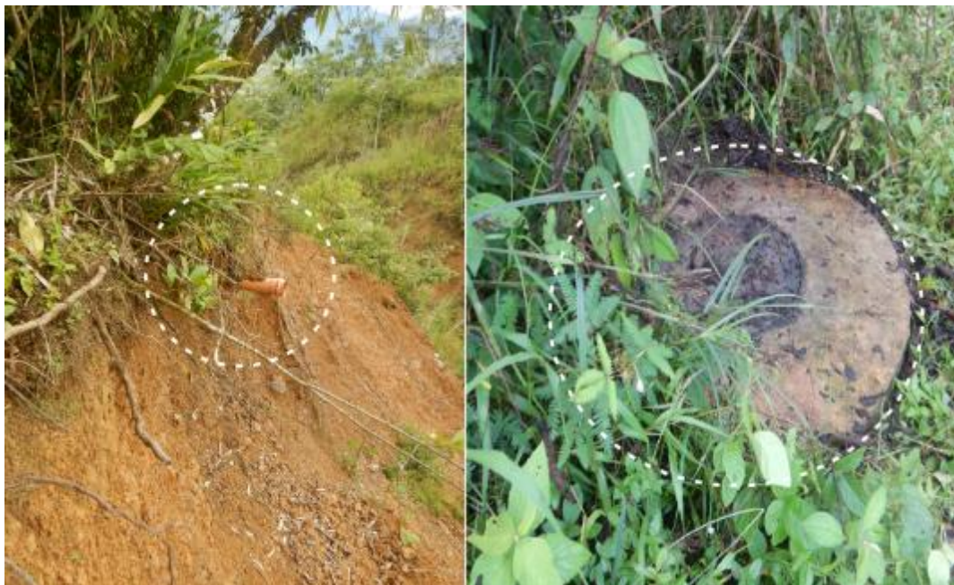
Figura 12. Se observa tubería destruida, también el buzón de desagüe que fue instalado hace cinco años atrás, actualmente ambas en desuso.
