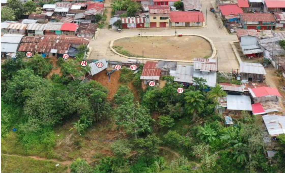
Figura 11. Vista tomada con el dron, donde se observa las viviendas ubicadas dentro de la escarpa del deslizamiento rotacional (señaladas con círculos)
