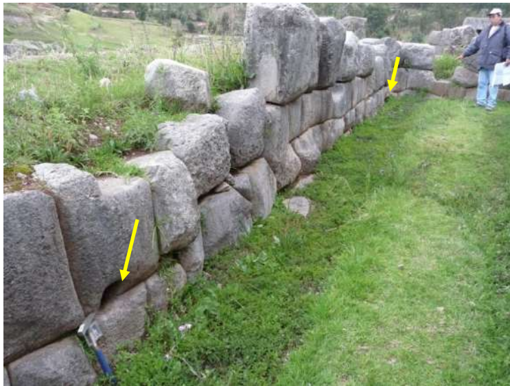
Foto 13. Drenajes a diferentes alturas del piso actual.
