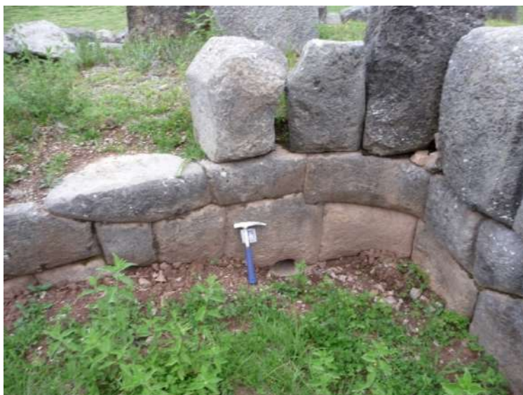
Foto 12. Drenaje en la esquina de un zigzag que coincide con el piso actual.
