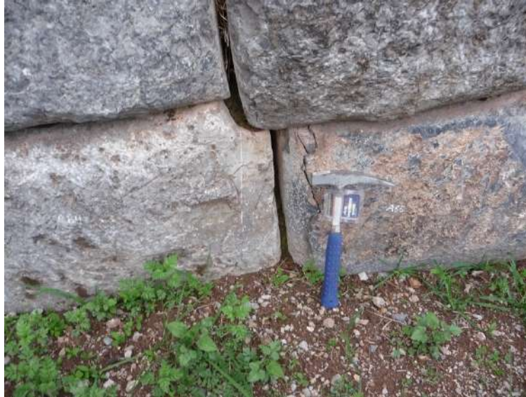
Foto 10. Bloque labrado de caliza fracturado.
