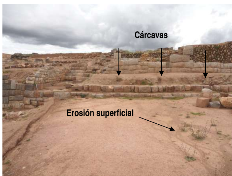
Foto 17. Erosión superficial de pisos y cárcavas asociadas.
