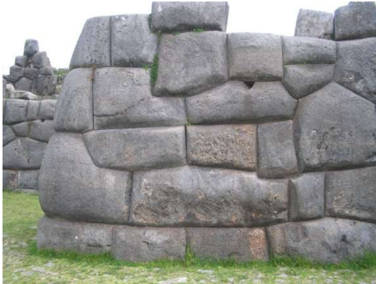
Foto 8. Dimensiones casi homogéneas de los bloques labrados de caliza y entre ellos un dren.
