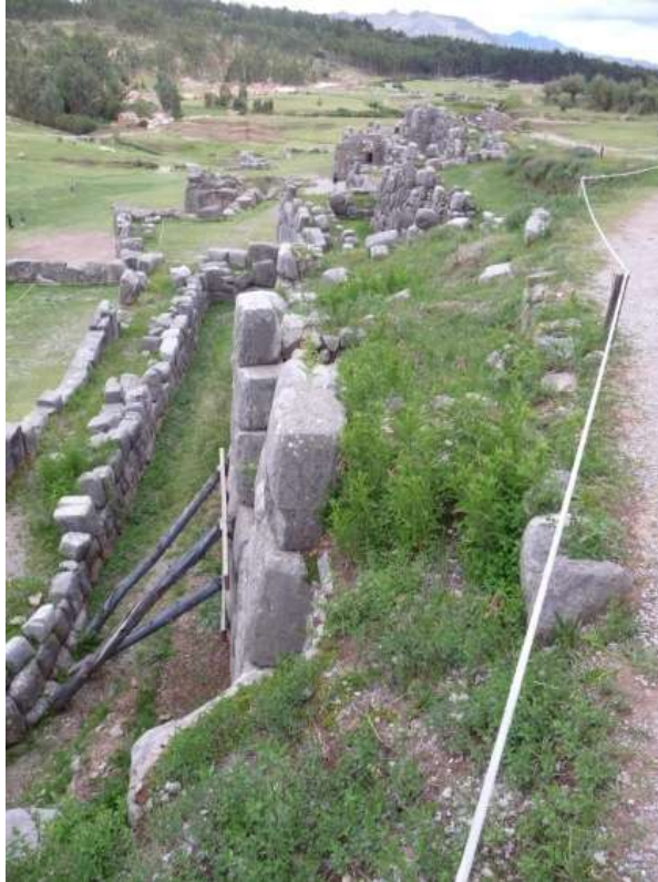
Foto 23. Pandeamiento de muro, en estado de colapso.
