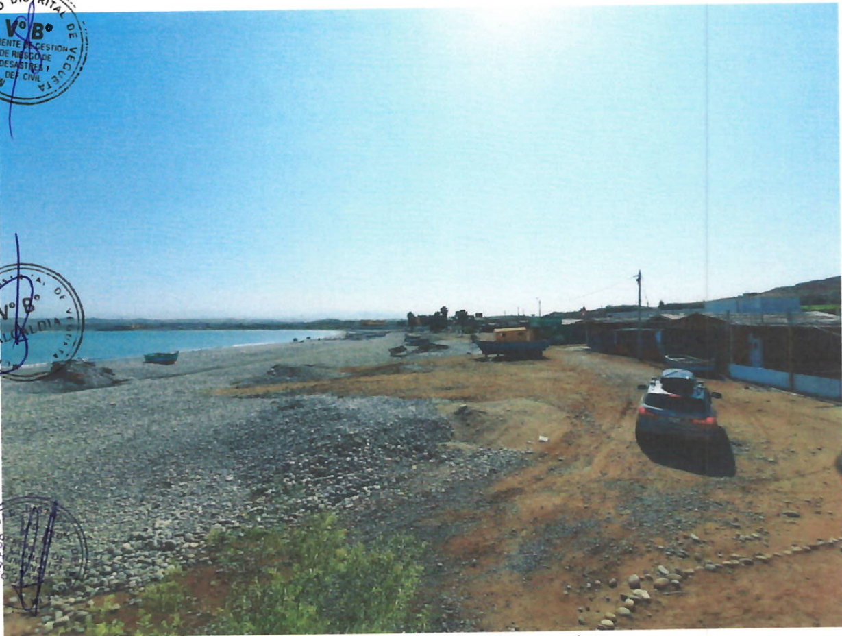
Zona de inundación - Sin abastecimiento de agua
