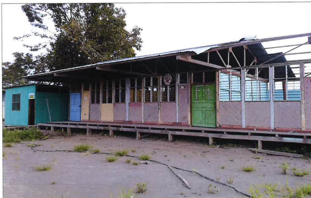
Fotografía N° 16. I.E. N° 244 - Nivel Inicial - Jardín
