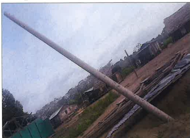
Fotografía N° 09. Poste del Servicio de Energía eléctrica
