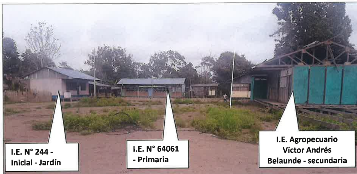
Fotografía N° 13. Ubicación de Infraestructura Educativa
