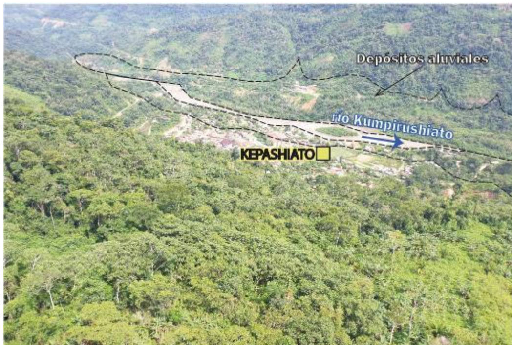
Fotografía 4. Depósitos aluviales, a ambos flancos del río Kumpirushiato.
