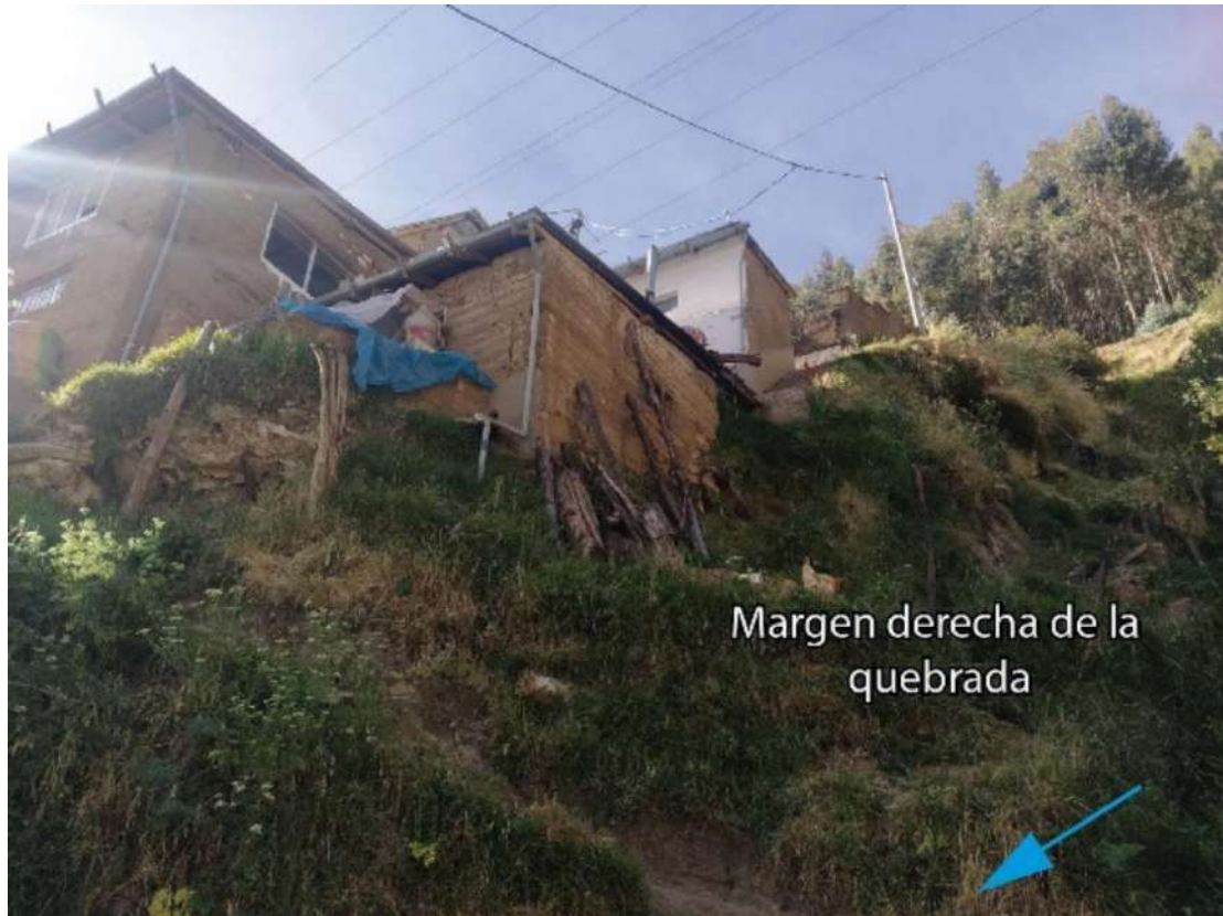
Figura 9. Se observan viviendas asentadas en la margen derecha de la quebrada Santa Barbara, con pendientes verticalizadas.
