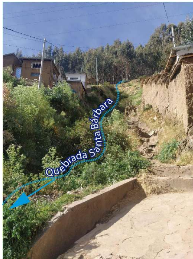
Figura 10. Se observan el cauce de la quebrada Santa Barbara, con pendientes de 27°.
