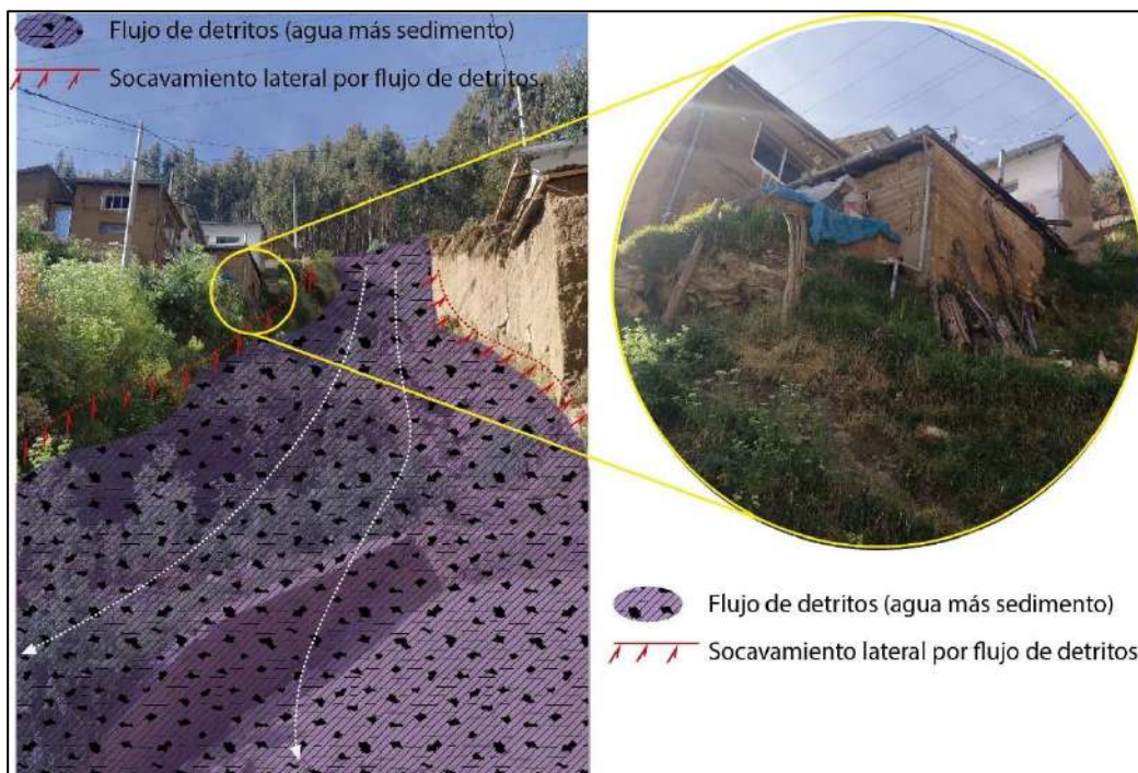
Figura 18. Representación del flujo de detritos. Obsérvese el socavamiento lateral que podría producir en la margen derecha de la quebrada donde se observó 01 vivienda con soportes de madera en las coordenadas UTM WGS 84: 18s, X:503395.22; Y:8586129.29.
