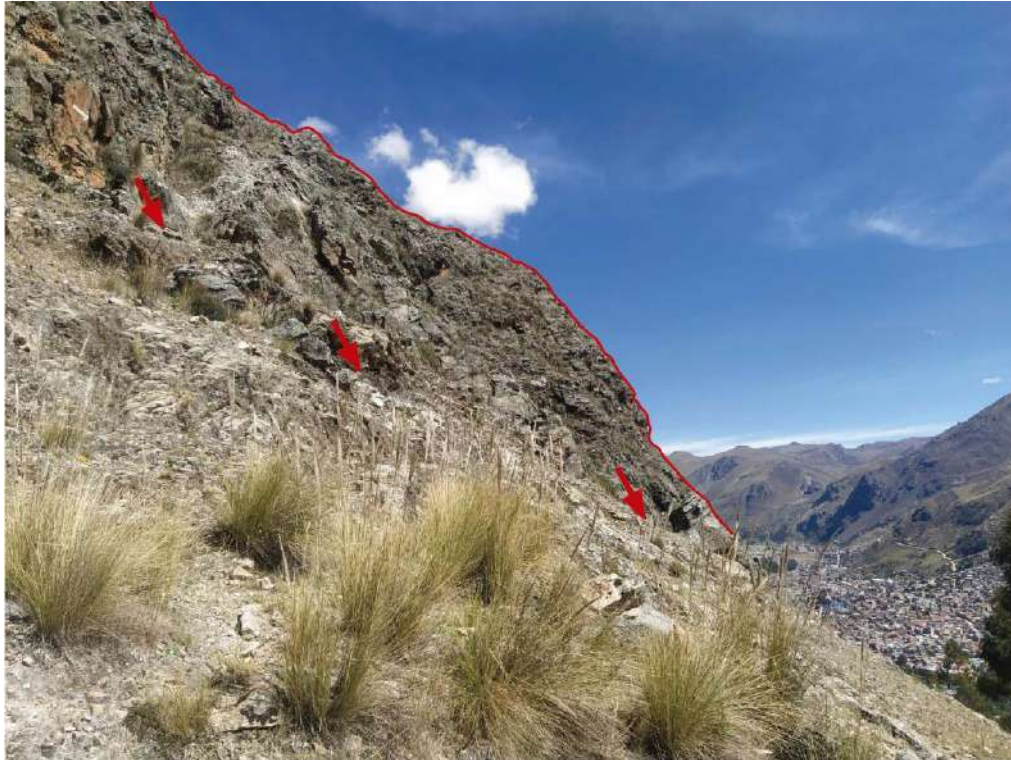
Figura 28. Ladera norte del cerro Santa Bárbara de donde pueden caer bloques de rocas.
