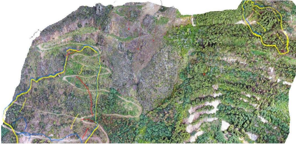
Figura 28. Vista del ortomosaico elaborado en mayo del 2022, los dos deslizamientos, expresado en escarpes (en línea azul) y grietas de tracción (en línea roja) recientes.
