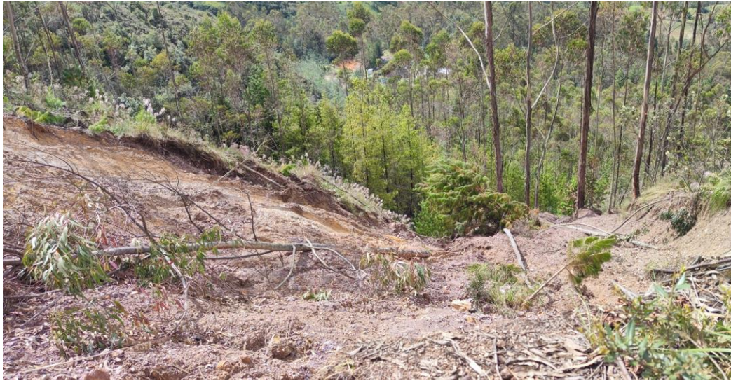
Figura 15. Vista de un depósito coluvio-deluvial producto del deslizamiento de material suelto en el cerro Chicche.
