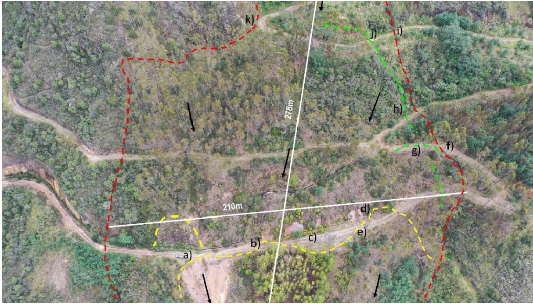
Figura 33. Vista desde un dron del deslizamiento principal del cerro Chicche (línea roja), donde se aprecian escarpes secundarios (línea amarilla) y grietas de tracción (líneas verdes).
