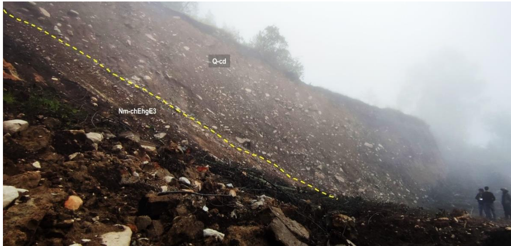
Figura 47. Vista de los depósitos coluvio-deluviales (Q-cd) situados sobre las lavas andesíticas (Nm-chEhgE3), sobre los cuales se desarrolló la superficie de falla del deslizamiento traslacional (en línea amarilla discontinua).
