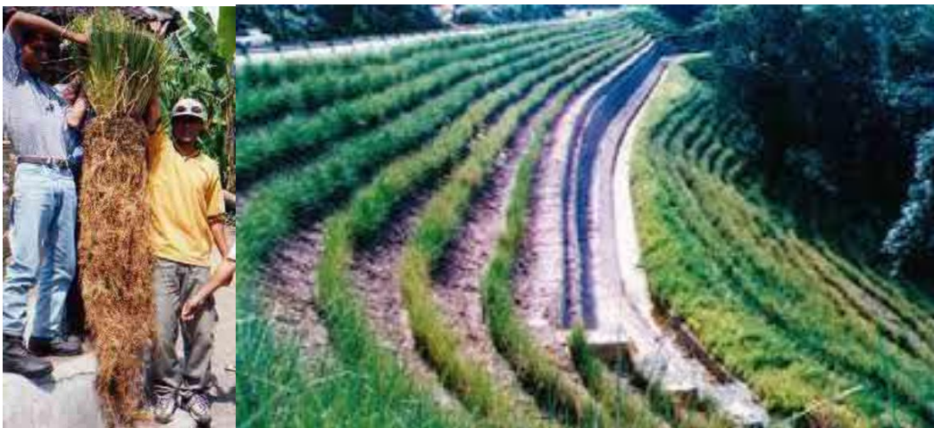
Figura 52. Ejemplo de bioingeniería con arbusto (vetiver) en taludes de materiales sueltos.
