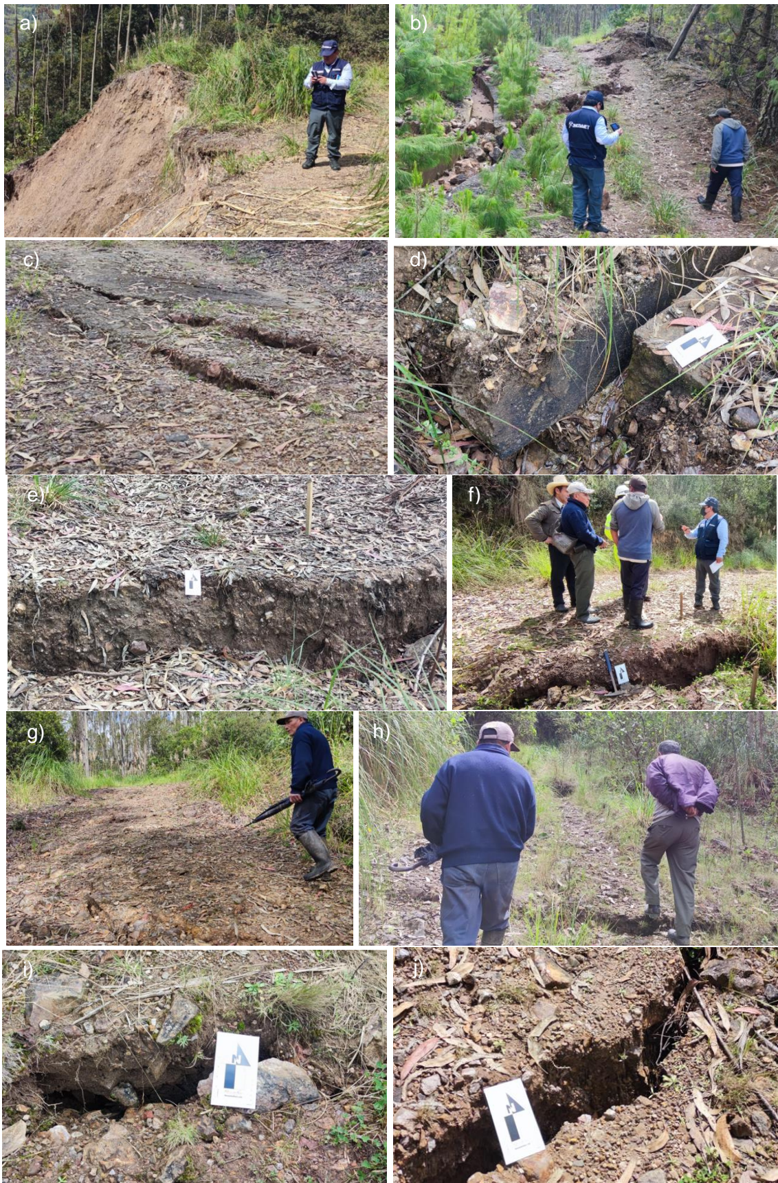
Figura 35. Detalle de los escarpes y agrietamientos del deslizamiento principal del cerro Chicche (a, b, c, d, e, f, g, h, i, j), la ubicación de estas fotografías se presenta en la Figura 32.
