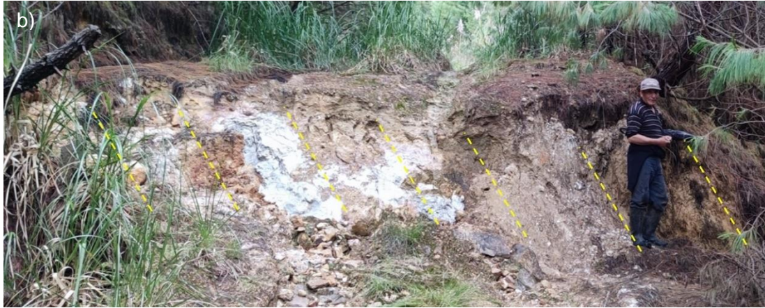
Figura 31. Flanco derecho del deslizamiento norte. La ubicación de la foto se muestra en la Figura 29.
