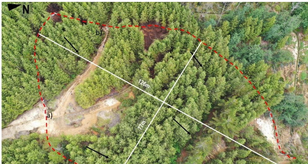
Figura 29. Vista desde un dron del deslizamiento norte del cerro Chicche.
