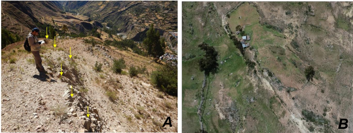
Figura 10. A) Escarpa de deslizamiento rotacional, ubicado en la margen izquierda de la quebrada Puca Puca. Este evento se originó el 2019 debido a las intensas precipitaciones pluviales en la zona. B) Vista del deslizamiento reactivado, con 2 m de altura.
