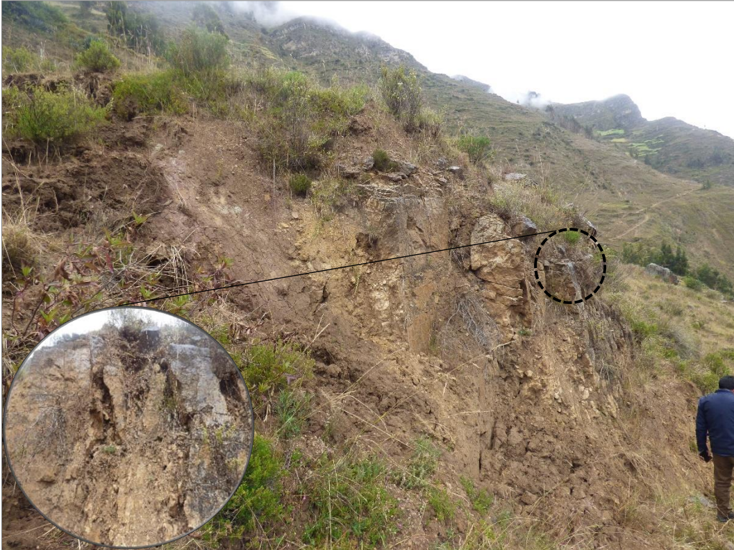
Figura 4. Afloramiento rocoso, compuesto por calizas medianamente fracturado y moderadamente meteorizado.
