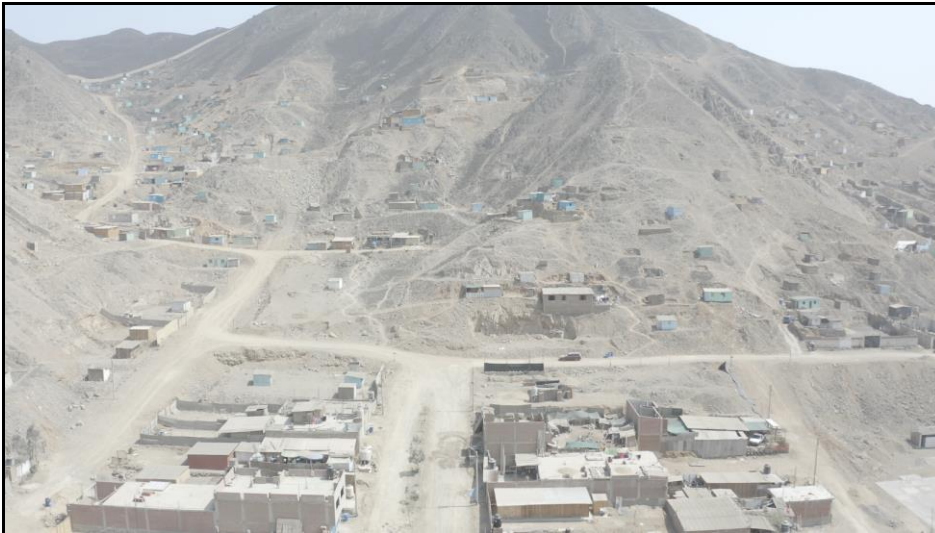
Vista aéreo de las edificaciones que se localizan en la Quebrada Retamal
