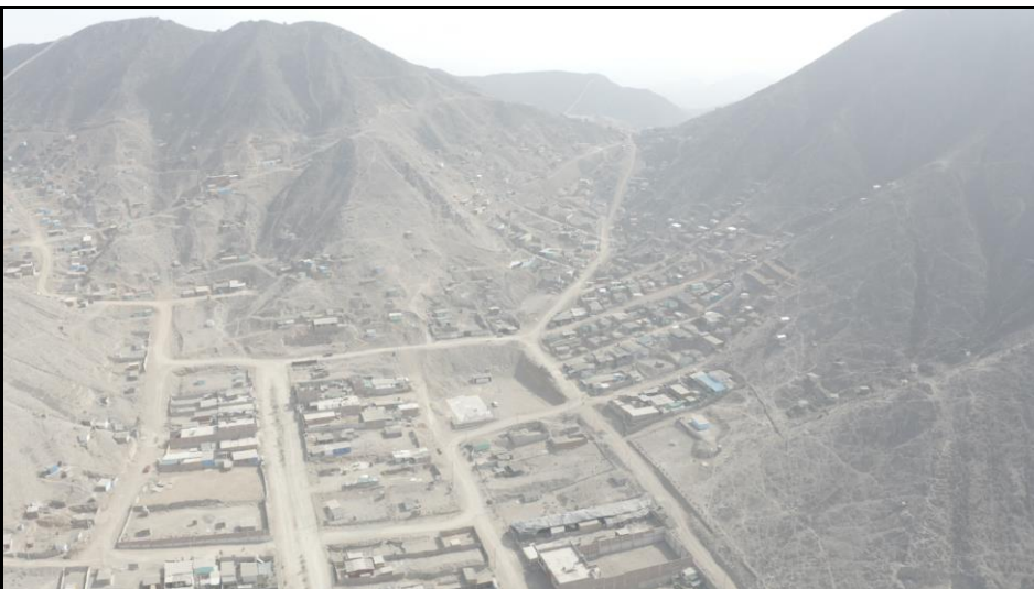
Vista aéreo de las edificaciones que se localizan en la Quebrada Retamal
