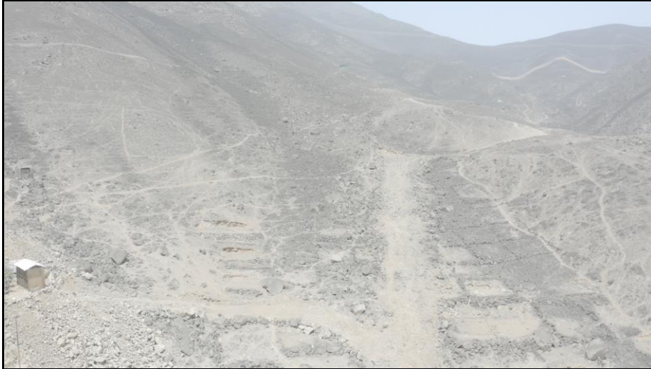
Vista aéreo de las edificaciones que se localizan en la Quebrada Retamal
