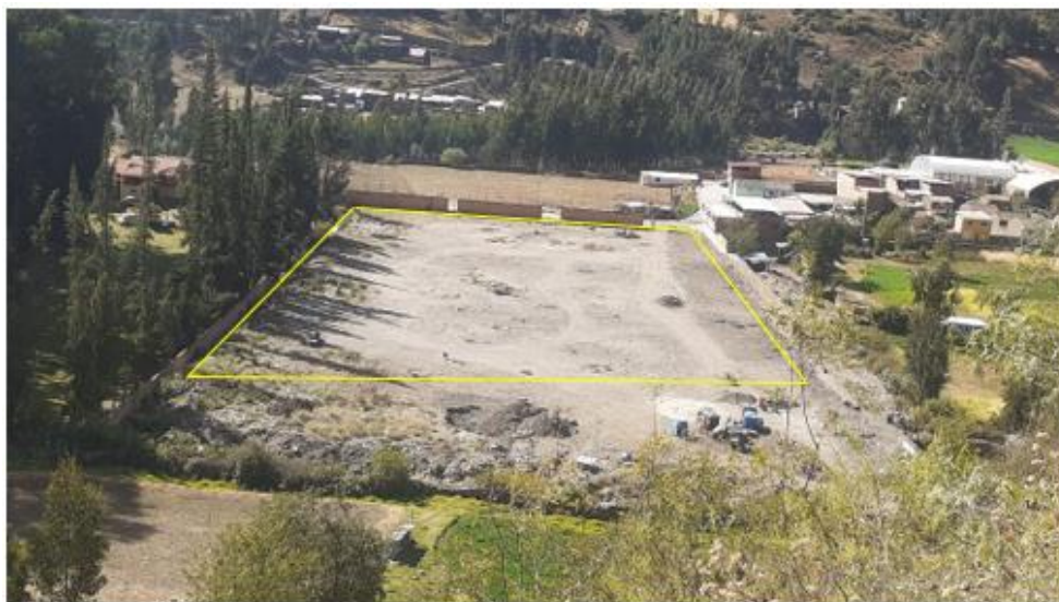
Figura 19. Vista del terreno propuesto, demarcado de color amarillo, para la reubicación de las viviendas afectadas por el derrumbe del 30 de junio del 2022.
