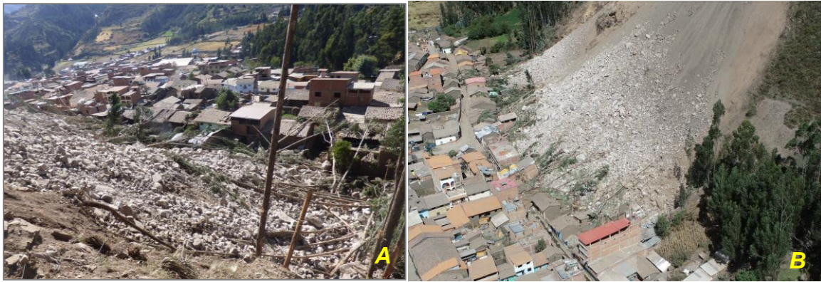
Figura 10 (A) y (B) Se muestra la zona de plantaciones de árboles arrastrados por el derrumbe.
