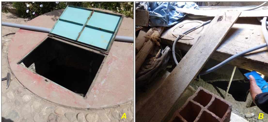
Figura 11. Vista de captación de agua. A) Hotel Inca. B) En el interior de la vivienda, el nivel freático se encuentra a 0.8 m.
