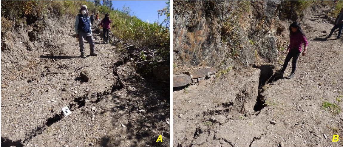
Figura 9. Vista de Agrietamientos en el camino de herradura que corta depósito de deslizamiento antiguo. Presentan aperturas de hasta 60 cm.
