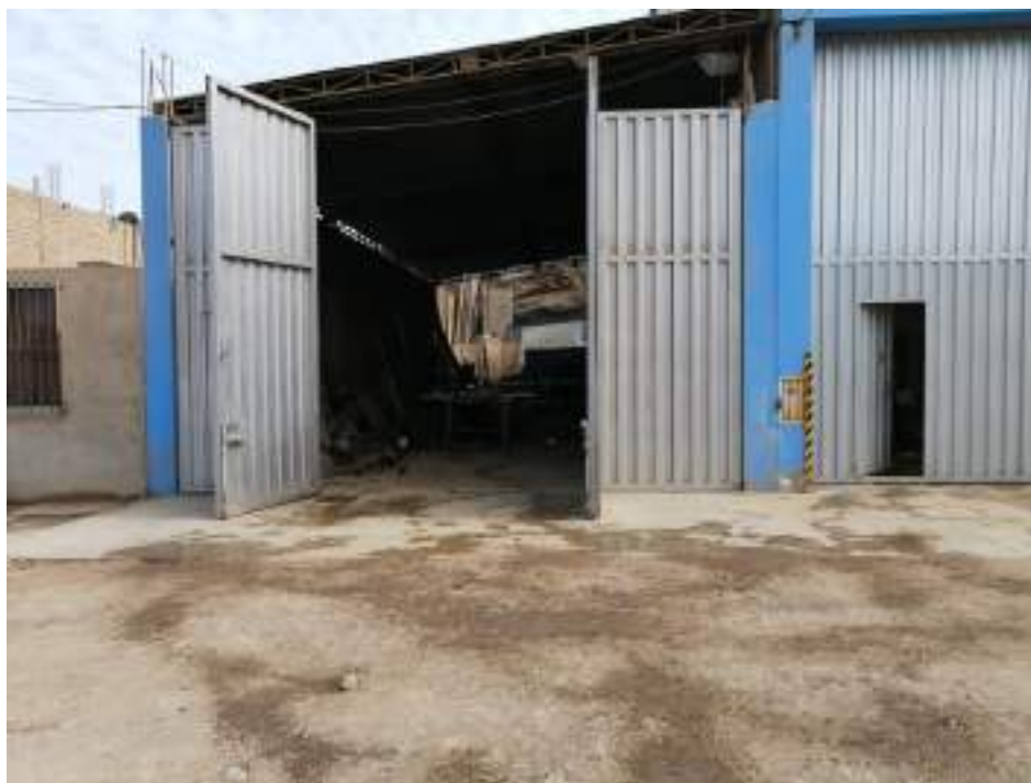
Foto N°24 MZ. A Lote 5. Local industrial.
