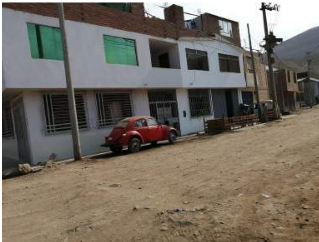
Foto N°21 MZ E Lote 1. Vivienda de material noble con techo de losa aligerada.
