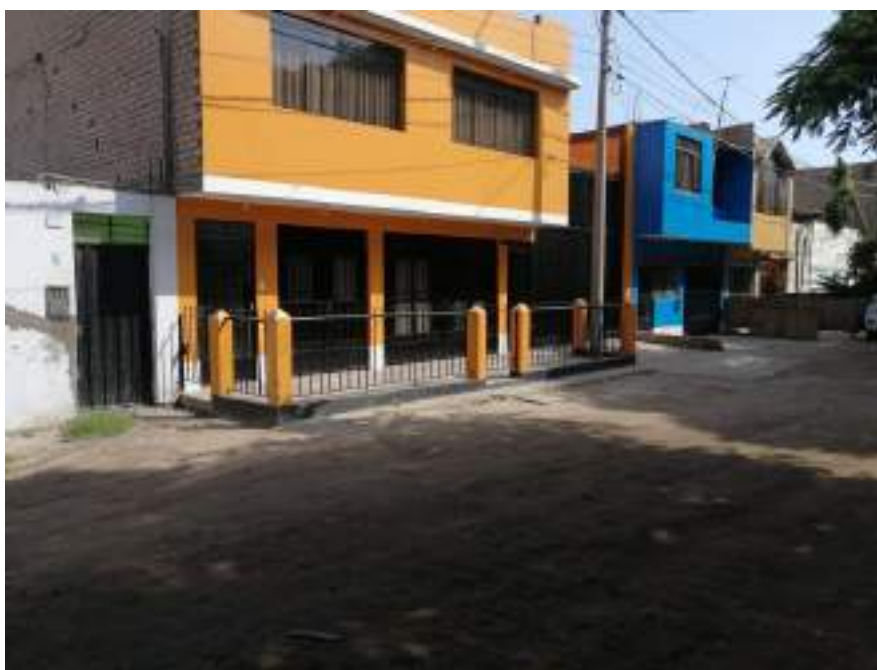
Foto N°4. Viviendas de material con techos de concreto armado y muros de ladrillo. No tienen rigidez en sus elementos estructurales.
