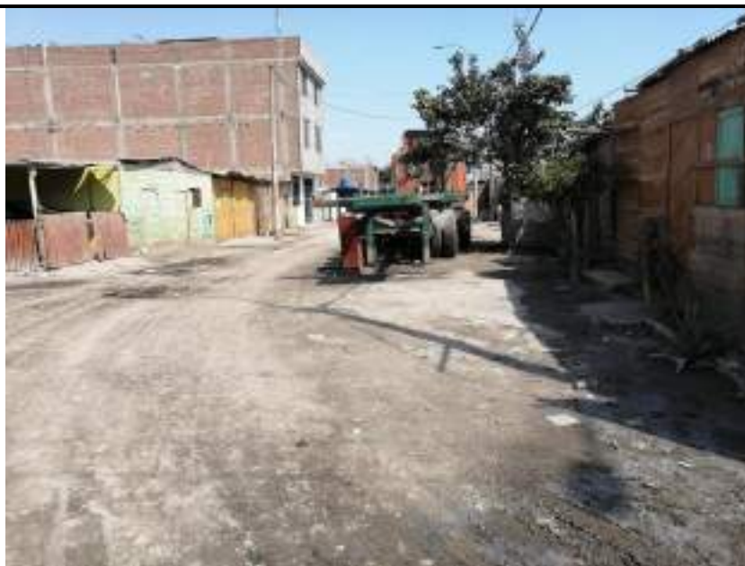
Foto N°3. Vías sin asfaltar en toda la Urb. La Rinconada
