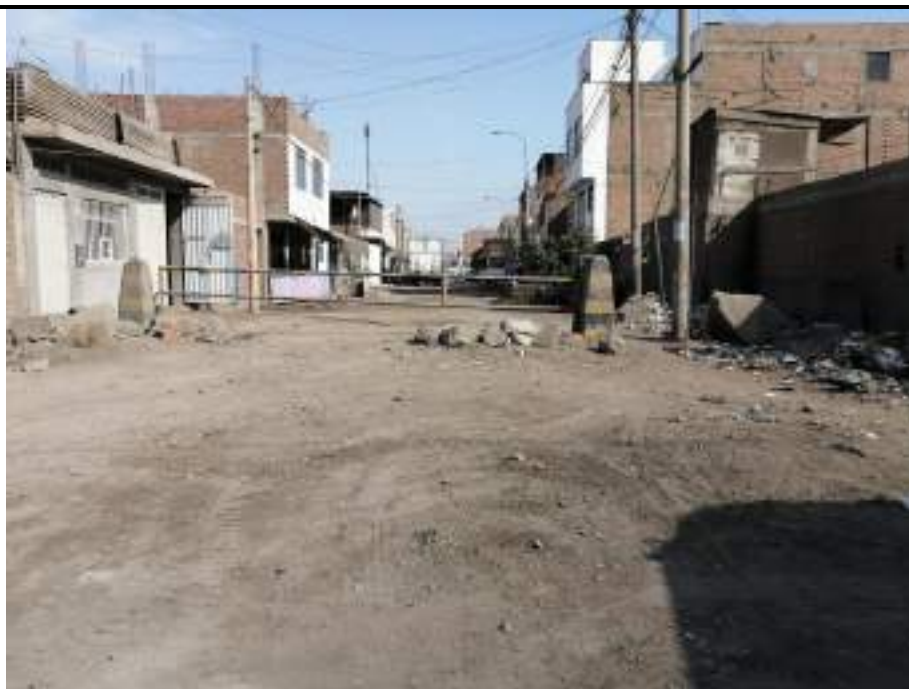
Foto N°5 Tranquera en el Ca. N°1, como se observa forma parte de un obstáculo para el libre tránsito ante una evacuación.
