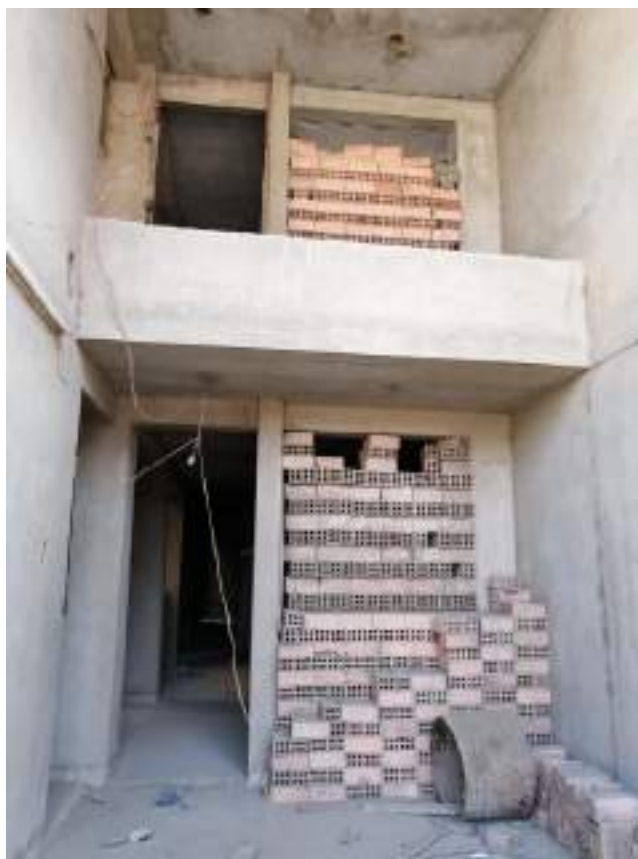
Foto N°12 viviendas sin acabar, no habitadas.
