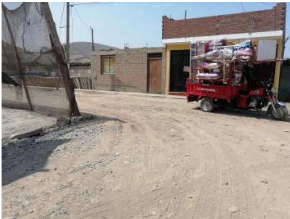
Foto N°34 MZ.I lote 48 Vivienda con muros de ladrillo.
