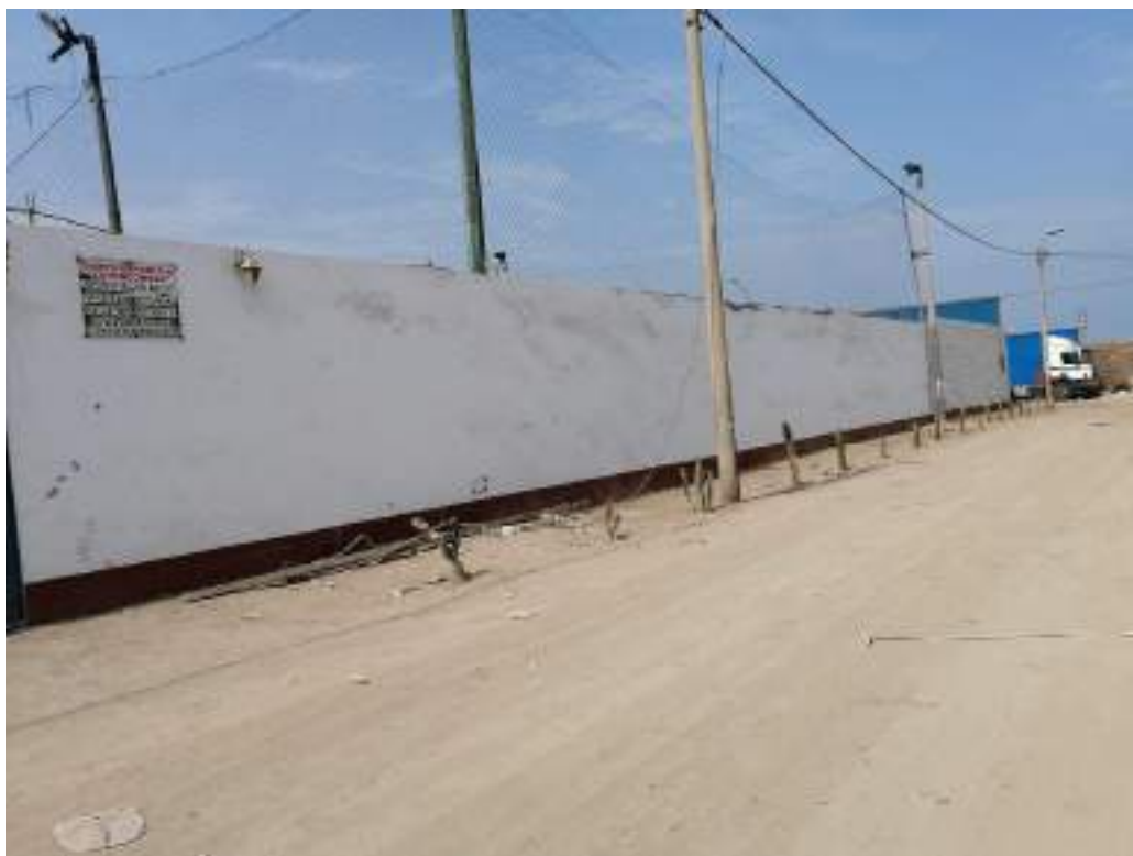
Foto N°28 Mz E, Local deportivo
