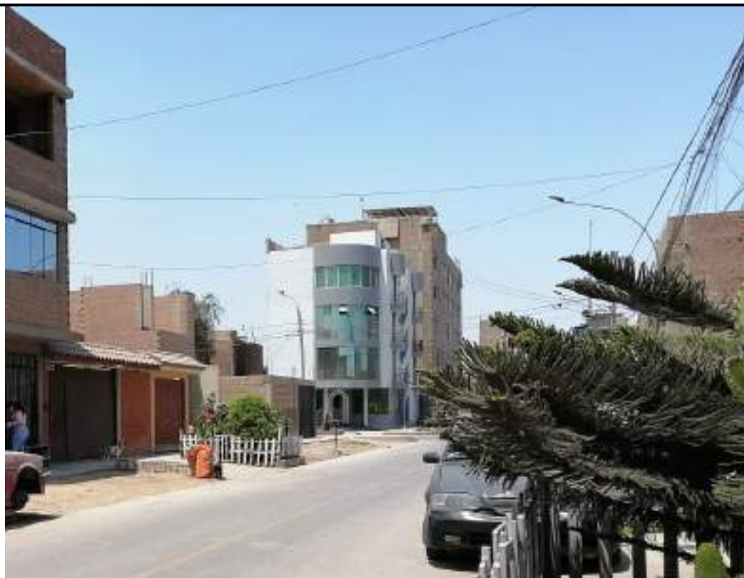
Foto N°13 edificaciones de hasta 5 pisos.
