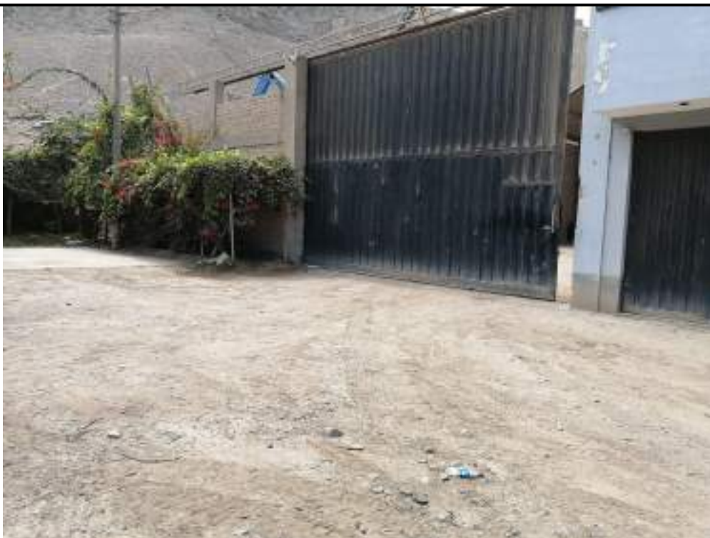
Foto N°29 MZ. E Lote 13, 14, 19 20 y 21. Unificados y que sirven de garaje para vehículos de carga pesada, container .
