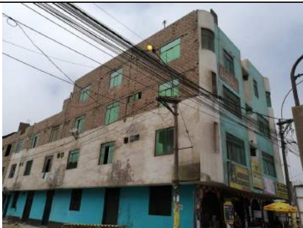
Foto N°37 Vivienda con infraestructura de material noble de hasta 4 pisos, se muestran todos los cables de conexión eléctrica, telecomunicaciones las cuáles se recomienda deberían ir de manera subterránea.
