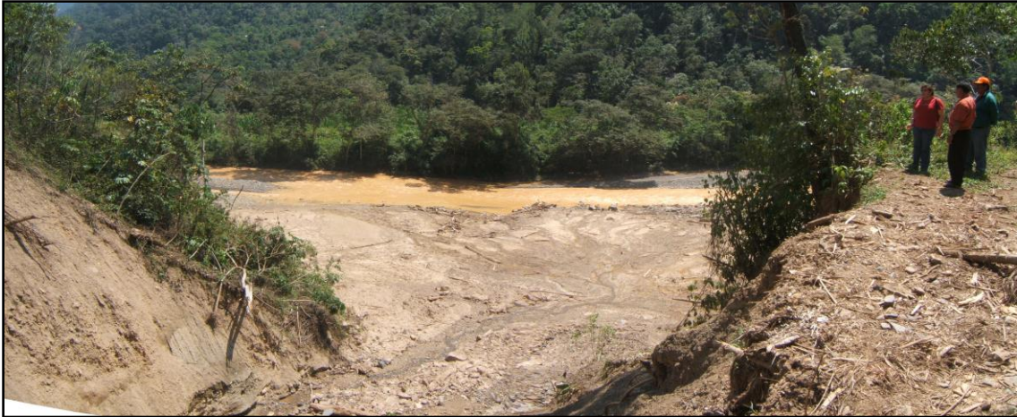
Foto 1.- Vista de la quebrada Tigrefuso, que afecto la carretera afirmada de Pacaysuizo-Santa Rosa.
