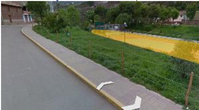
Imagen N° 9: Vía afirmada en el cauce de quebrada.
