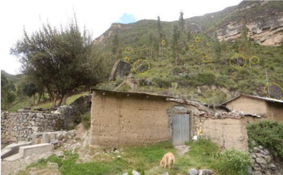
Figura 16. Se observa bloques de rocas sedimentarias con tamaños entre 2 a 4.2 m, que llegaron a afectar a dos viviendas, actualmente dichas viviendas repusieron sus techos de calamina, que fueron afectadas.
