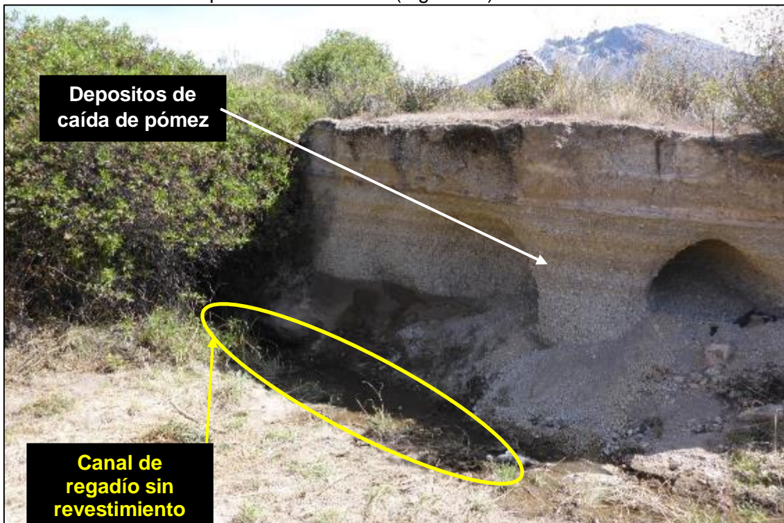
Figura 10. Canal sin revestimiento en el sector de Yarapampa, depósitos de caída de pómez volcán Ubinas de hace 14 – 16 mil años (Samaniego et.al.,2020) (UTM E: 300989, N: 8185072).
