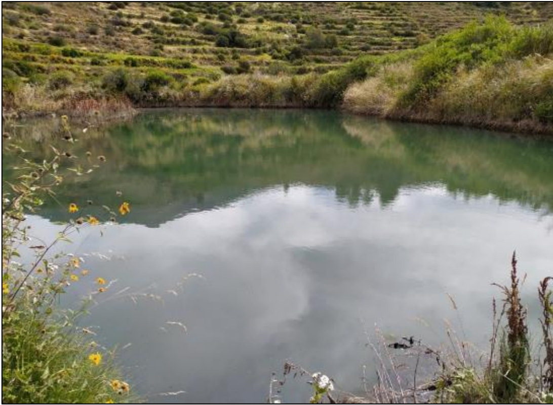
Figura 14. Reservorio de agua Ayamoco. (coordenadas UTM E: 300849, N:8185734)
