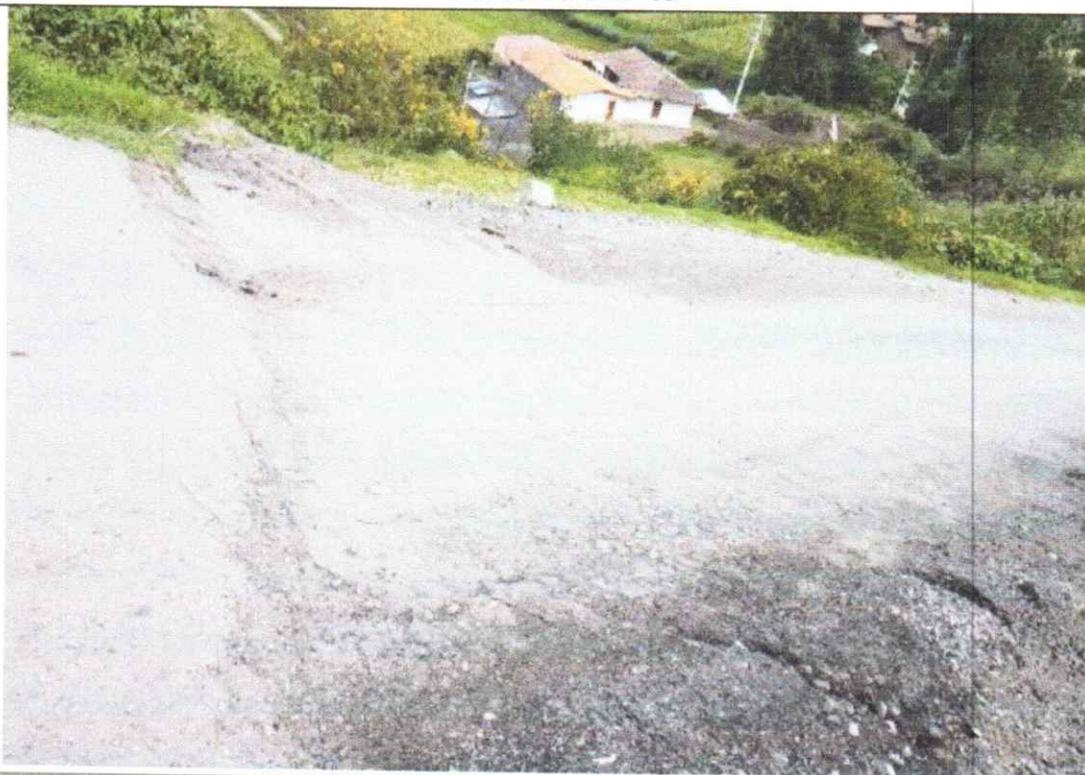
Se observa el desnivel en la vía de accesibilidad como consecuencia de las fronteras de deslizamiento que corresponde a la zona de deslizamiento 1.
