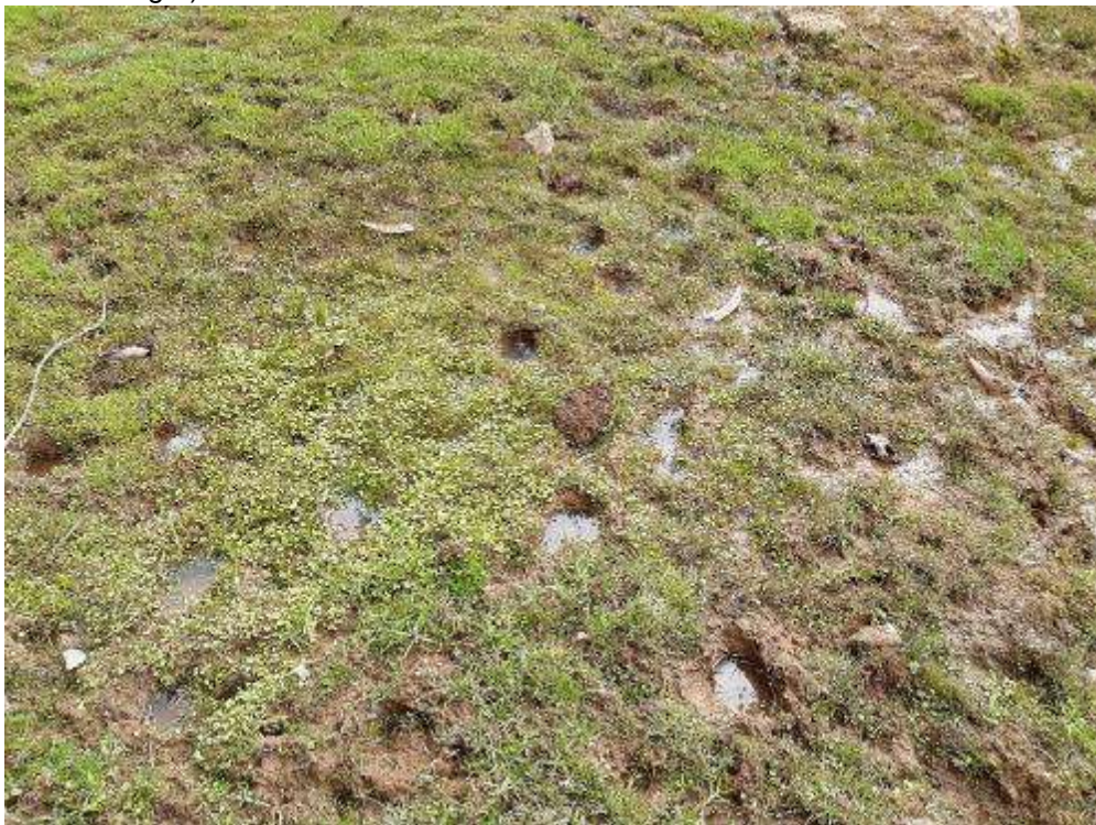
Fotografía 5. Vista del suelo saturado, con surgencia de agua en el cuerpo del deslizamiento reactivado, ubicado con coordenadas UTM (WGS 84): 361028 E; 8860980 N.
