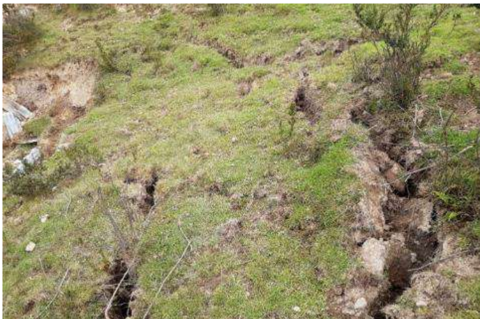
Fotografía 9. Vista de grietas con profundidades visibles que varían de 50 cm a 80 cm, con desplazamientos de hasta 30 cm, distribuidos sobre la corona del derrumbe.
