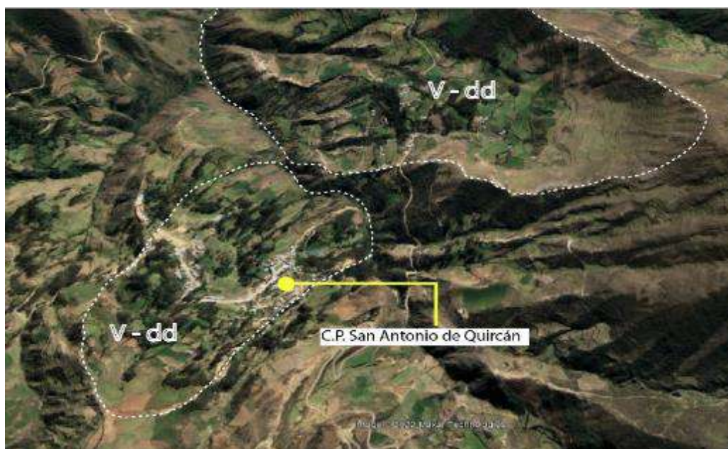
Figura 9. Vista de la subunidad geomorfológica, vertiente con depósito de deslizamiento (V-dd), corresponde al cuerpo de los deslizamientos antiguos y recientes.
