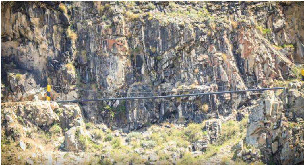
Fotografía 10. Ejemplo de un canal de regadío entubado, el cual se encuentra suspendido con el debido soporte, atravesando una cárcava.
