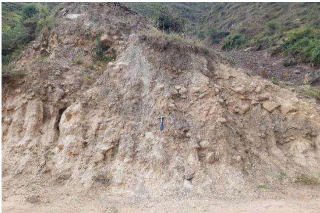
Fotografía 2. Depósitos coluvio-deluviales ubicado sobre la vía C.P. Quircán – C.P. Añay, con coordenadas UTM (WGS 84): 362847 E; 8862187 N.
