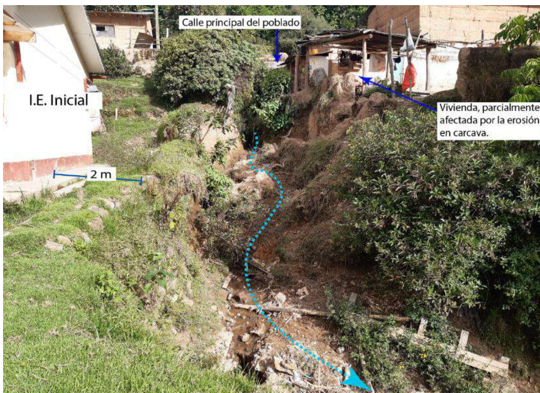
Figura 17: Vista de la erosión en cárcava que podría afectar la I.E. Inicial y una vivienda, asentadas en las márgenes de la cárcava, con coordenadas UTM (WGS 84): 361237.652 E; 8861213.273 N.
