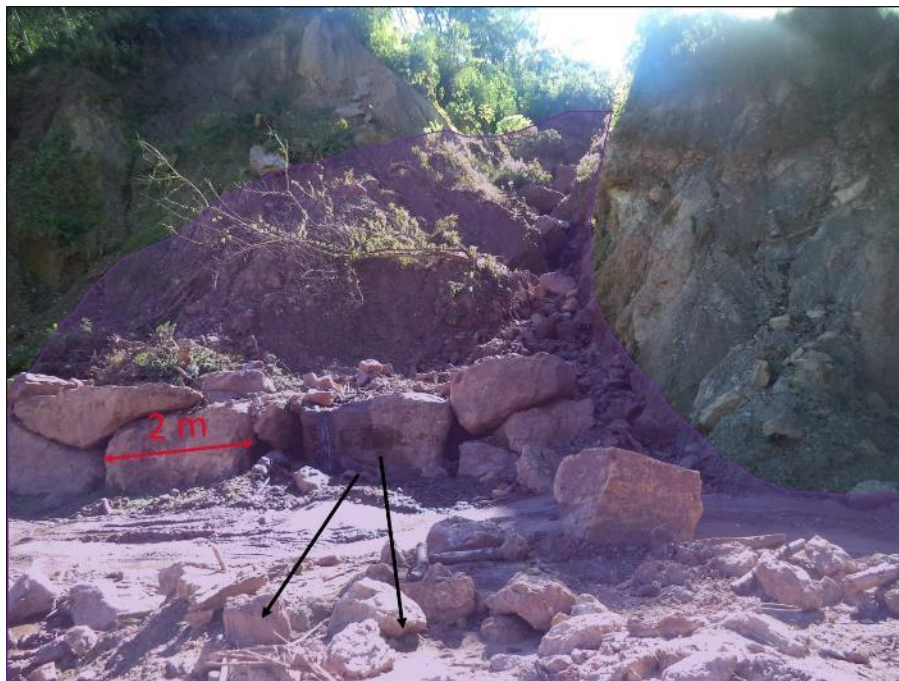
Figura 3. Vista tomada en coordenadas UTM E 725061; N 8554083. Se aprecian Materiales arrastrados por el flujo de detritos depositados en la carretera Lucma - Marampampa.
