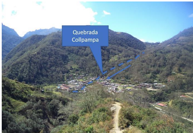
Figura 13. Vista de la quebrada Collpampa y poblado de Lucma.
