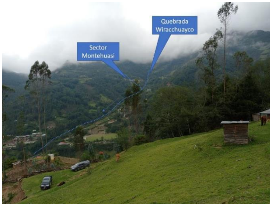
Figura 5. Vista de la quebrada Wiracchuaycco - Sector Montehuasi y viviendas.
