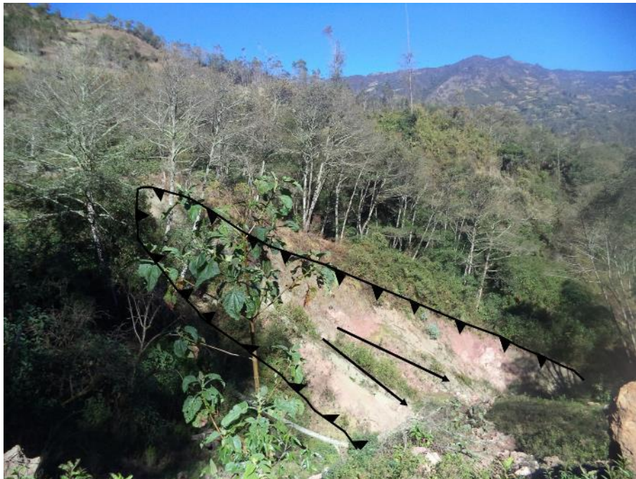
Figura 9. Deslizamiento del sector Llulluchayoc, se aprecia el escarpe de 4 m de caída del deslizamiento y los árboles inclinados de la zona.
