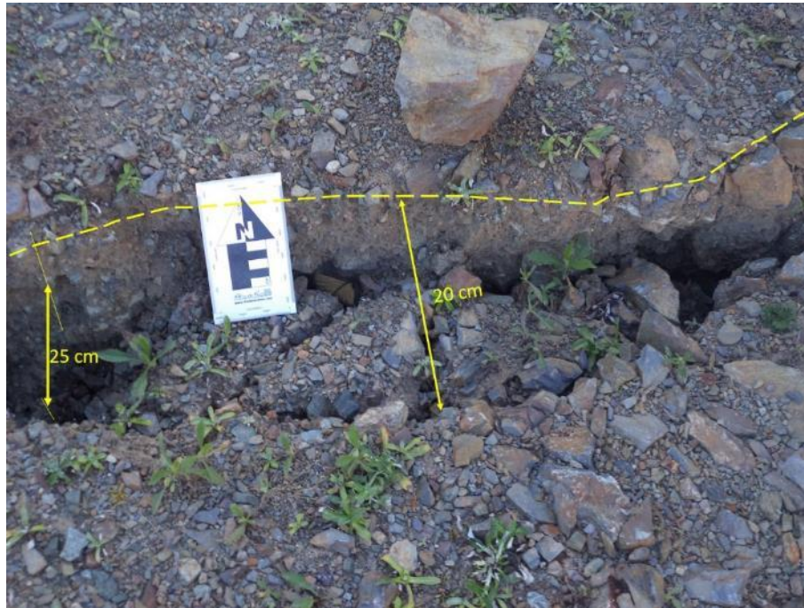
Figura 7. Acercamiento de la plataforma en tramo de carretera Lucma – Marampampa.
