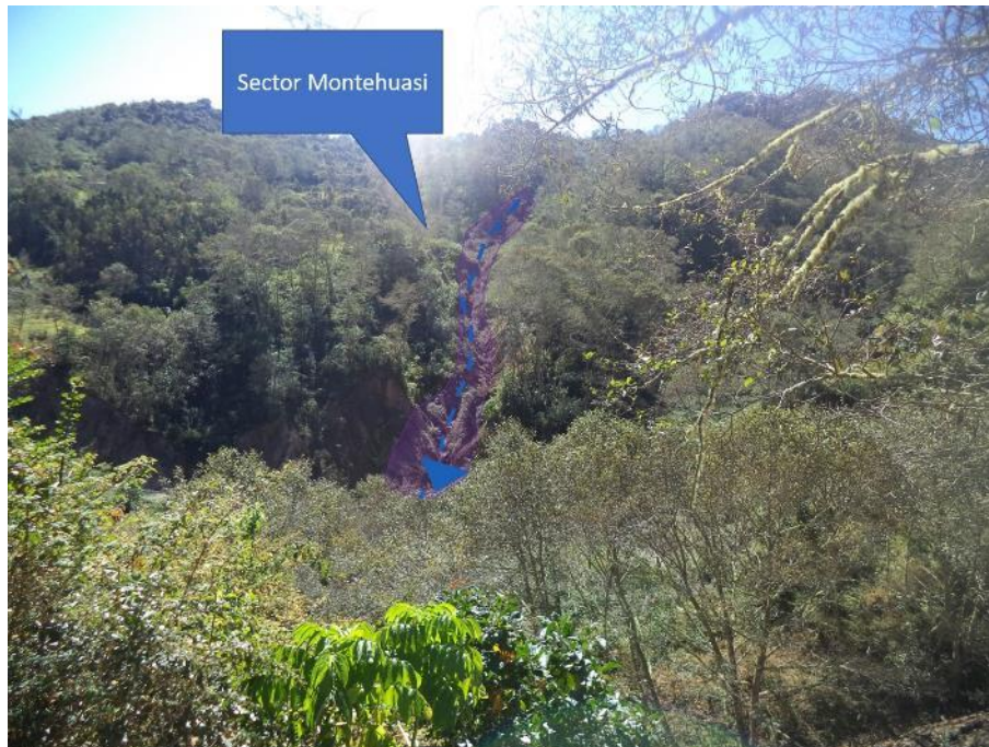
Figura 2. Sector Montehuasi, se aprecia el canal por donde pasa el flujo de detritos el año 2020.
