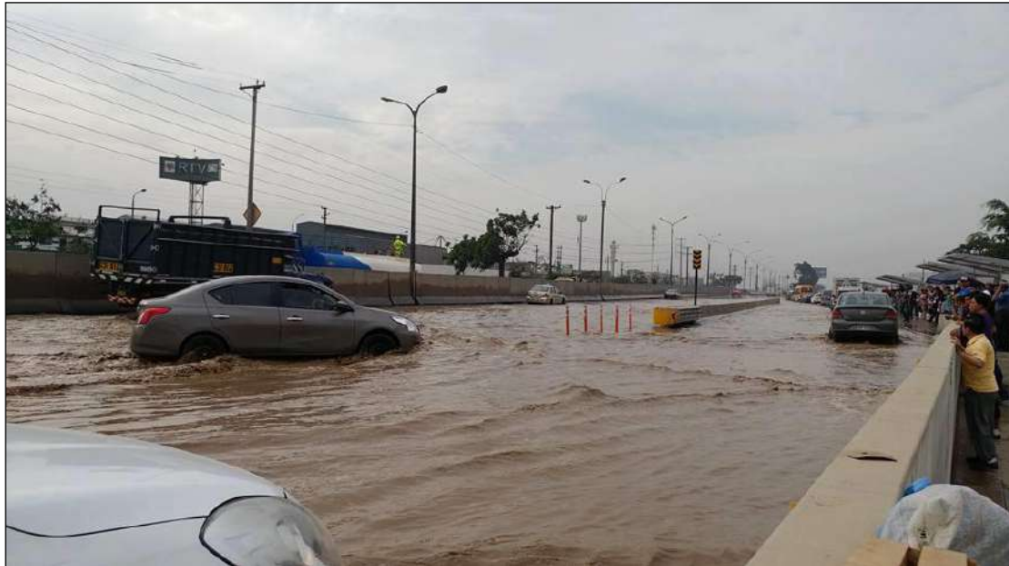
Lima, 16/03/2017. El peligroso caudal del río Chillón se desbordó y afectó un sector de la carretera Panamericana Norte, en Puente Piedra (Fuente: Diario El Comercio).
