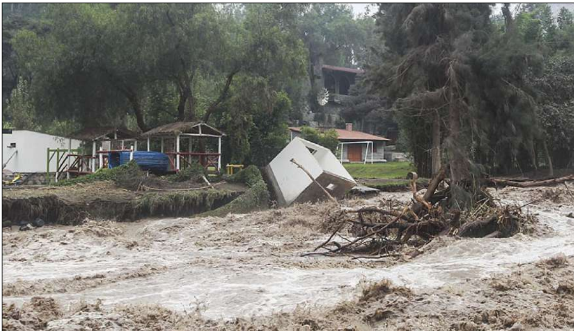
Lima, 16/03/2017. Erosión de la ribera del río Lurín en el distrito de Cieneguilla. (Fuente: Diario El Comercio).
