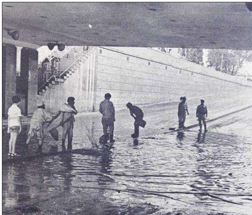
Lima, 17/01/1970. Diversas arterias de la Gran Lima, como el paso a desnivel de la Av. Arequipa quedaron cortadas al tráfico vehicular por la torrencial lluvia. (Fuente: Diario La Primera)
