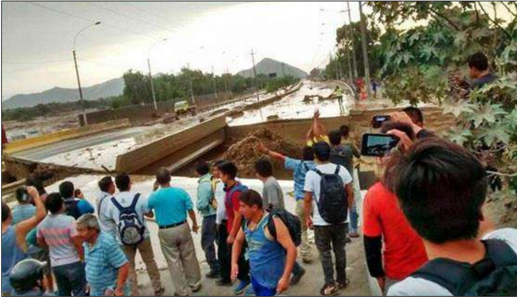
Lima, 31/01/2017: Puente Huaycoloro desplazado por la fuerza del agua en el distrito de San Juan de Lurigancho (Fuente: Diario El Comercio).
