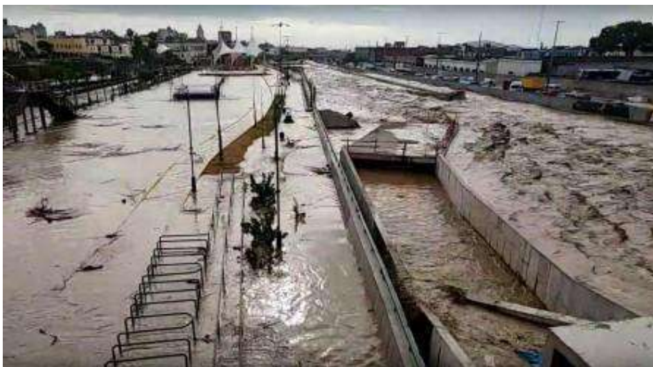
Figura 1: Parque La Muralla ubicado el centro histórico de Lima. Inundación por el desborde de las aguas del río Rímac.
