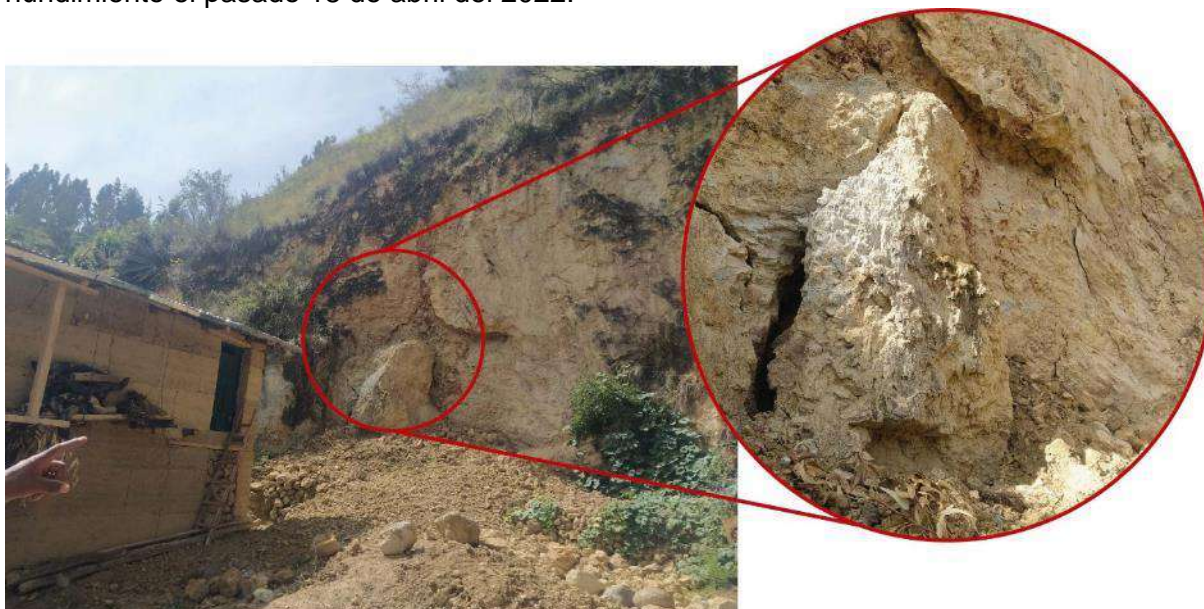
Figura 5. Afloramientos de margas, localizadas a 150 m al SE, de la coordenada principal donde se suscitó el hundimiento el pasado 18 de mayo del 2022.
