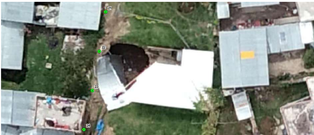
Figura 25. El Hundimiento se encuentra entre las varillas 21 y 24
