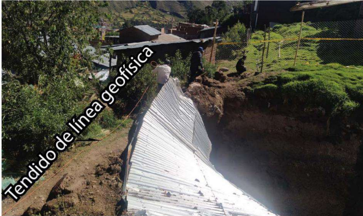
Figura 23 Tendido de la línea LT1, a 1 m del hundimiento en el barrio de Miraflores.
