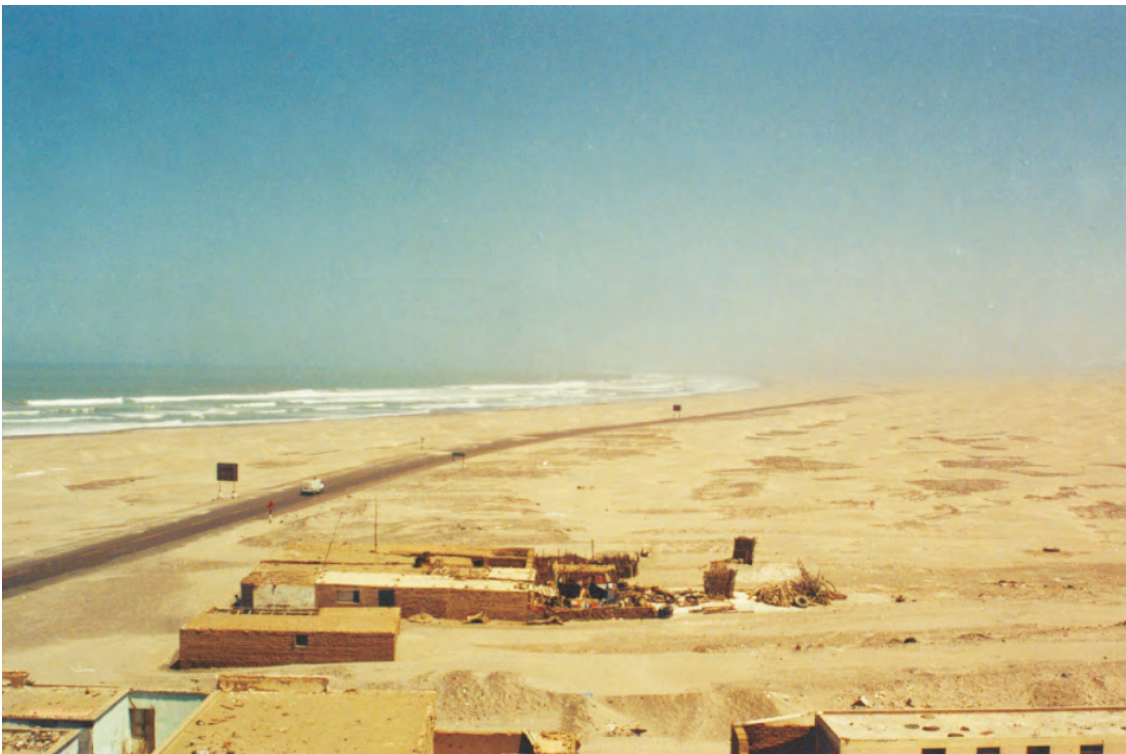
Foto N° 61 Dos vistas del proceso de arenamiento en el sector de Tanaka, que afectan tramo entre los km 571 y 576 de la Carretera Panamericana Sur
