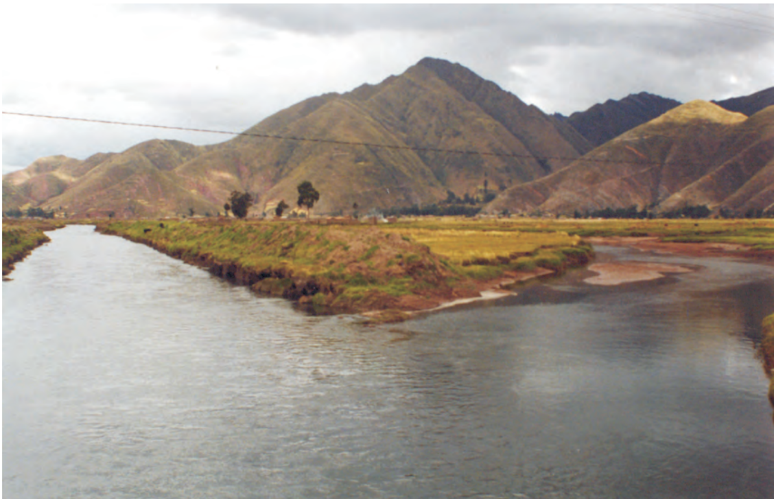
Foto N° 83 y 84 Dos vistas de áreas de inundación anual en el río Vilcanota, sectores de San Pedro (vista superior) y San Pablo (vista inferior), que inclusive llega hasta el sector de Raqchi. Compromete áreas de cultivo, áreas pobladas, carretera y línea férrea Sicuani-Cusco
