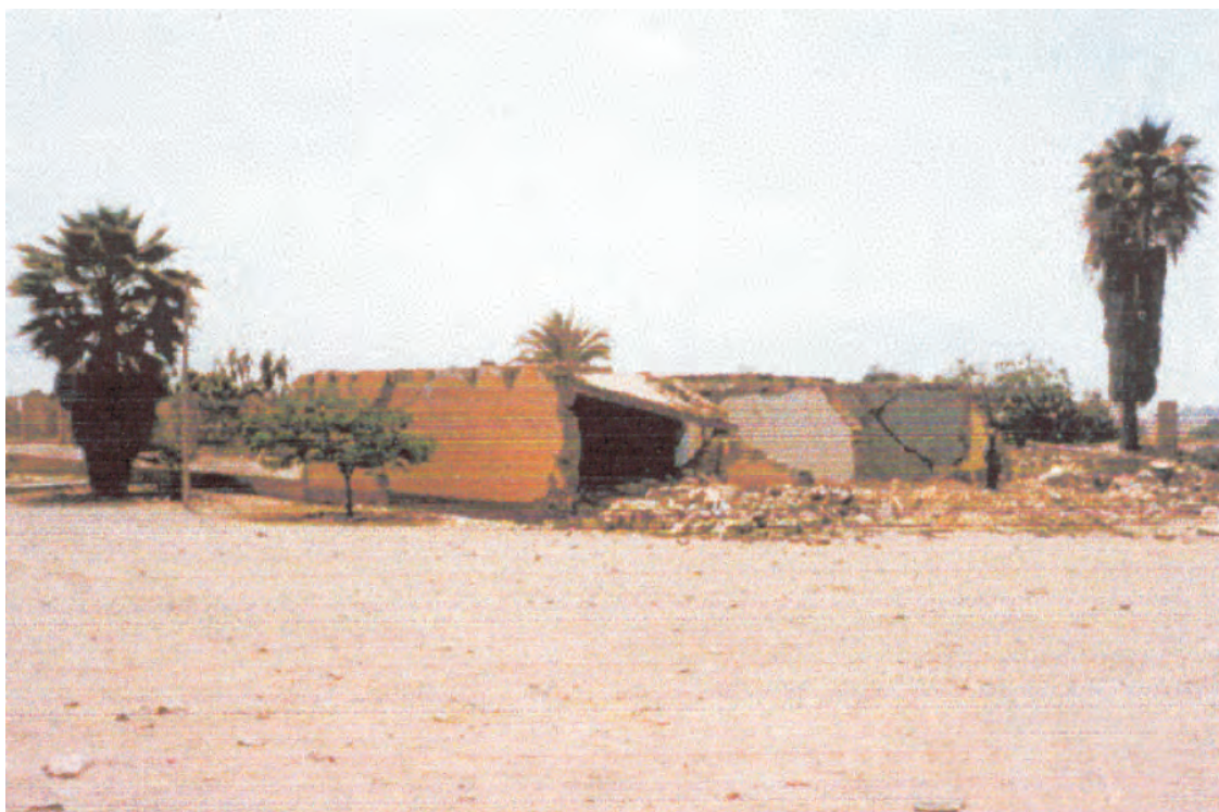
Foto N° 96 Colapso de techo y paredes de una vivienda en la localidad de Acarí Viejo; sismo de Nasca de 1996
