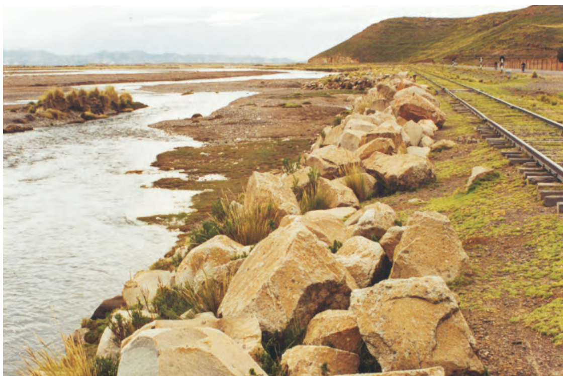
Foto N° 75 Erosión fluvial en la margen del río Cabanillas. Nótese la defensa con enrocados para la línea férrea y carretera
