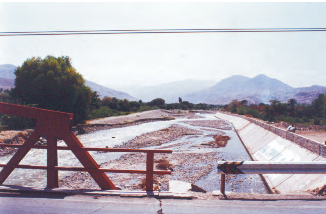
Foto N° 102 Sector Crítico N° 3. Vista superior en el puente Viscas, sobre la Carretera Panamericana Sur, defensas en ambas márgenes que en 1998 fueron rebasadas. Vista inferior, aguas abajo de puente, mostrando la falta de defensas en la margen izquierda
