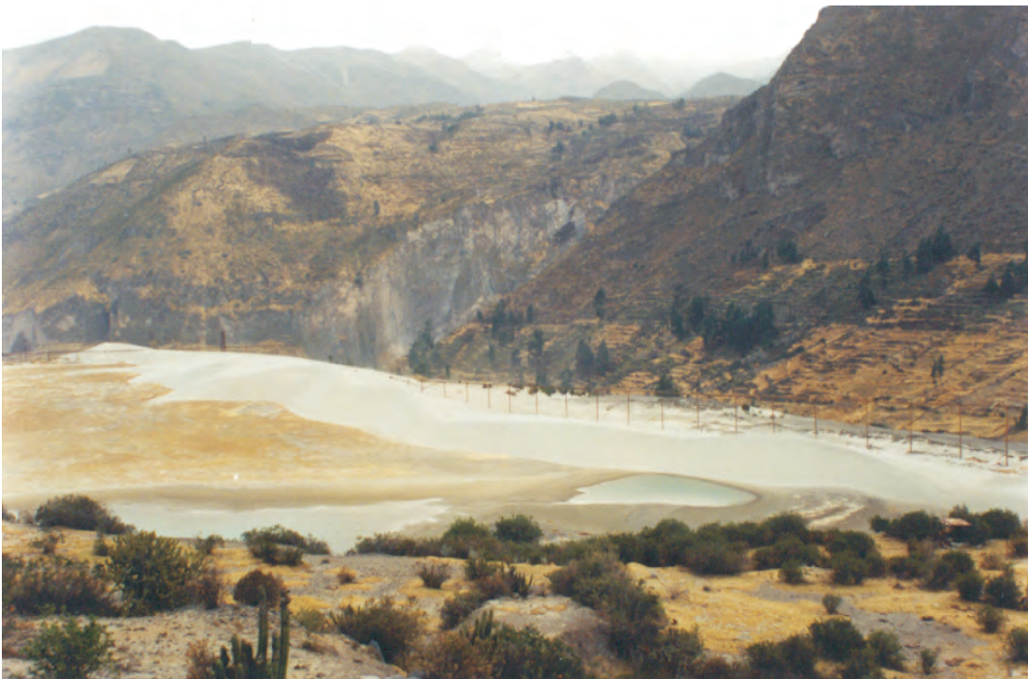
Foto N° 120 Dos vistas de los relaves de la mina Madrigal (Arequipa), que constituyen un pasivo ambiental. Nótese la formación de dunas y migración de polvo fino por acción eólica, que está afectando terrenos de cultivo. Se aprecia en los depósitos de relave, el sistema de riego abandonado
