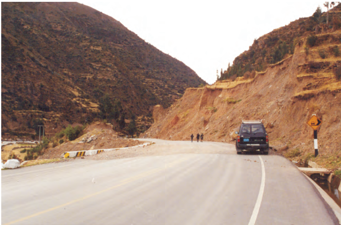
Foto N° 106 Sector Crítico N° 17. Derrumbes en rocas muy fracturadas y meteorizadas en ambas márgenes del río Promesa, sectores Pucaruni (arriba) y Ampayapampa (abajo)
