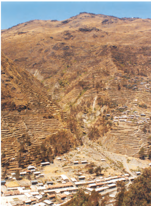
Foto N° 111B Sector Crítico N° 32. Carretera Cuyo Cuyo-Sandia
