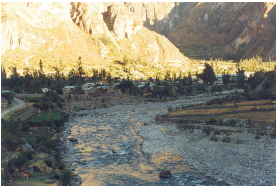
Foto N° 76 Erosión fluvial en la margen derecha del río Huarcaya, que compromete al sector inferior de poblado de Alca (Cotahuasi). Se han colocado muros de enrocado y arrimado de material con tractor como defensas
