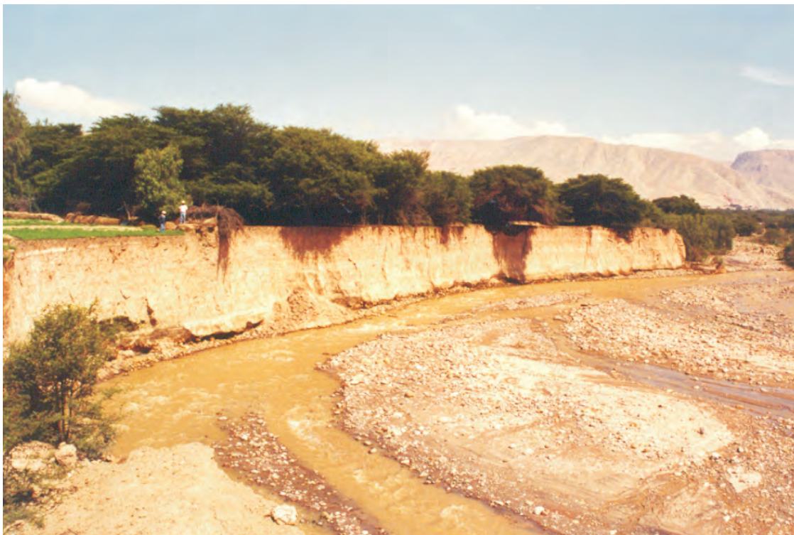
Foto N° 70 Erosión fluvial en la margen derecha del río Caravelí, sector La Zanja, que afecta terrenos de cultivo
