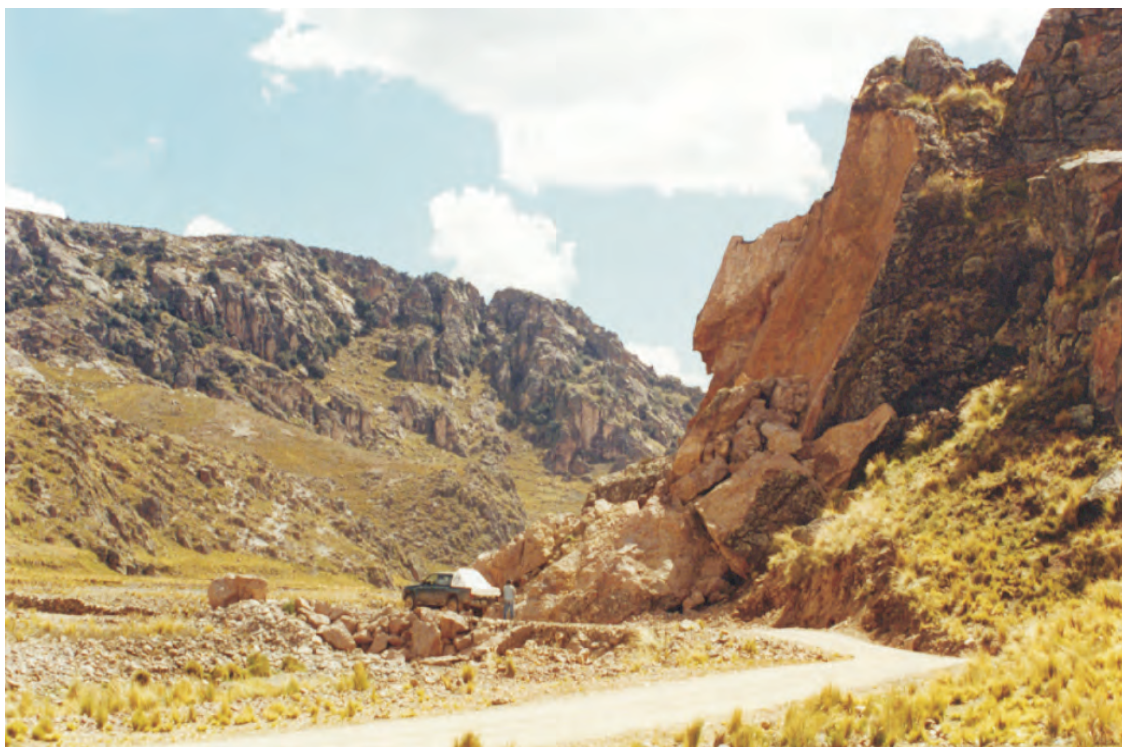
Foto N° 33 Carretera Palca-Vila Vila (sector de Ocuvi). Derrumbe en rocas fracturadas y alteradas
