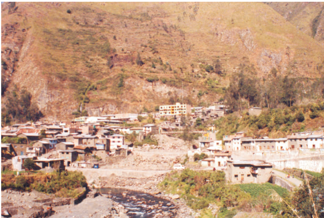
Foto N° 49 Huayco ocasional que afecta poblado de Sandia
