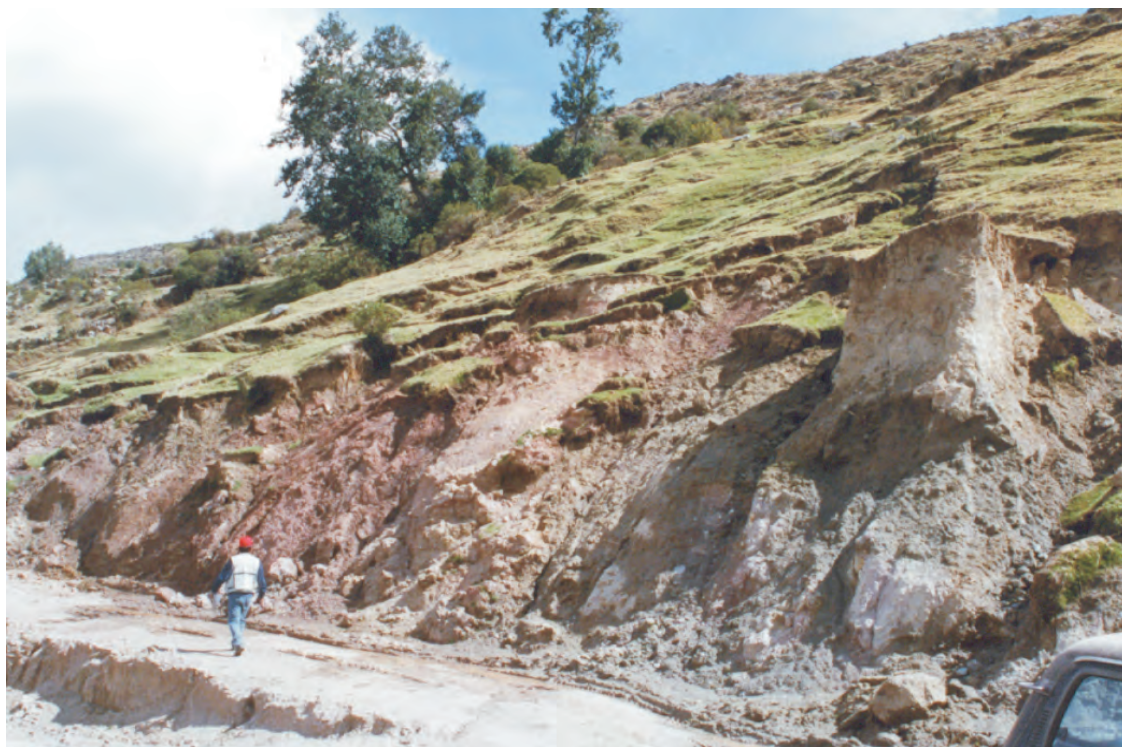
Foto N° 54 Reptación de suelos arenociliosos saturados; afecta tramo de carretera a Sañayca
