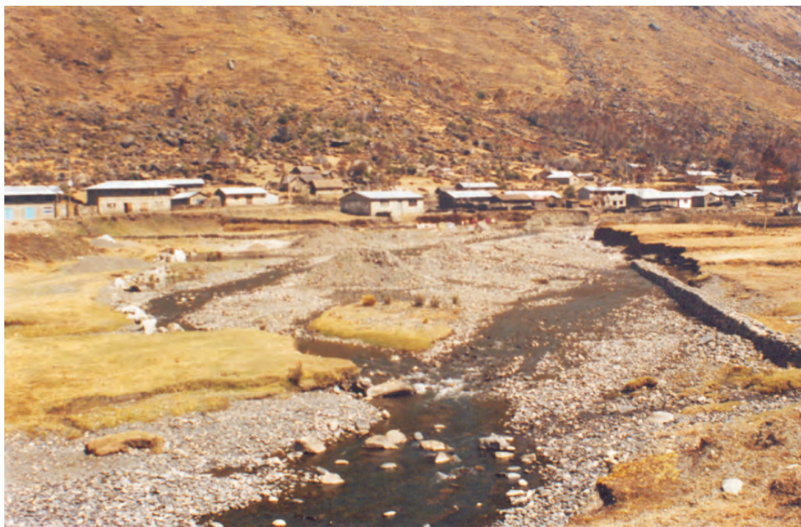
Foto N° 77 Erosión fluvial en ambas márgenes del río Huancasayani, que compromete al poblado del mismo nombre
