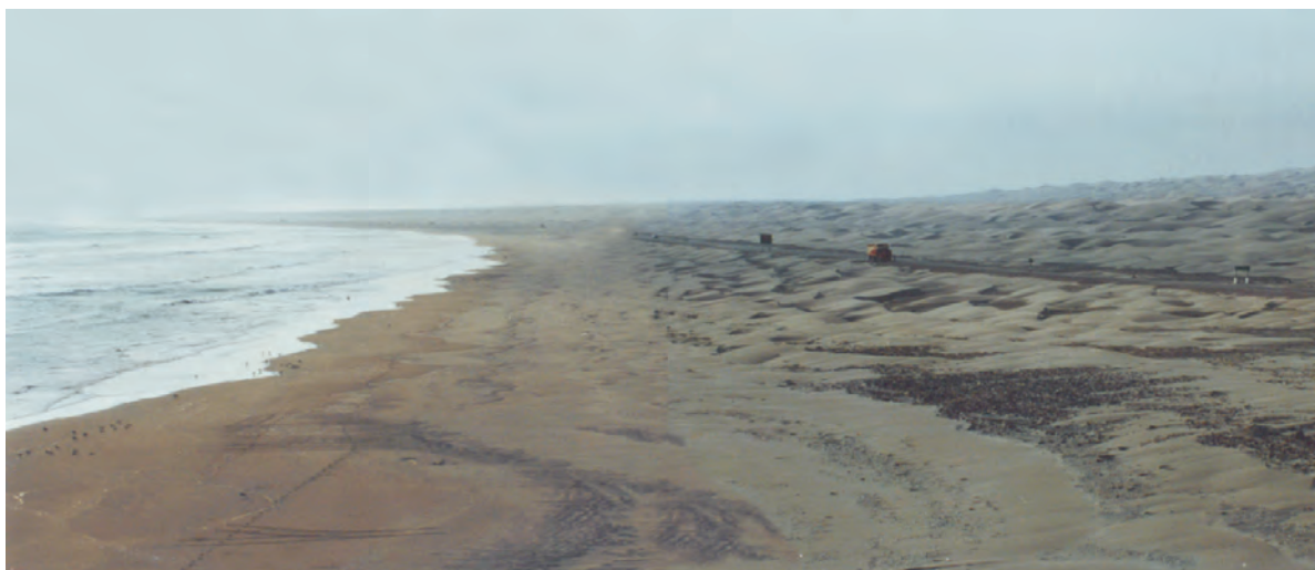
Foto N° 4 Unidad localizada de Depósitos eólicos (DE) , sector de Tanaca, forma una zona de arenamiento en el tramo de la Carretera Panamericana Sur
