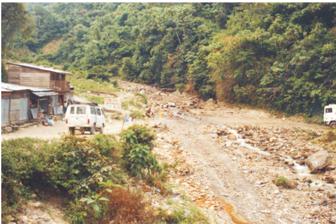
Foto N° 50 Huayco en la quebrada Camarón, afluente del río Sandia (Huari Huari)
