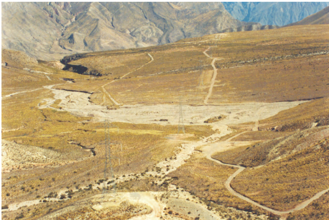
Foto N° 43 Huayco en quebrada Mulapampa (ocasional a excepcional); corta trocha de acceso a torres de alta tensión, sector Huambo-Lluta; aguas abajo afectó al puente sobre la carretera Alto Sihuas-Huambo
