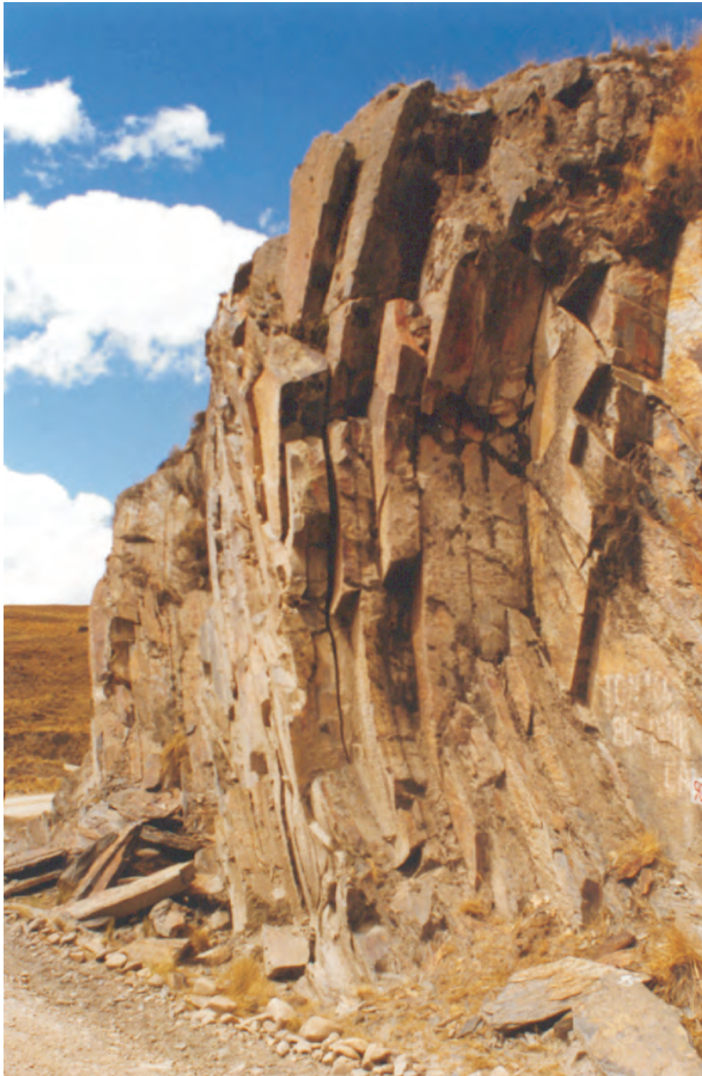
Foto N° 34 Ejemplo de vuelco de estratos en areniscas de la Formación Sandia; carretera Putina - Ananea (km 63+900)
