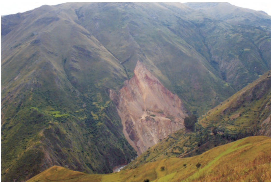
Foto N° 30 Vista de una zona de derrumbe en el cerro Labrasniyoc, ocurrido en el verano del 2001; represó el río Trapiche
