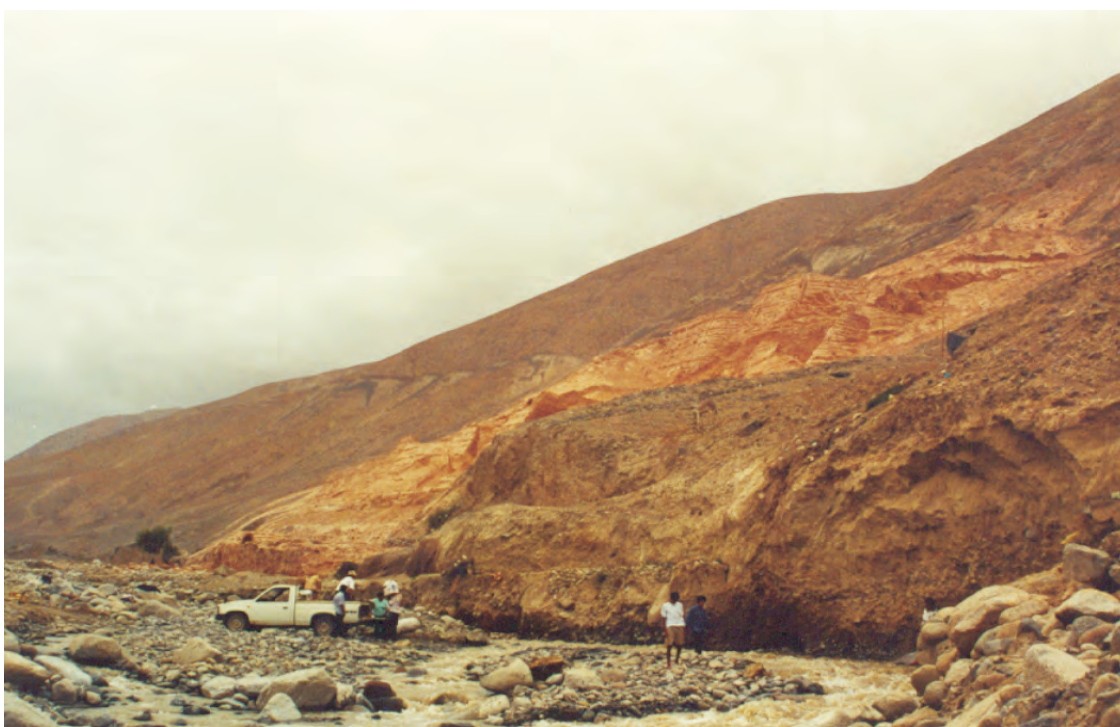
Foto N° 116 Depósitos de relaves antiguos del asiento minero La Capitana, ubicados en la margen izquierda de la quebrada Charpa (Ayacucho), sujetos a erosión fluvial y a contaminación de las aguas de la quebrada.
