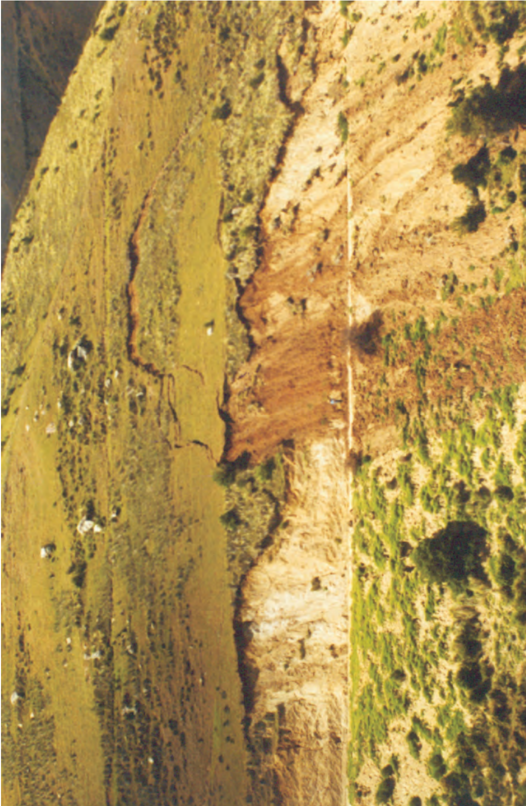
Foto N° 109 Parte del Sector Crítico N° 24, carretera Santo Tomás-Cápacmarca-Cusco. Derrumbes y deslizamientos en los taludes de la carretera
