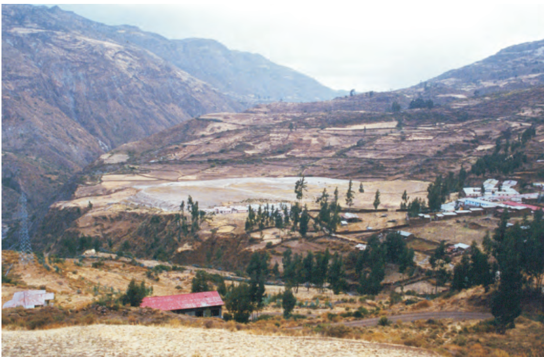
Foto N° 119 Relaves de la mina Santa Catalina, actualmente en poder de la compañía Río Azul, localidad de Utec, cerca de Puquio (Ayacucho), pasivo ambiental ubicado cerca de áreas agrícolas
