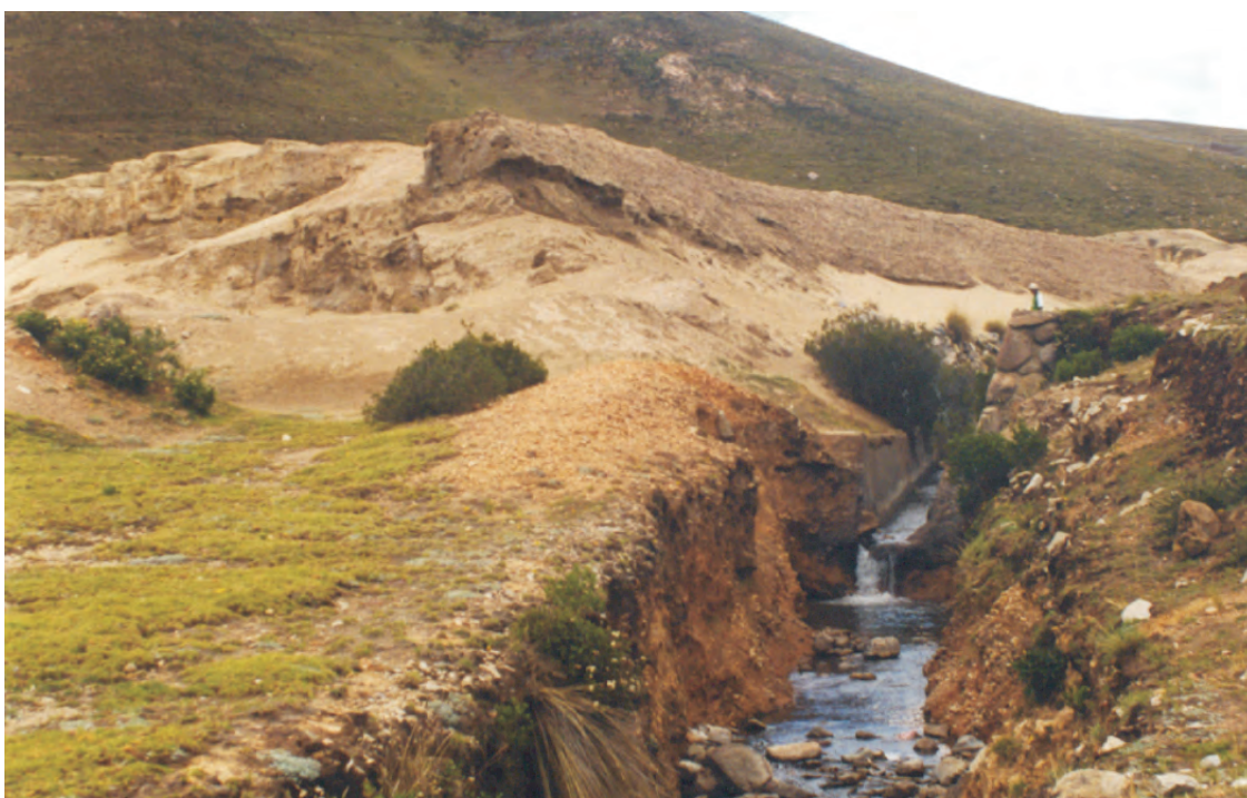
Foto N° 122 Pasivo ambiental en la mina Katanga, trabajada a tajo abierto (skarn de Cu-Fe), en la hoja de Livitaca. Mina abandonada, donde se aprecian depósitos de relaves abandonados. En la vista inferior, canal y muro de mampostería de piedra en el borde del relave, para el escurrimiento de aguas superficiales, margen izquierda de la quebrada Sacrane. No existe protección para aguas pluviales y acción eólica
