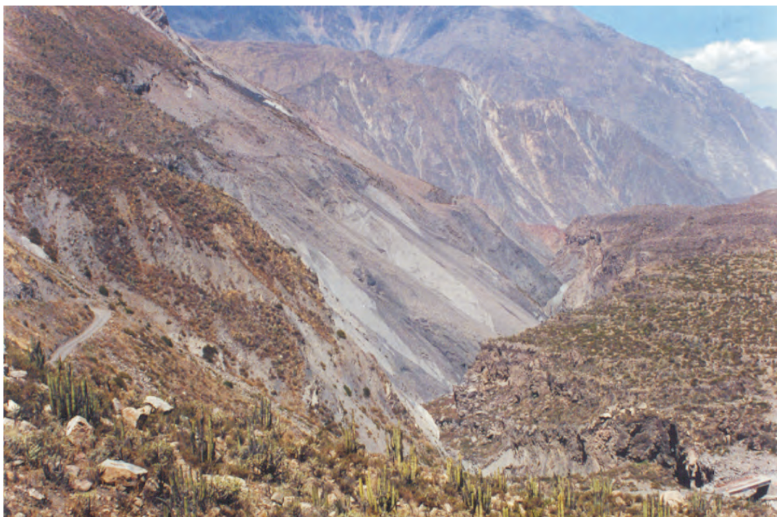
Foto N° 31 Derrumbe en el cerro Jollevirca (entre Andahua y Chachas), en la margen izquierda del río Challahuire. Inestabilidad de taludes, rocas incompetentes (Grupo Yura); zona activa
