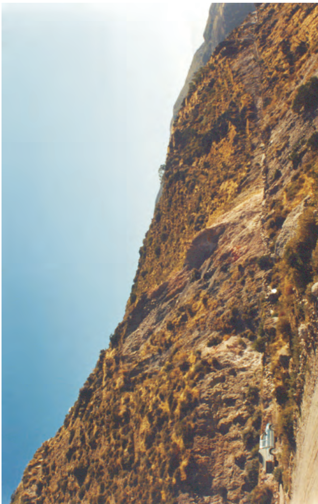
Foto N° 105 Zona de derrumbes en la carretera a Salamanca, taludes muy inestables en desarrollo de carretera. Sector Crítico N° 15
