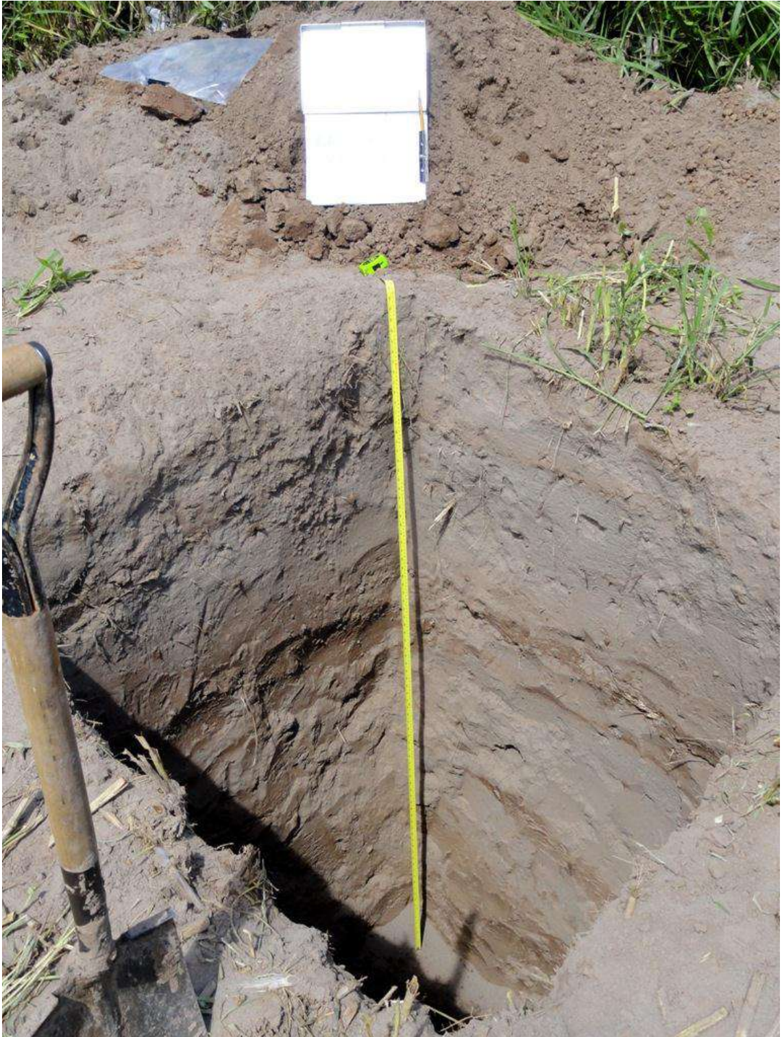
Figura 28.- Calicata N° 4 Deposito Arcillo areno limoso. Margen Izquierda al Oeste de Saposoa (cerca al Estadio).
