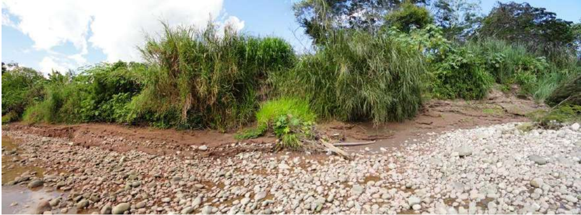
Figura 19.- Vista de la margen izquierda de la ribera erosionada al oeste de Saposoá por la altura del estadio.
