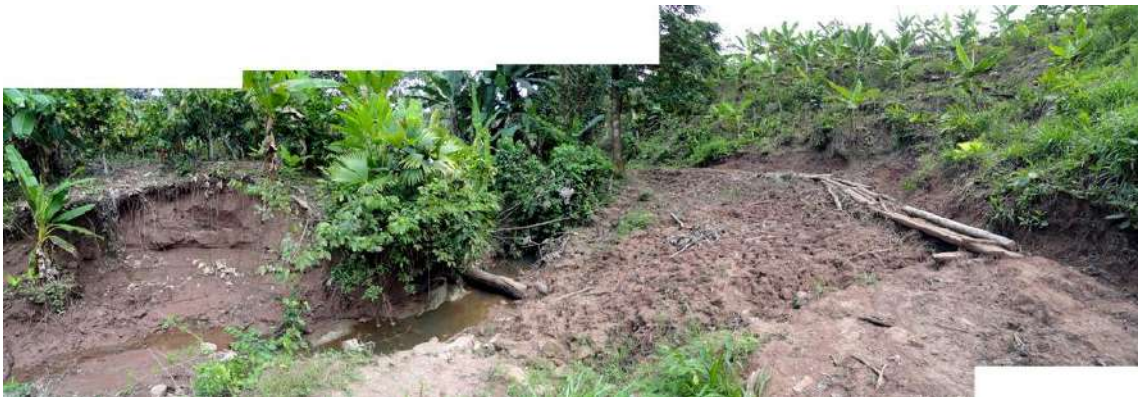
Figura 21.- Vista del micro deslizamiento causado por la inundación del río sobre esta terraza, así como por la deforestación de la ladera por cultivo de plátanos.
