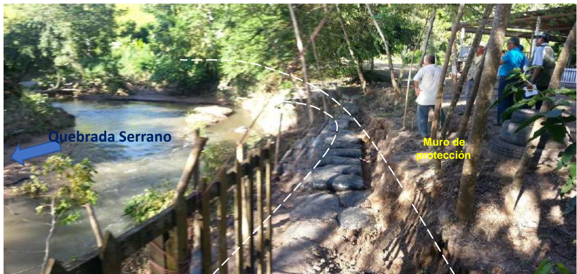
Figura 35. Centro poblado en riesgo por inundación.
