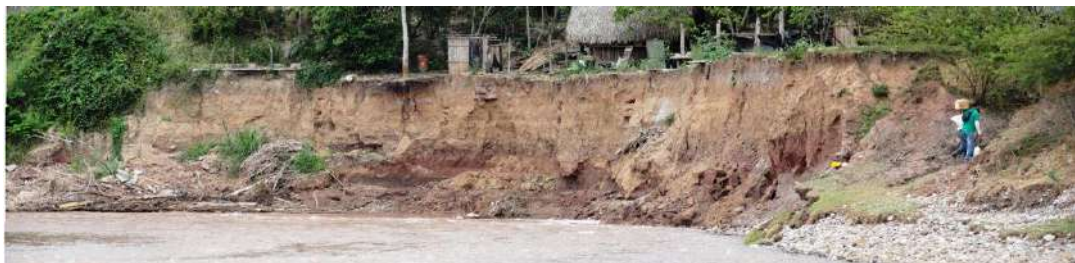
Figura N° 3.- Vista de la margen derecha del río Saposo mirando a la localidad de Santa Isabel – pasando Sacanche, igualmente podemos apreciar la terraza alta con fuerte erosión ribereña que la ha escarpado compuesta por suelos finos de color marrón matiz rojiza a beige, así como los depósitos gravosos al pie.
