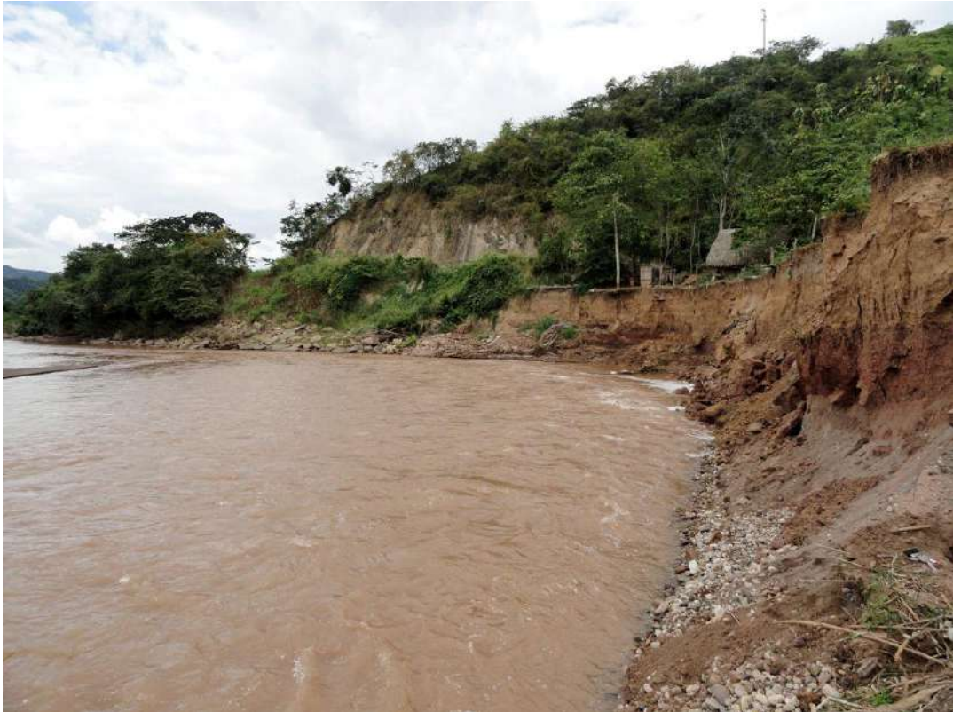
Figura 14.- Vista de la fuerte erosión de la ribera con desplomes en la zona de Santa Isabel pasando la localidad de Sacanche, que está poniendo en peligro una vivienda. Margen derecha.
