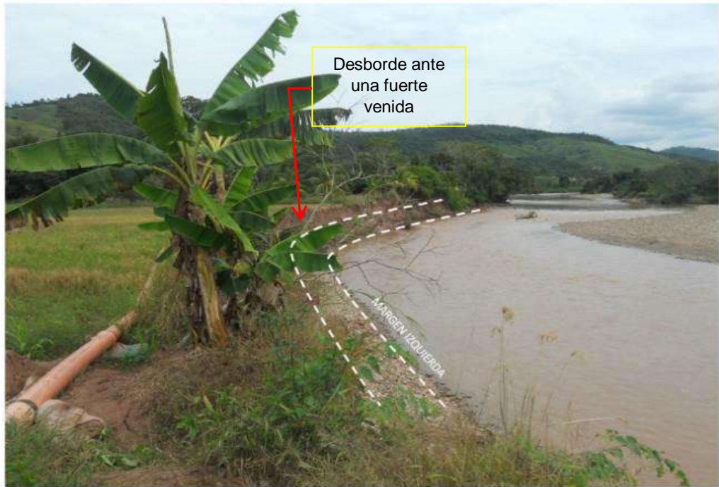
Figura 24. Áreas agrícolas con riesgo de inundación, sector Lechería
