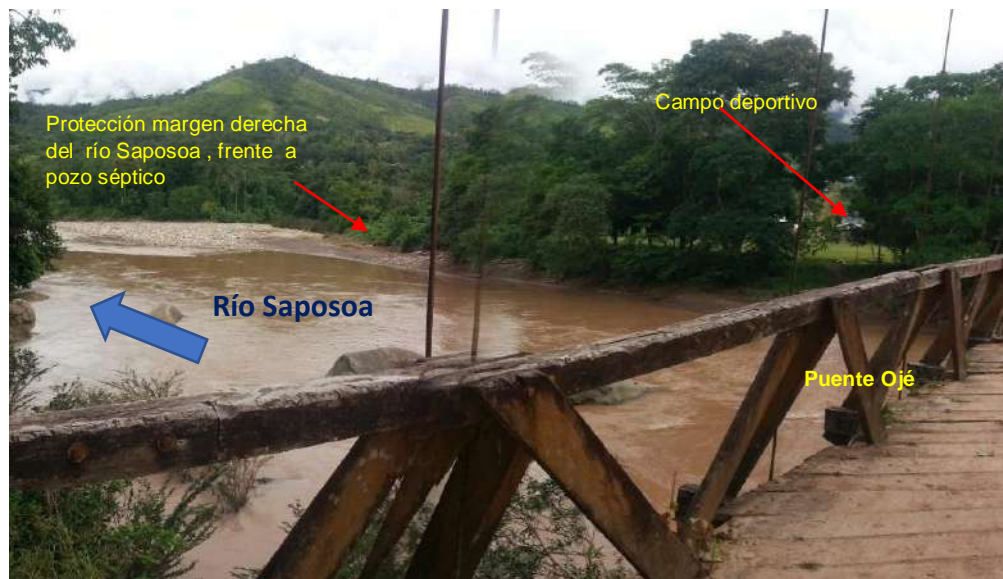
Figura 37. Centro poblado en riesgo por inundación, margen derecho Río Saposoa.
