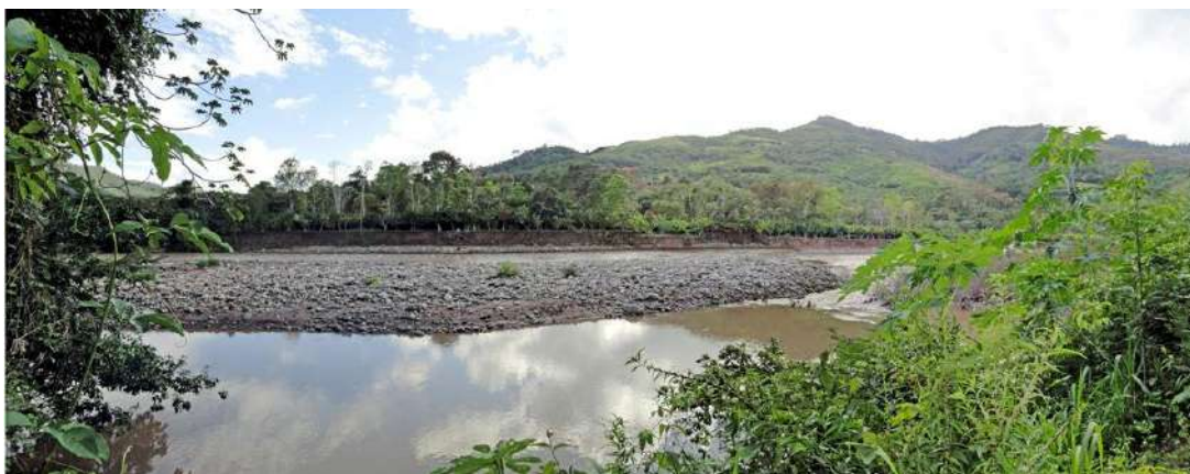
Figura 16.- Vista panorámica de la ribera izquierda y terraza baja frente al poblado de Pasarraya, donde podemos observar que la erosión y desplome que está afectando terrenos de cultivo.
