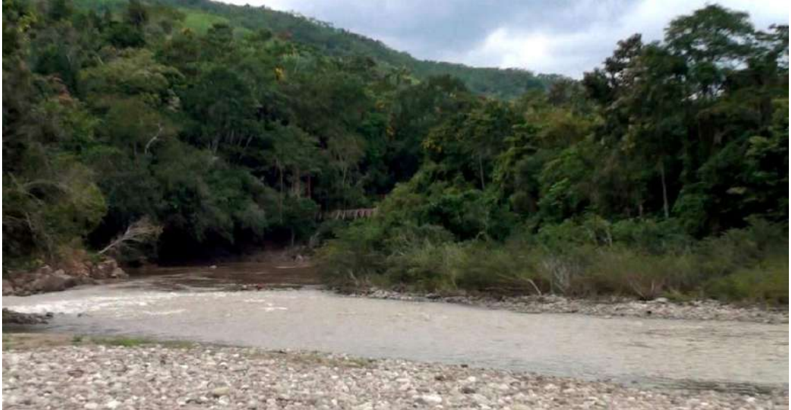
Figura 11.- Vista de la colina estructural de la margen derecha del puente de Pasarraya, el estribo derecho está cimentado en la roca de la Formación Ipururo.
