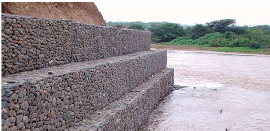
Figura N° 2. Muros de defensa con gaviones. Foto Analex.
