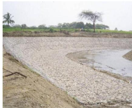
Fotografía 06. Muro de colchones antisocavantes
