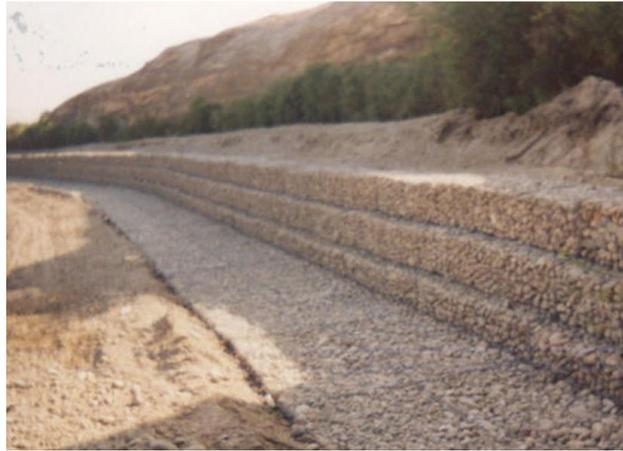
Fotografía N° 05 Muro de gaviones
