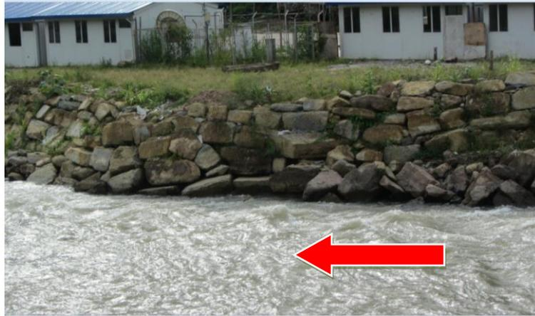
Fotografía 16. Defensas ribereñas mal construidas (sin uña de cimentación) en el cauce
