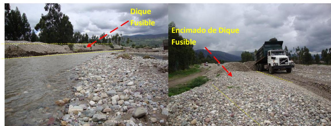
Figura 29: Conformación de dique fusible
