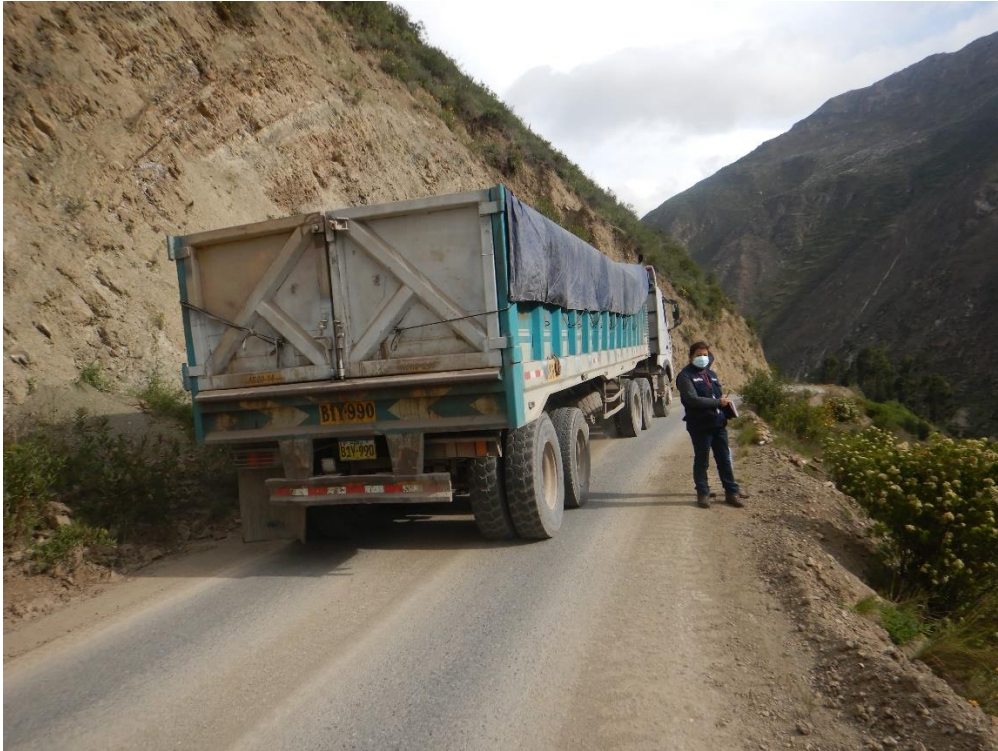
Figura 21. Tránsito de vehículos pesados que circula por la vía afectada con restricciones para otros vehículos mientras continua rehabilitación de la vía.
