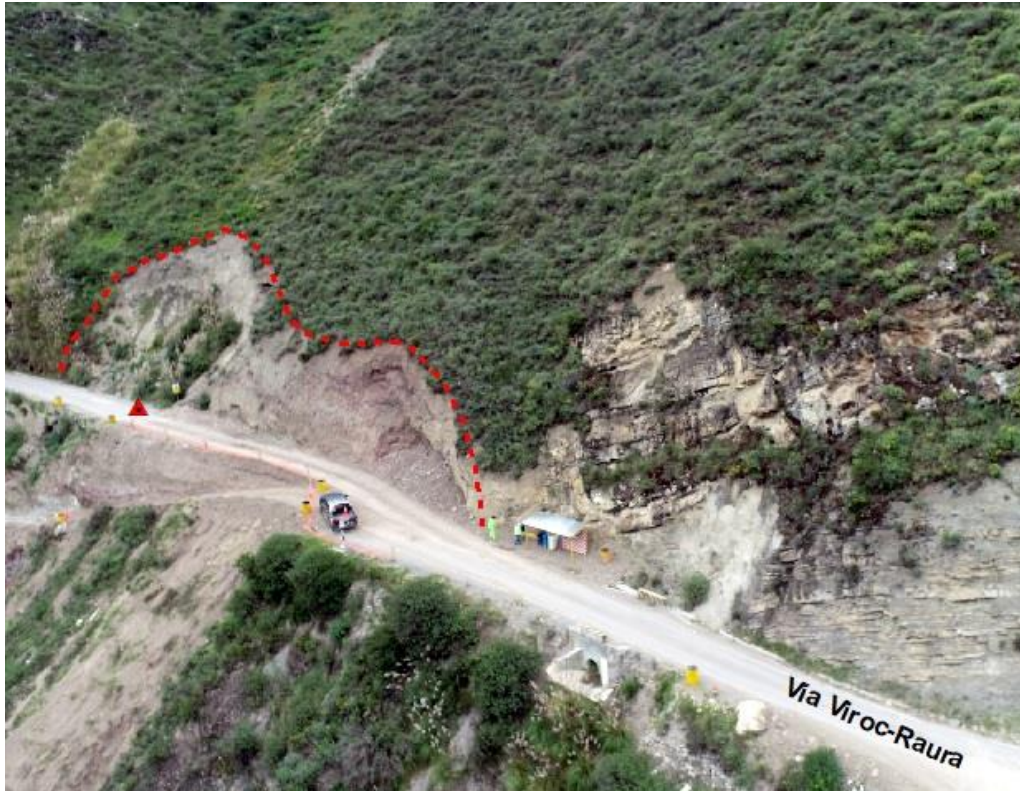
Figura 19. De acuerdo a las características litológicas en el sector, conformada por areniscas y limoarcillitas a lo largo de la vía, se considera como un estrato de regular a mala calidad, presentando una alta meteorización y muy alto fracturamiento en el estrato rocoso, característica que se repite en otros tramos del trazo de carretera.
