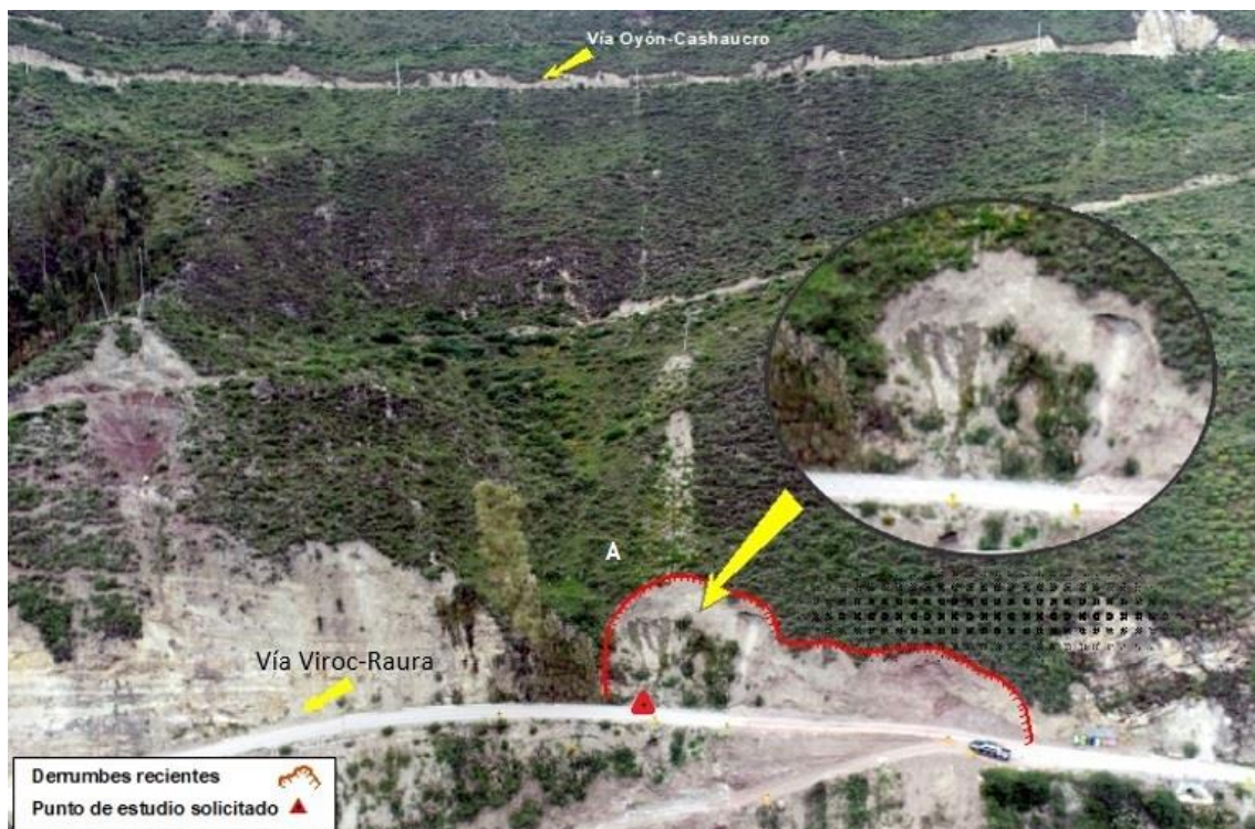
Figura 16. Vista de derrumbe ocurrido en diciembre del 2021, se encuentran ubicado sobre la vía Oyón-Raura, en la margen izquierda del río Quichas, presenta una extensión de 64 m. y altura de 18 m.
