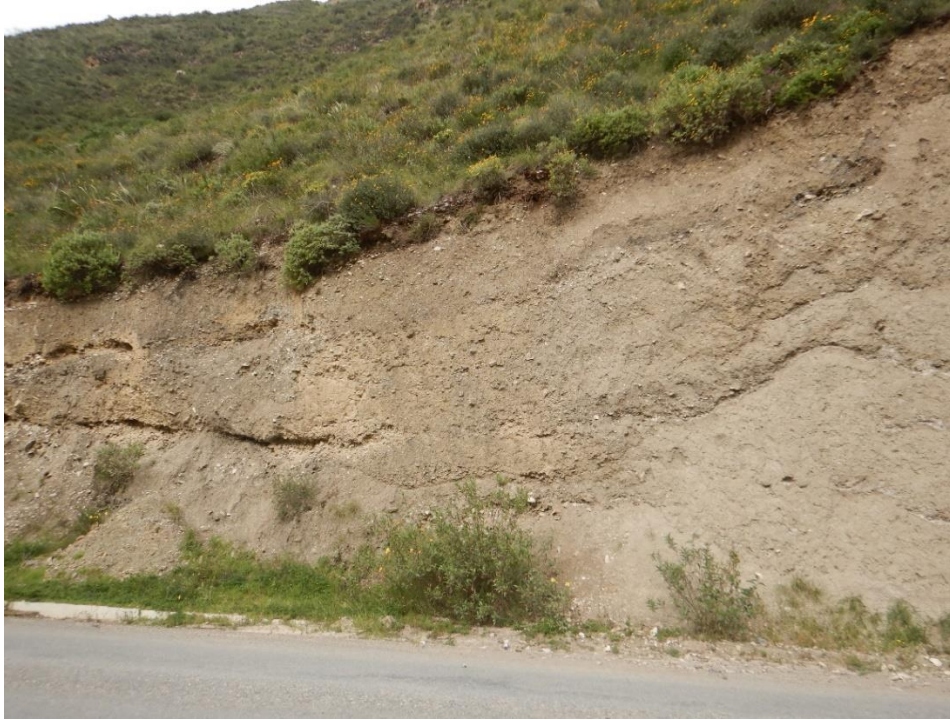
Figura 9. Material del depósito coluvio-deluvial compuesto por fragmentos de roca anguloso a subangulosos de tamaños variables, envueltos en una matriz limo-arcilloso.
