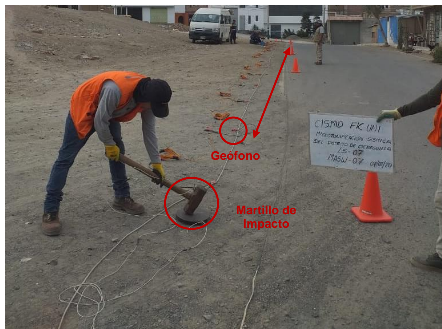
Figura 7.7. Equipo utilizado para la ejecución del ensayo MASW en el distrito de Cieneguilla
