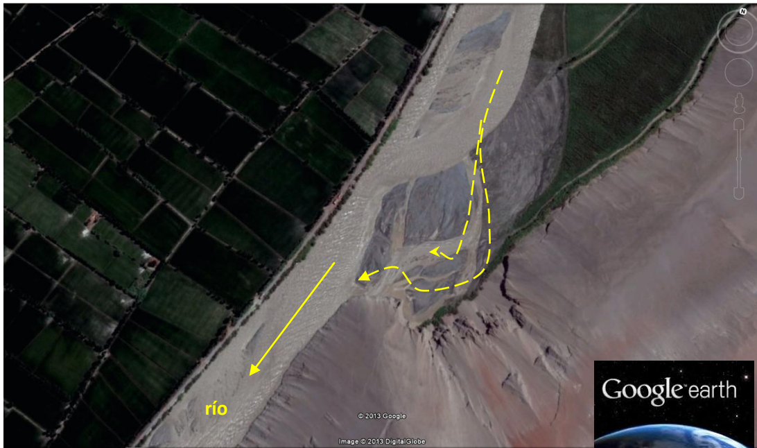
Fotografía N° 19 Sector Tuco que viene siendo erosionado
