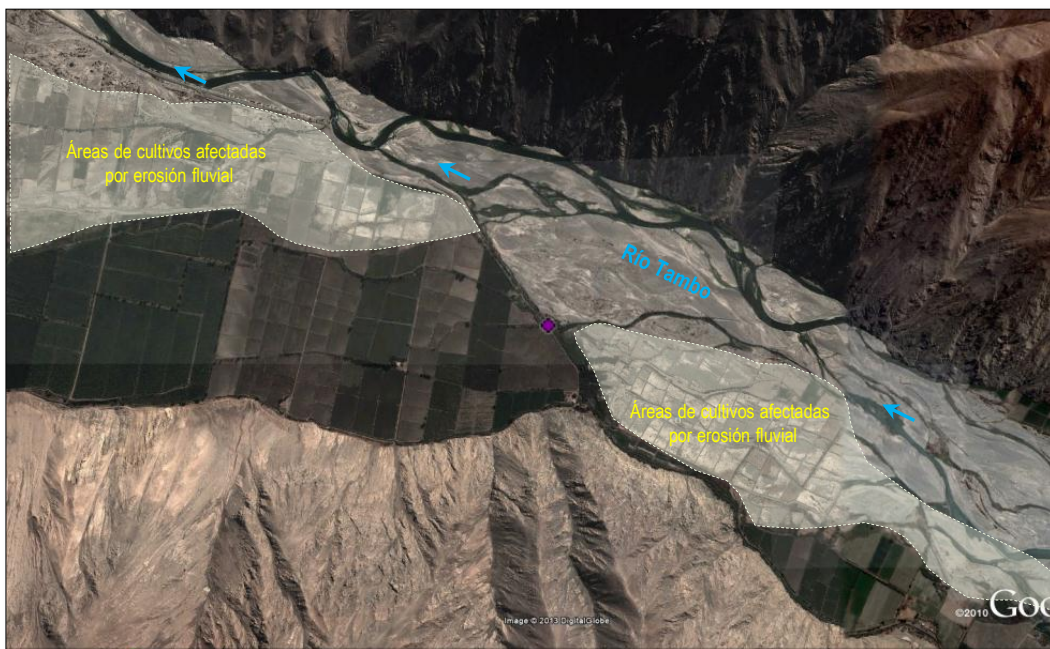
Foto N° 06: Sector Bocatoma Checa, se observan áreas de cultivos afectadas por inundaciones fluviales en la margen izquierda del río Tambo.
