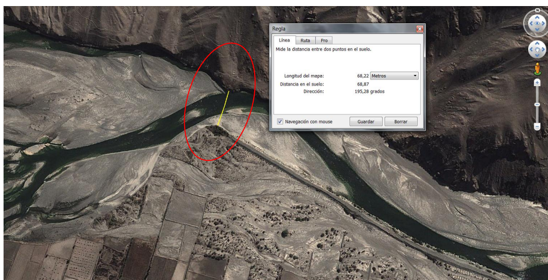
Figura 17. Defensas ribereñas mal ubicadas en el cauce Fuente: Google Earth
