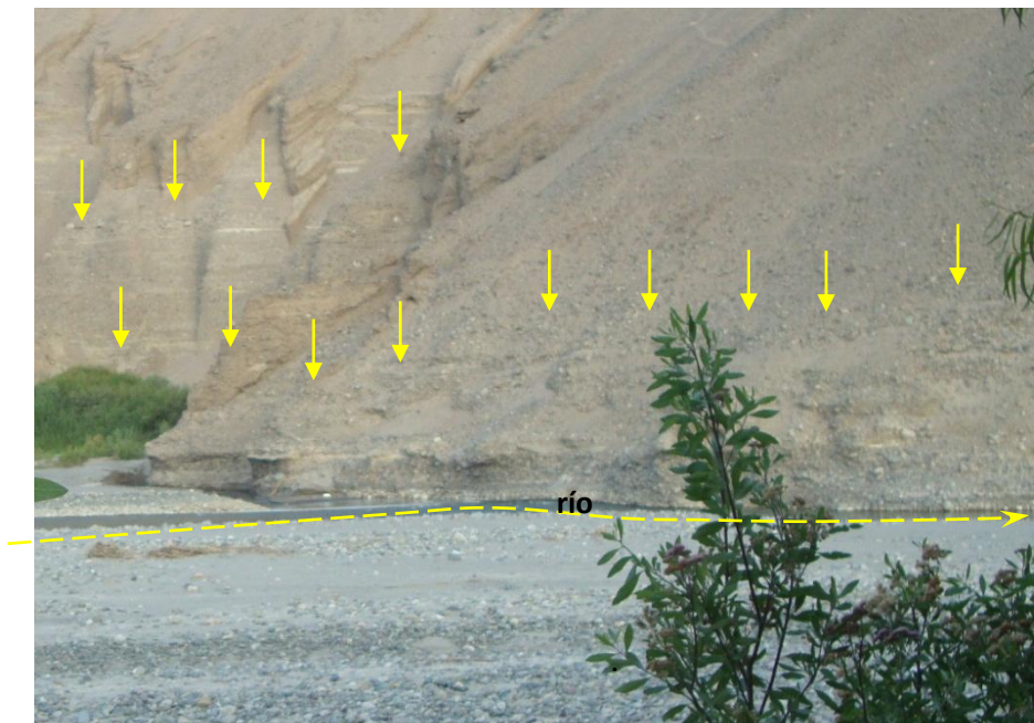
Fotografía N° 20 Sector Tuco que viene siendo erosionado
