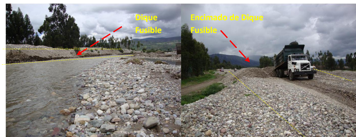
Figura 29: Conformación de dique fusible
