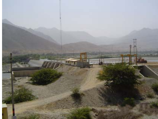
Figura 4. Bocatoma La Huaca
