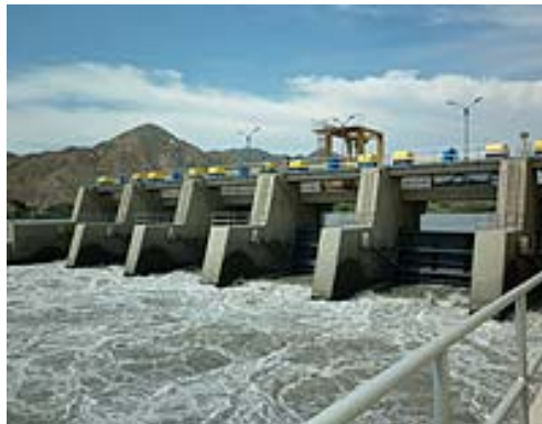
Figura 5. Bocatoma La Víbora
