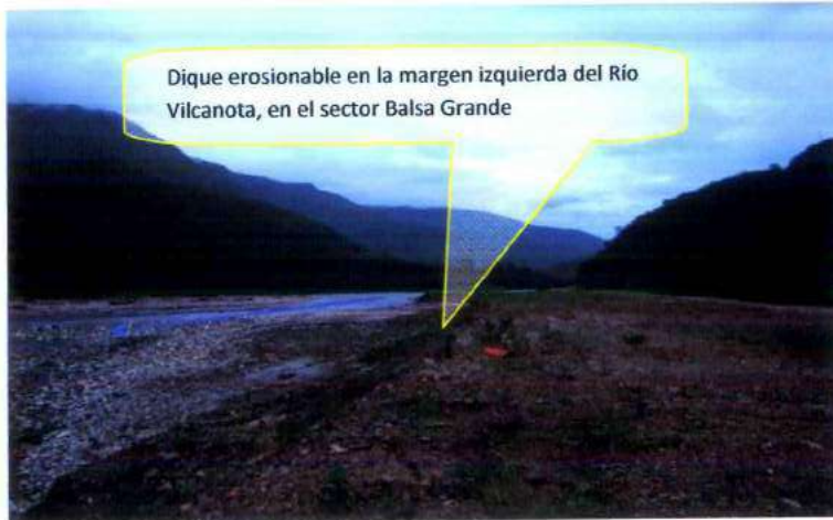
Foto. Riesgo de erosión de dique en la margen izquierda del río Vilcanota, aprox. 1000 aguas arriba del centro poblado de Quillabamba.
