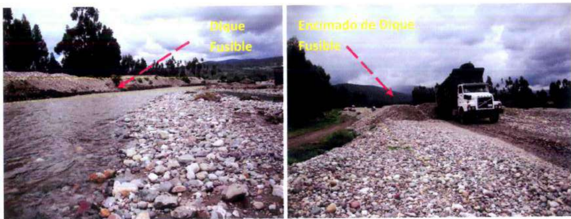
Figura Nº 25. Conformación de dique fusible
