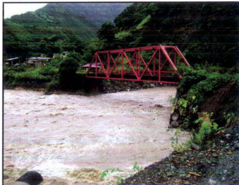
Foto N° 05 Puente Santa María
