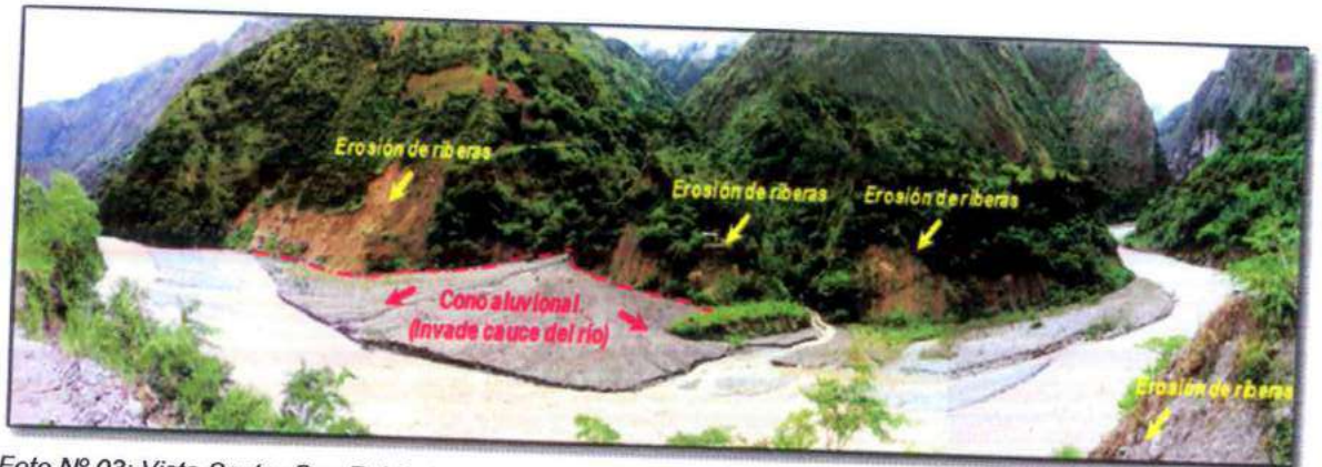
Foto N° 03: Vista Sector San Pablo (margen izquierda), se observa la erosión de riberas y cono aluvional invadiendo el cauce del río Vilcanota.
