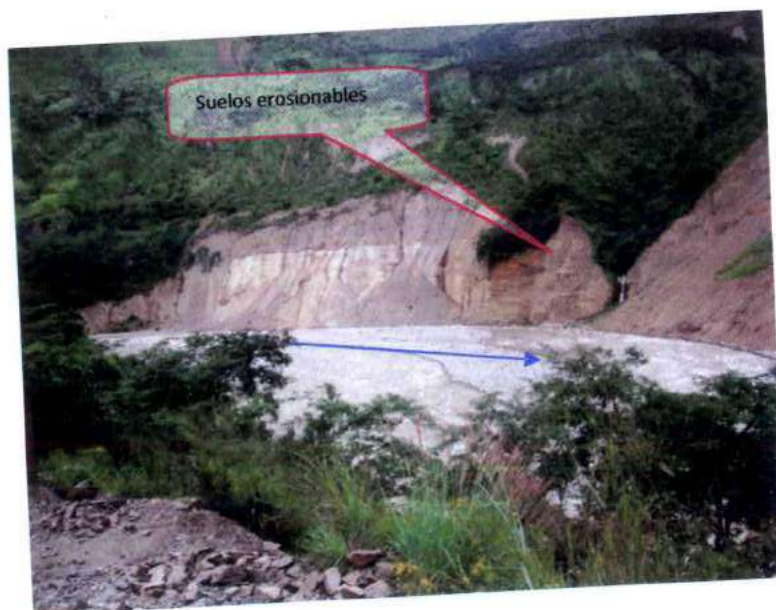
Foto. Riesgo de erosión en la margen izquierda del río Vilcanota, aprox. 100 aguas abajo del centro poblado de Santa María.
