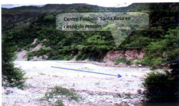
Foto. Riesgo de erosión en el centro Poblado de Santa Rosa, ubicado a la margen izquierda del río Vilcanota
