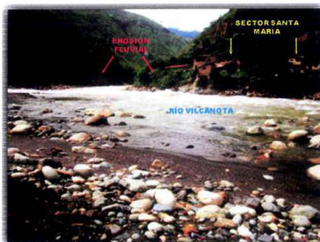
Foto N° 06: Vista Sector Santa María, se observan la erosión de riberas en ambas márgenes del río Vilcanota.
