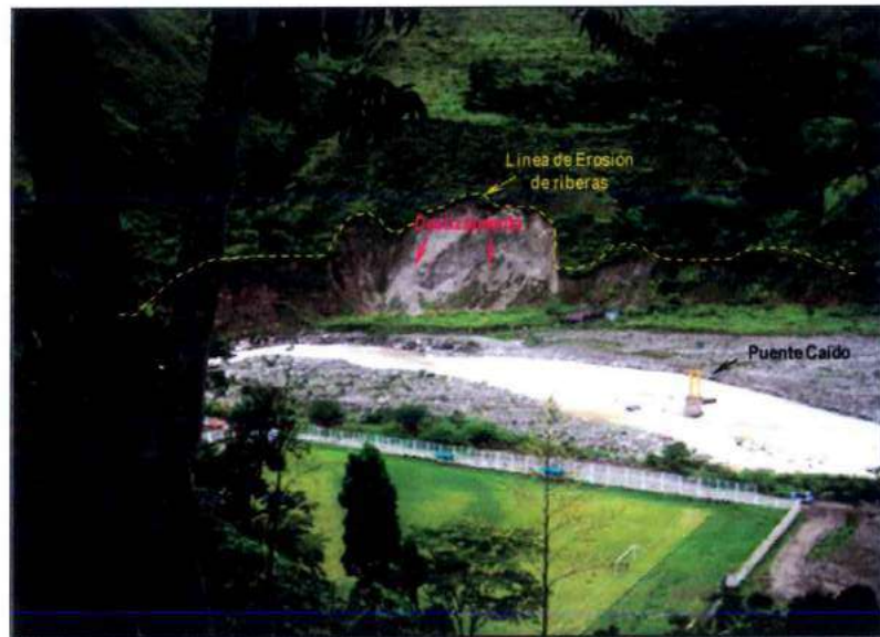
Foto N° 02: Vista Sector Puente Caído, los peligros geológicos en la zona corresponden a erosión de riberas y pequeños deslizamientos.
