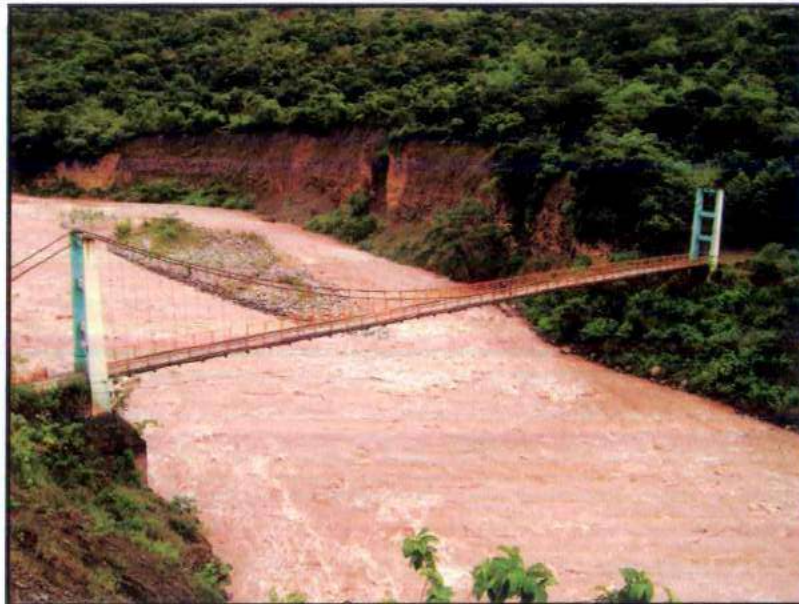
Foto N° 04 Puente San Pablo
