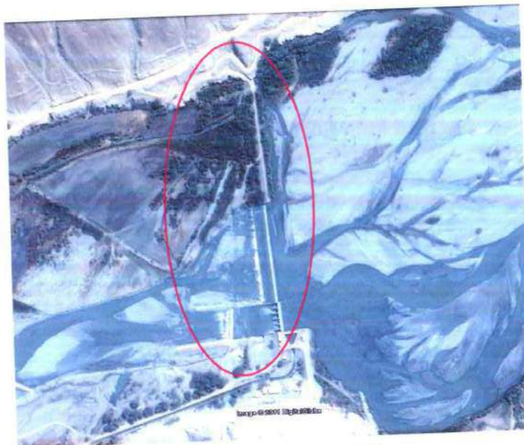
Figura N° 11. Existencia de estructuras hidráulicas Fuente: Google Earth
