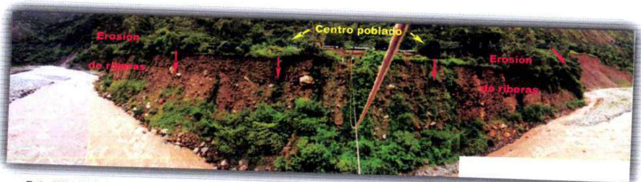
Foto N° 04: Vista Sector San Pablo se observa la erosión de riberas hacia la margen derecha del río Vilcanota.
