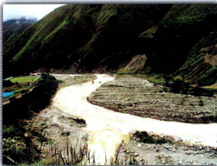
Foto N° 04: Erosión fluvial en el sector de Santa Teresa
