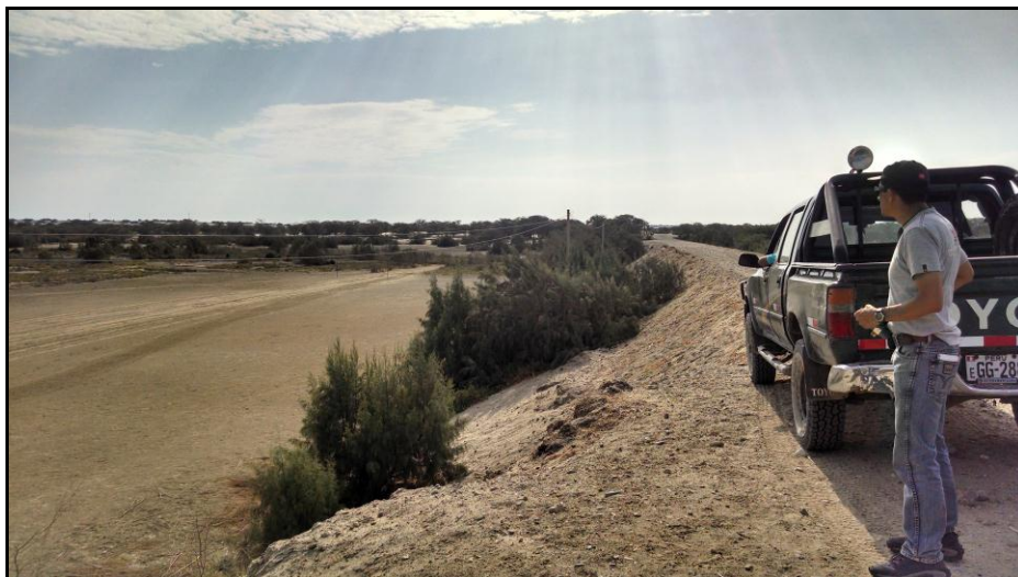
Foto 3 - Desborde por encima del dique de tierra, carretera Panamericana Norte en riesgo por inundación "Sector Chato Chico"
