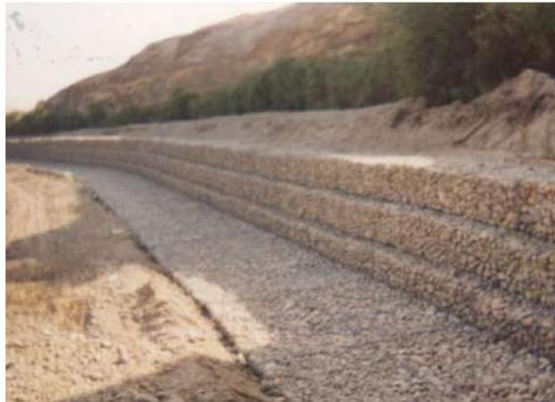
Fotografía N° 05 Muro de gaviones
