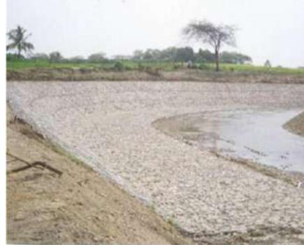
Fotografía N° 06 Muro de colchones antisocavantes
