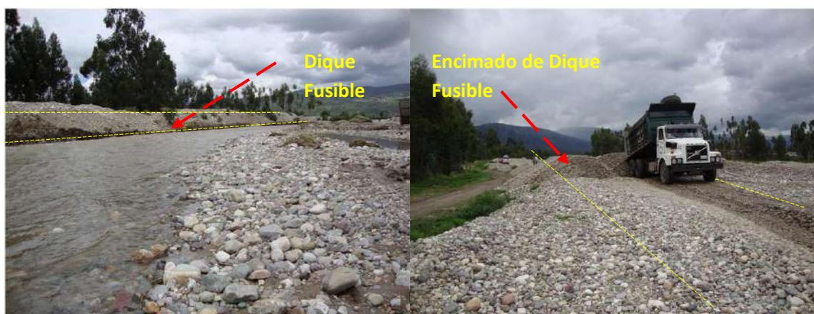
Foto 10: Conformación de dique fusible
