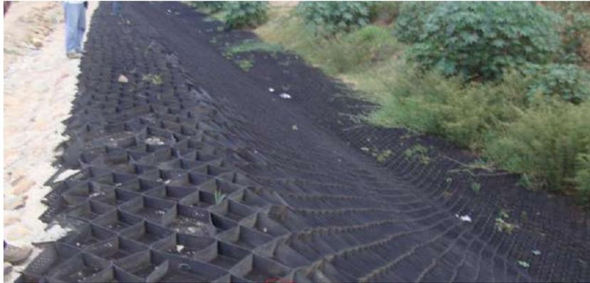
Fotografía N° 08 Muro de colchones antisocavantes
