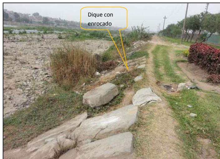
Figura 23. Dique con enrocado, margen derecha, sector Bocatoma Atarjea-Puente Huachipa
