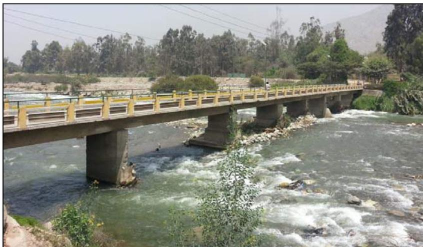
Figura 17. Puente expuesto a erosión y socavación
