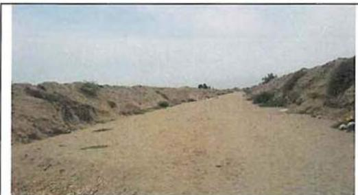
Foto 34: Fondo de la sección hidráulica con importante grado de colmatación.
