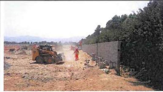
Foto 19: Construcción de cerco perimétrico, adyacente a ruta de alternativa.
