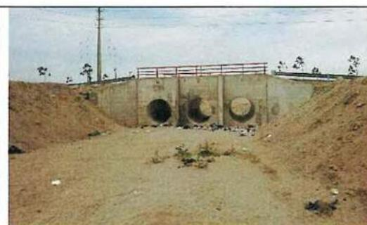
Foto 38: Alcantarilla recientemente construida sobre el cauce sur.
