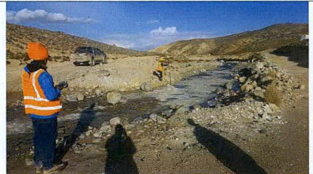
Foto 21: Identificación del cauce y ribera de la margen izquierda del río Azufre en zona crítica de inundación. Progresiva 0+660 km.
