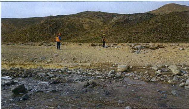
Foto 24: Levantamiento de bordos superiores, margen derecha del río Azufre (0+000 km – 0+400 km).
