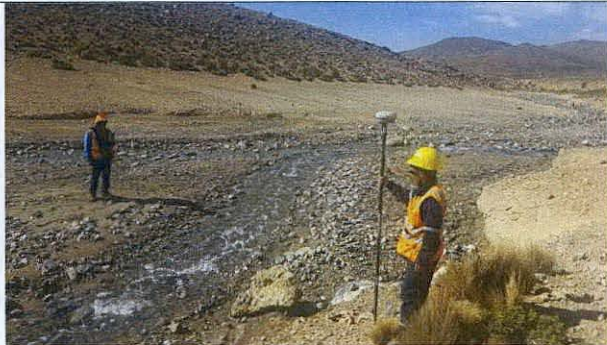
Foto 18: Supervisión del levantamiento de sección margen derecha del Río Azufre (Km 1+930)
