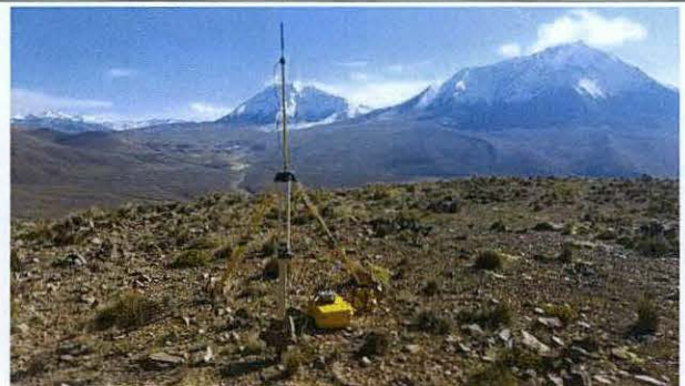
Foto 4: Segundo Punto de Instalación de Repetidora.
