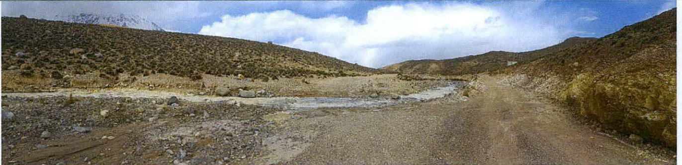
Foto 11: Tramo crítico de inundación en la intersección de caminos de acceso y el río azufre (Km 0+640 hasta Km 0+780)
