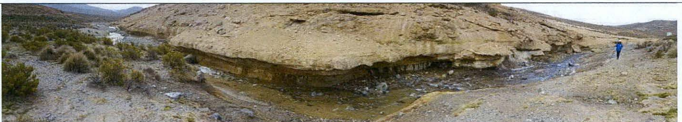
Foto 12: Tramo aproximado de 180 m. donde la huella máxima de inundación se ubica por debajo de una formación rocosa volcánica en la margen izquierda del río Azufre. (Km 1+070 hasta Km 1+250)
