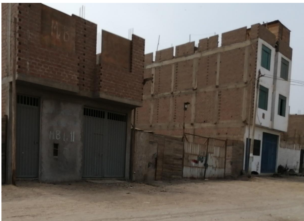
Foto N°19.- Edificaciones de la Mz B lote 11 de material noble, lotes 9 y 10 terrenos cercado y lote 8 construcción de 3 pisos de material noble.
