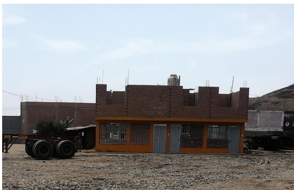
Foto N° 9. Vivienda de material noble con techo de concreto armado de 1 piso. Mz B lote 10
