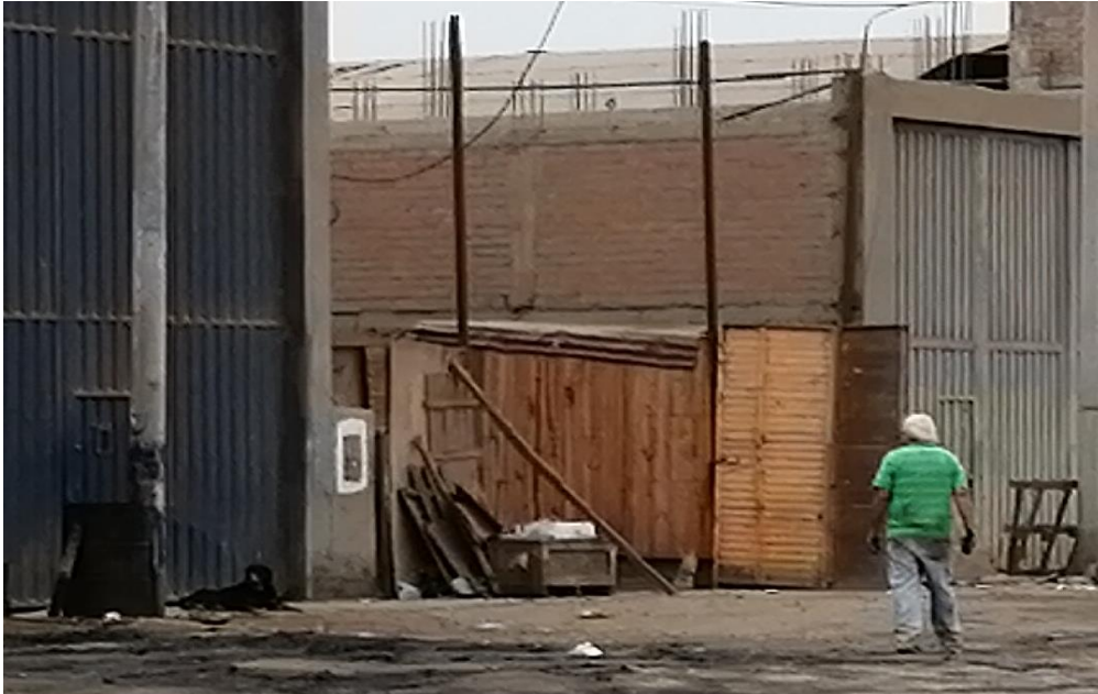
Foto N° 3.- edificación con material precario de madera. Mz B
