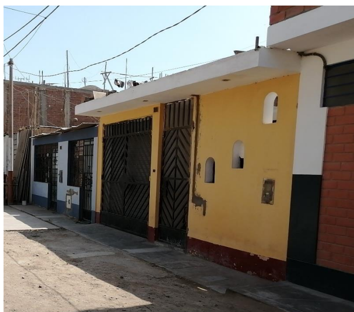
Foto N° 21.- viviendas familiares de 1 piso con material noble. Mz N lotes 18
