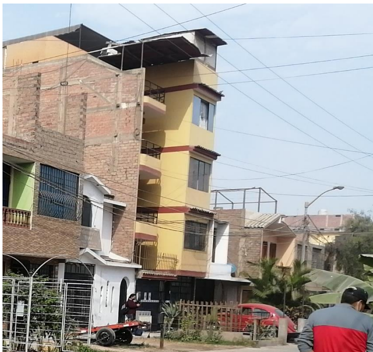
Foto N°13.- Vivienda multifamiliar de 4 pisos en la Mz C3 lote 17.
