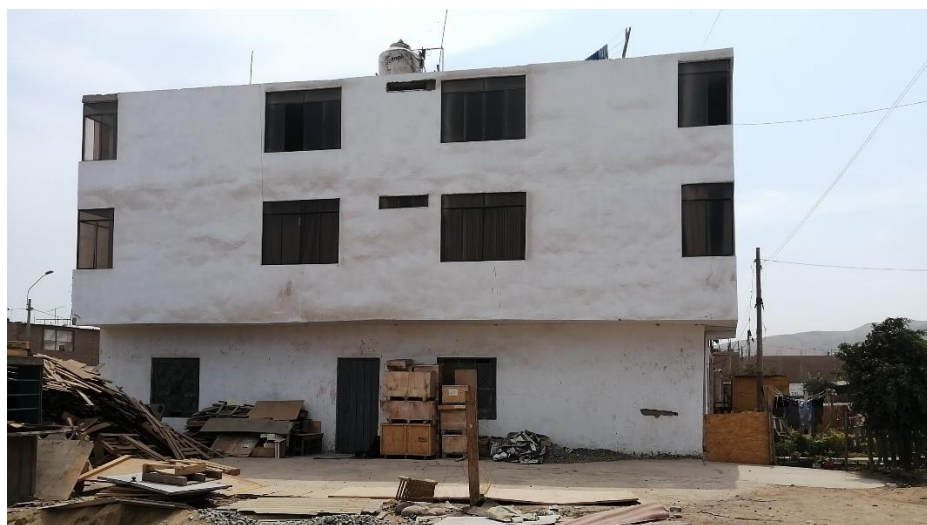
Foto N°4. Vivienda de material noble con techo de concreto armado y muros de ladrillo de 3 pisos. Mz A lote 13
