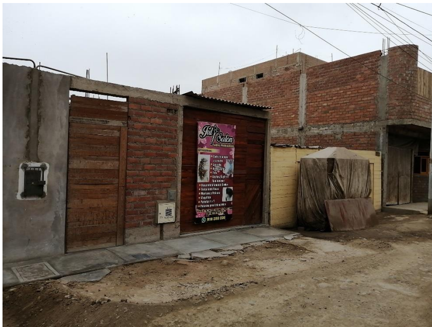
Foto N°6. Vivienda de 1 piso con material noble. Mz C, Lote 29
