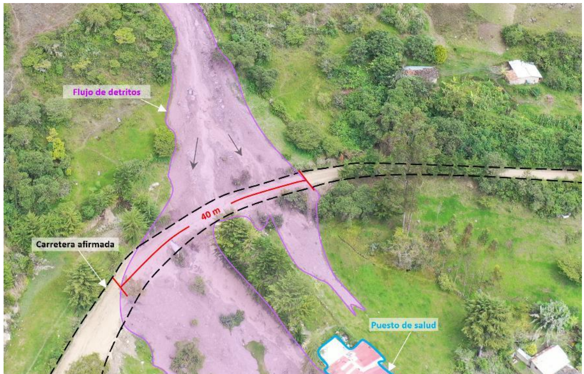
Figura 19. Se observa la zona de deposición del flujo de detritos, afectando la carretera en un tramo de 40 m y puesto de salud Huasmín.
