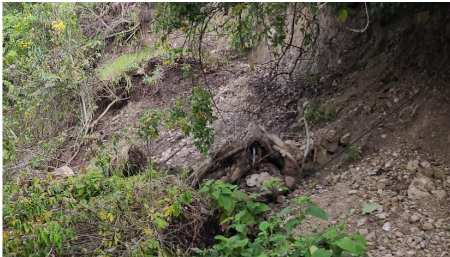
Fotografía 4. Deposito coluvio deluvial, compuestos por gravas y bloques subangulosos y subredondeados, dentro de una matriz arcillo – limosa. (Coordenadas UTM WS-84 -17S, Norte: 9243497 – Este: 804525).
