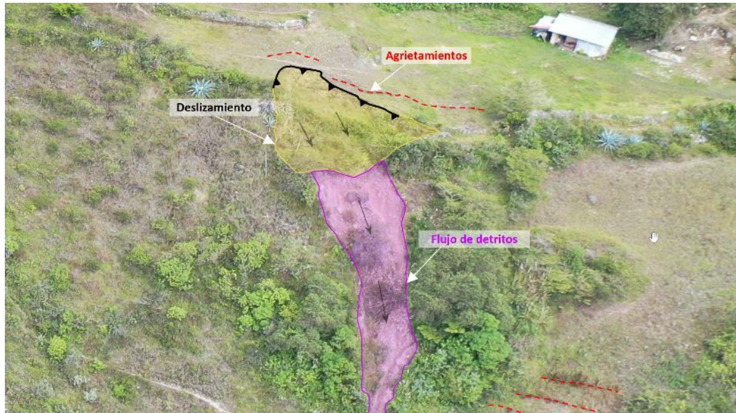
Figura 22. Se puede observar agrietamientos sobre el escarpe principal, que indica el avance retrogresivo del movimiento.
