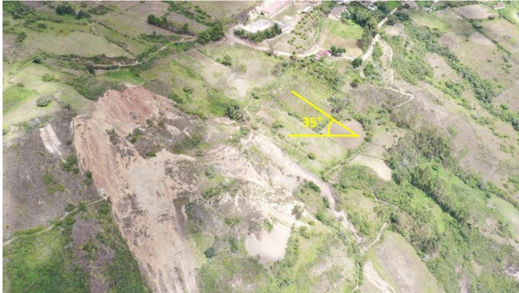
Figura 7. Deslizamiento ubicado al norte de la localidad Huasmín, se observa que la pendiente del terreno es muy fuerte – 35°.
