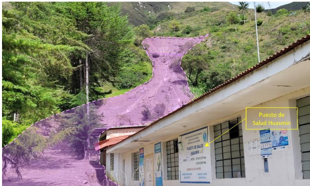
Figura 20. Se aprecia que el flujo de detritos llegó al puesto de salud, obstruyendo los ingresos de manera temporal.
