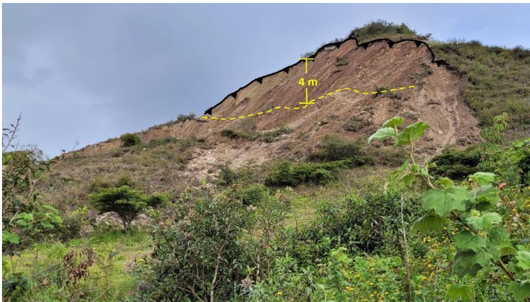
Figura 25. Escarpe principal, tiene un salto promedio de 4 m. (Coordenadas UTM WS-84 -17S, Norte: 9243787 – Este: 804559).
