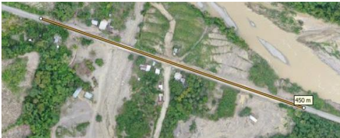
Fotografía 7. Km 256 + 350 y el km 256 + 800, carretera Belaunde Terry (450 m afectados).
