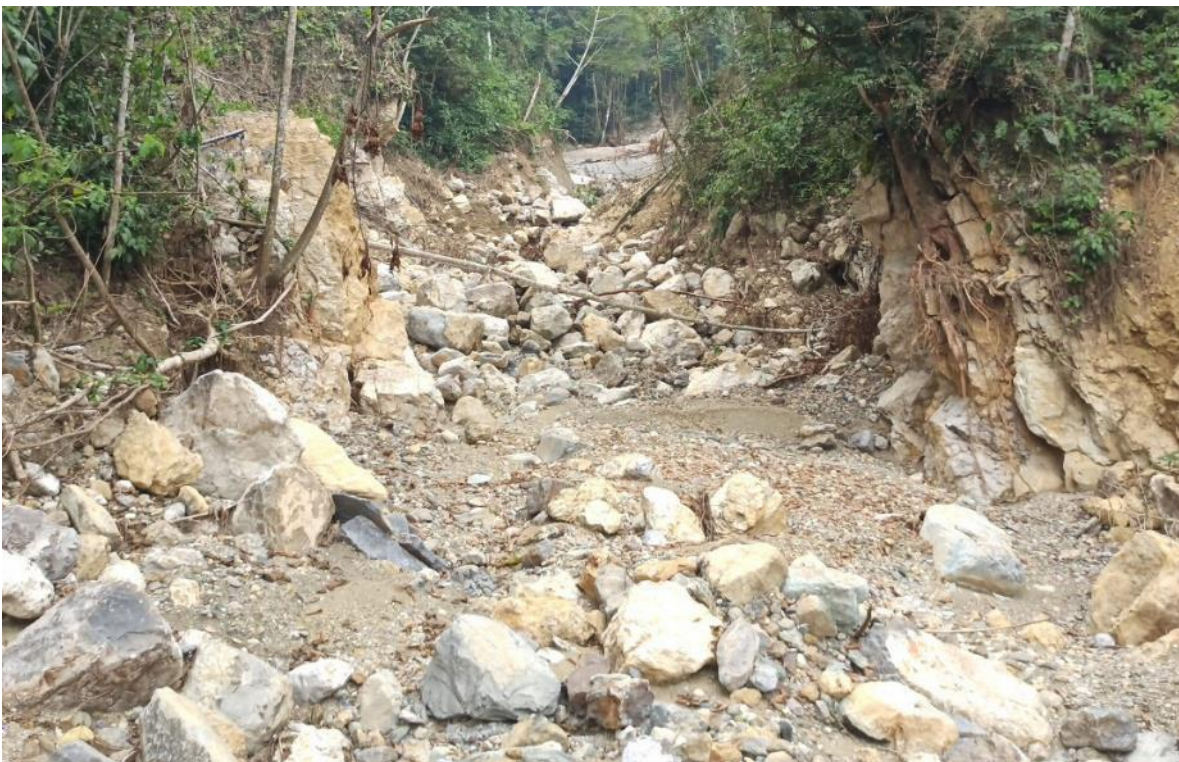
Fotografía 3. Parte media del cauce de la Qda. Olón, se aprecia bloques con dimensiones menores a 4 m.
