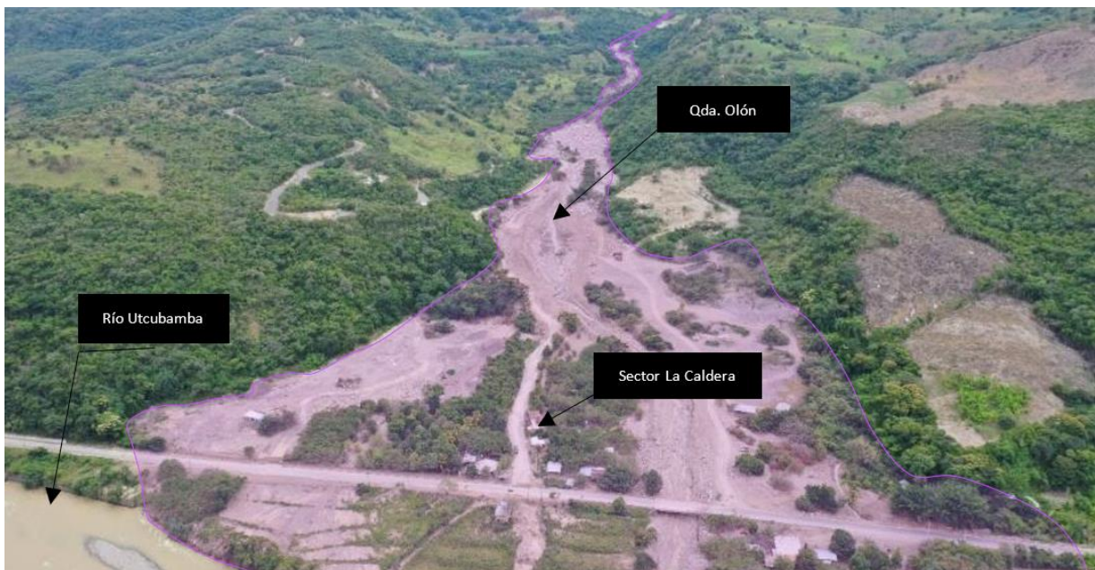
Figura 12. Flujo de detritos (polígono color magenta), efectos en el sector La Caldera y carretera Belaunde Terry afectada (km 256 + 350 y el km 256 + 800).
