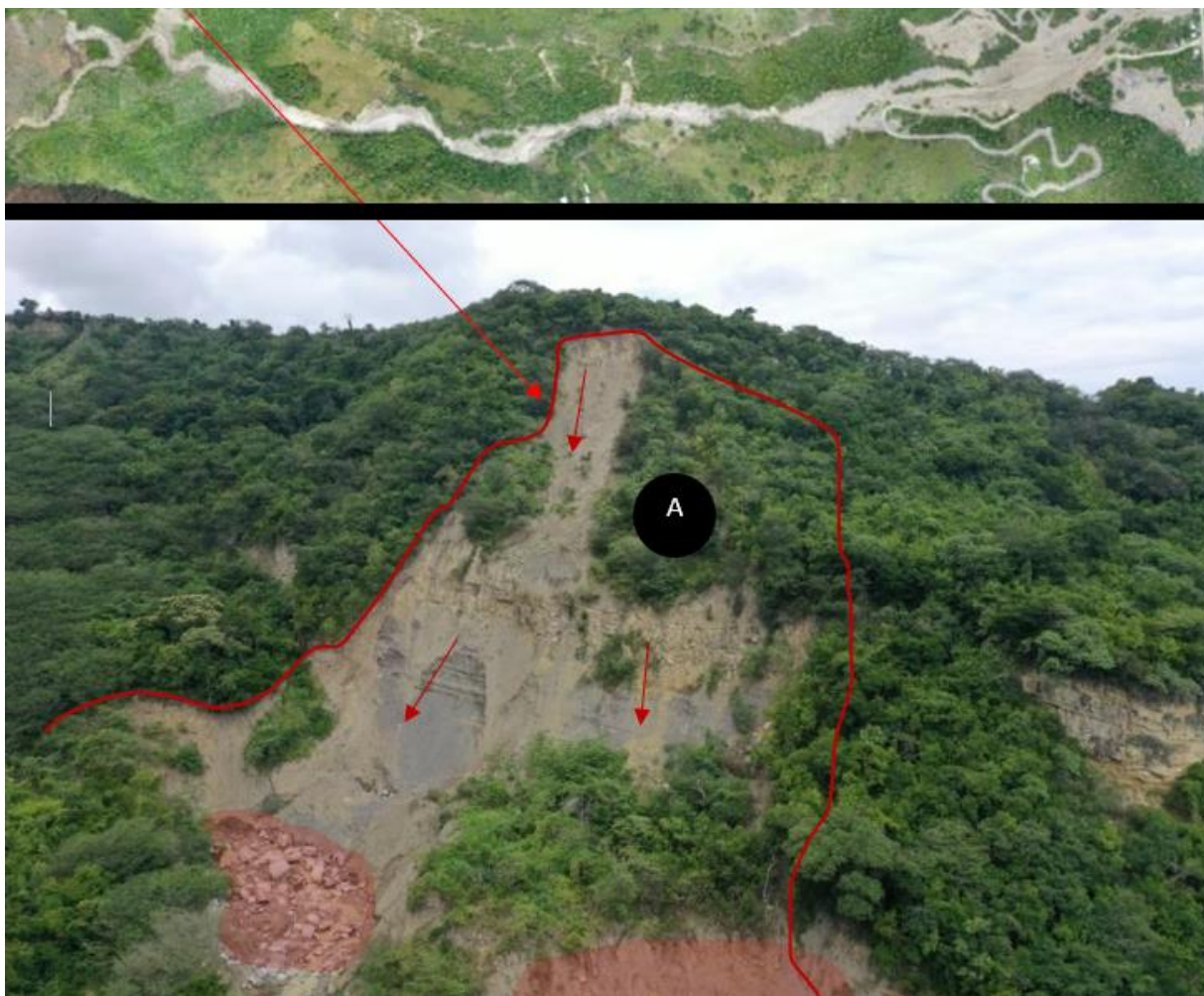
Figura 9. Derrumbe (A) en caliza margosa, ubicado a 1.8 km del sector La Caldera.
