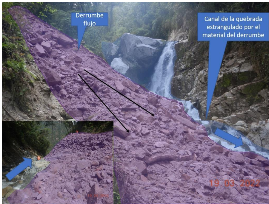
Figura 6. Vista tomada en coordenadas UTM 769369S; 8544386N. Se aprecia los materiales que en el momento de la inspección estrangulan el cauce de la quebrada.
