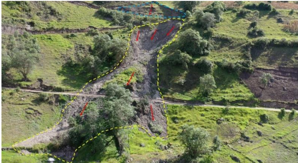
Figura 26. Vista del cuerpo del derrumbe (líneas punteadas amarillas) que ha afectado dos tramos de la vía El Verde – Las Palmeras, además se aprecia un derrumbe inactivo (líneas discontinuas celestes) en la parte superior.
