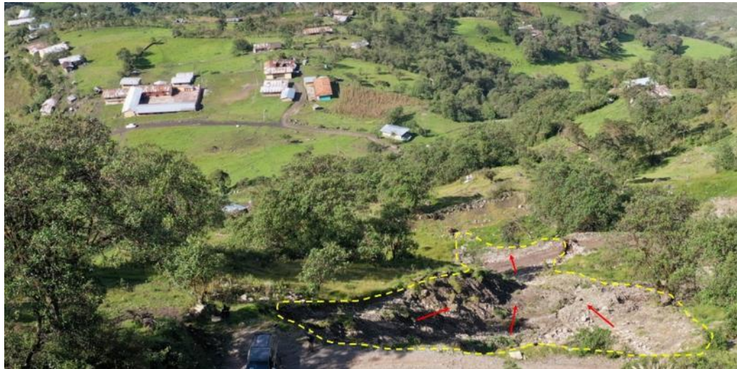
Figura 23. Viviendas afectadas durante la activación del flujo de detritos.
