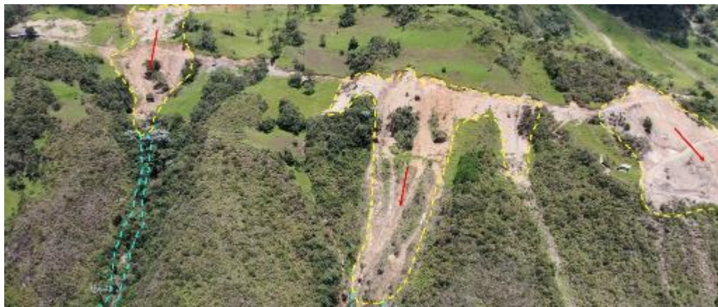
Figura 20. Vista de la parte alta de la Localidad de La Chamana, donde se originaron los derrumbes (en línea amarilla discontinua) producto del colapso de los materiales acumulados por la apertura de la nueva trocha, y que se comportaron como flujos de detritos colina abajo (línea celeste discontinua).
