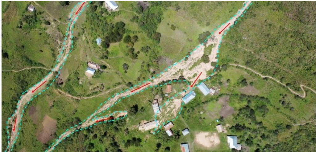
Figura 21. Vista de la parte baja de la localidad de La Chamana, donde los flujos de detritos afectaron a las viviendas de la comunidad.
