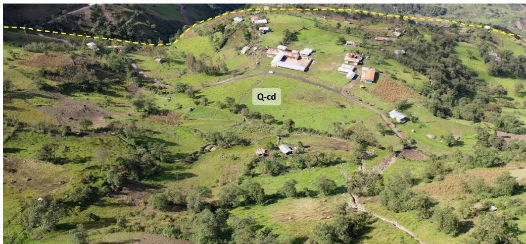
Figura 8. Depósito coluvio-deluvial antiguo sobre el cual se ha asentado la comunidad de El Verde.
