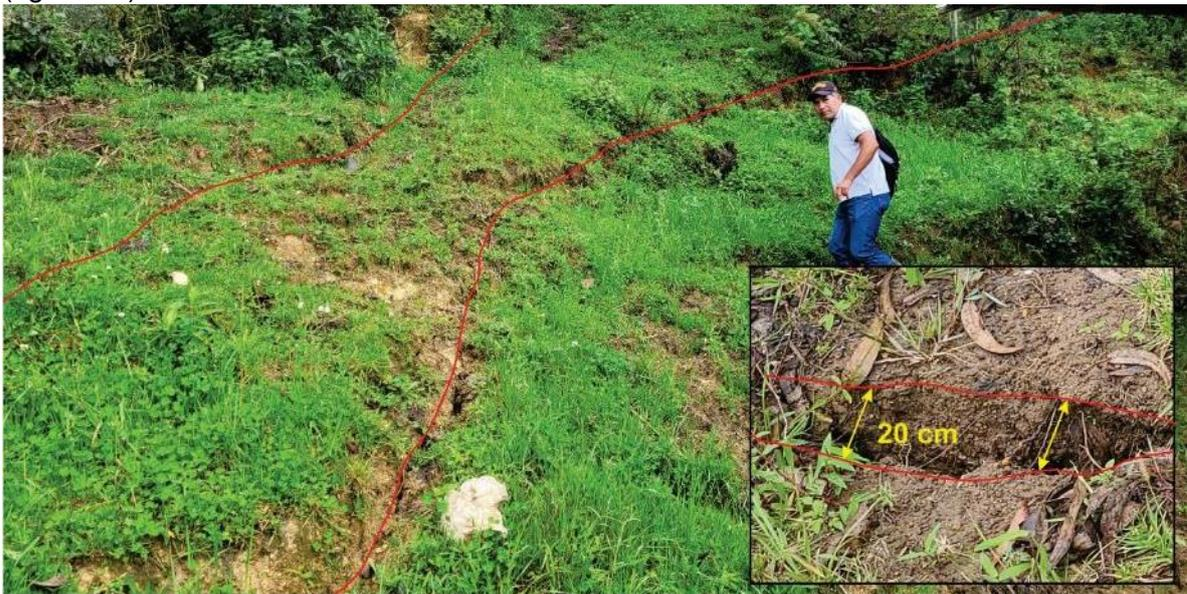
**Figura 22.** Grietas de 10 a 30 cm de ancho, se extienden de 15 a 40 m de longitud al borde de la carretera La Sinra-Trigopampa.
