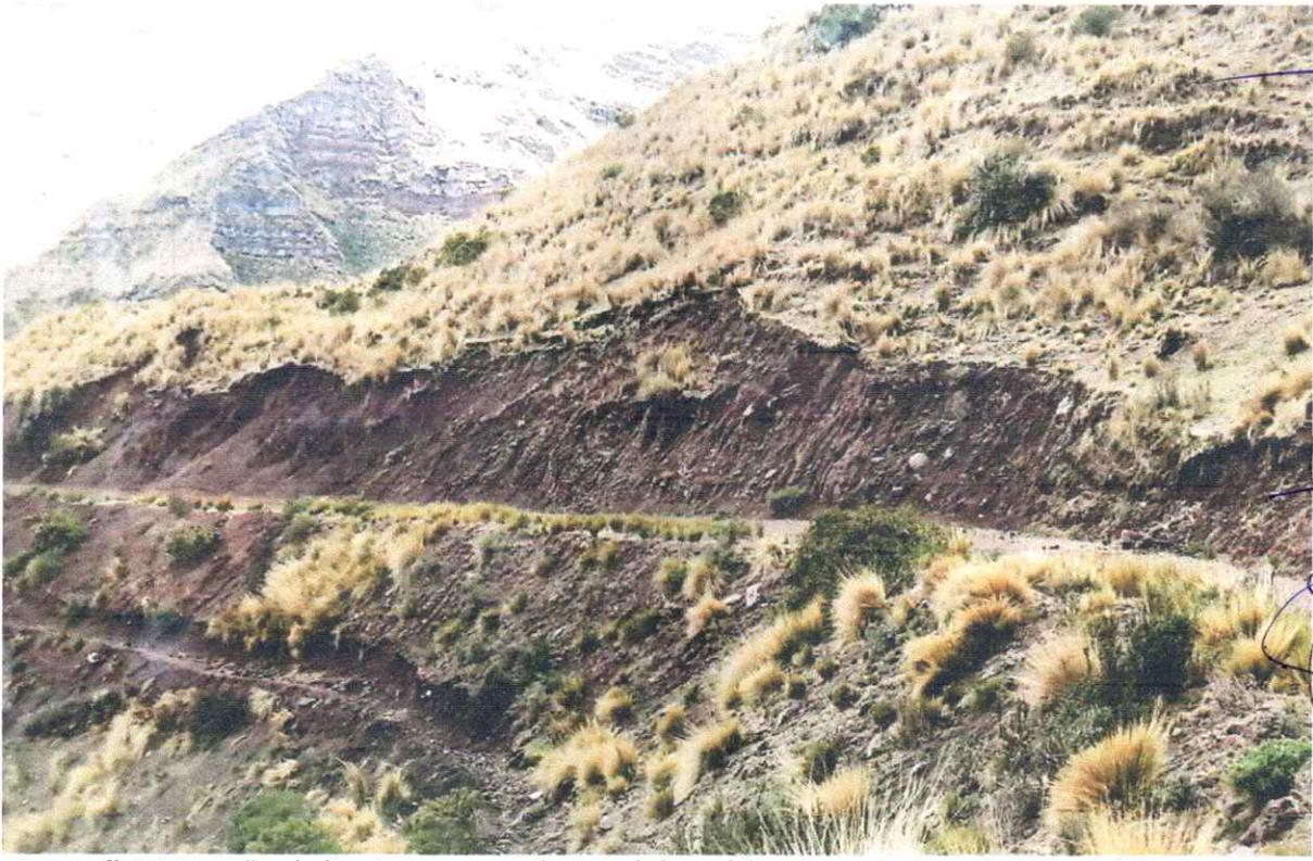
**Fotografía 14.** Pequeños deslizamientos que se observa a lo largo del camino vecinal a partir del km:7+640 a Km: 9 +250 (Comunidad de Mancco – Comunidad de Huarca). Nótese el elevado grado de meteorización de limoarcillitas rojas que han dado paso a suelos residuales.
