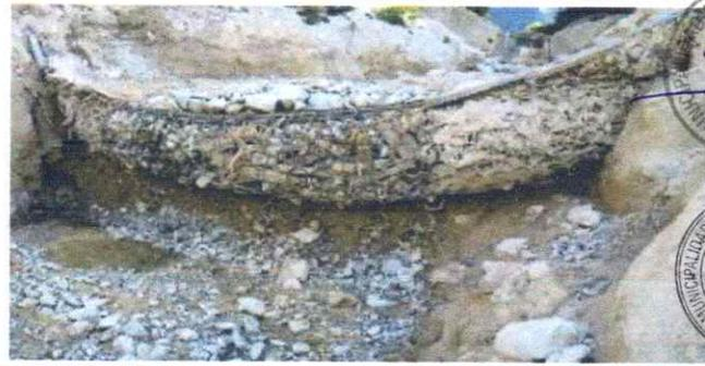
\* Encauzamiento del lecho principal, ríos y quebradas afluentes, en zonas donde se produzcan socavamientos laterales de las terrazas alledañas. Para ello se debe construir espigones laterales, enrocado o gaviones para aumentar la capacidad de tránsito en el cauce de la carga sólida y líquida durante las crecidas y limpiar el cauce.
