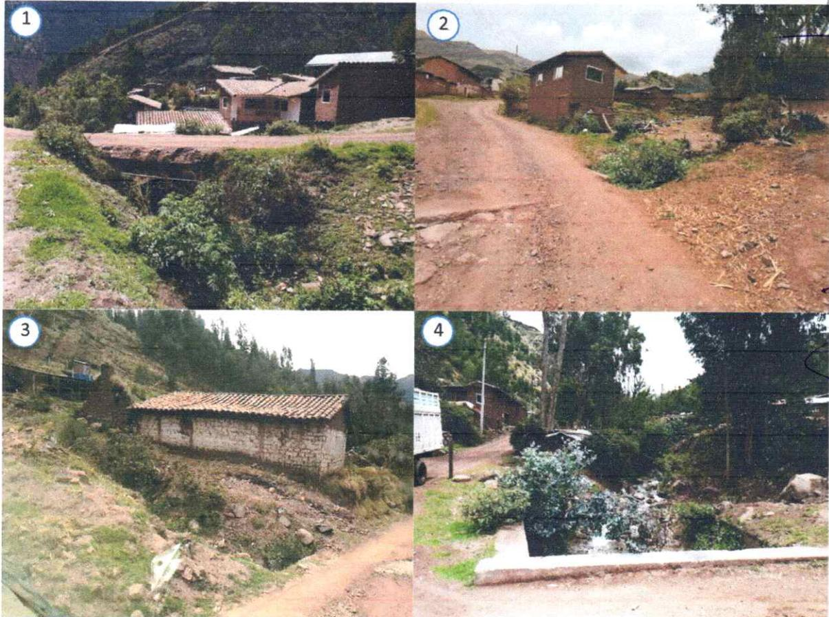
**Fotografía 17.** En las comunidades Yutto (1), Ttiomayo (2) y Mancco (3) (4) de la microcuenca de Manccomayo, se observan cauces colmatados y encauzados por partes, sujetos a ser removido, que ante lluvias estacionales u ocasionales contribuyen a la generación de flujos de detritos e inundaciones, de represarse estos cauces y desembalsarse afectaría a las viviendas y terrenos de cultivo que se ubican aguas abajo.
