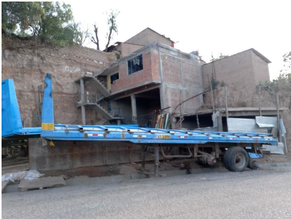
FOTO N°06. LAS ÁREAS DE RIESGO ALTO FUERON REDUCIDOS POR LA CONSTRUCCIÓN DE VIVIENDAS DE MATERIAL NOBLE AL LADO IZQUIERDO.
