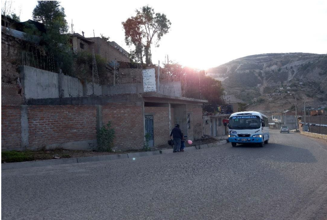
FOTO N°05. LAS ÁREAS DE RIESGO ALTO FUERON REDUCIDOS POR LA CONSTRUCCIÓN DE VIVIENDAS DE MATERIAL NOBLE AL LADO IZQUIERDO CON MUROS DE CONCRETO ARMADO EN LA PARTE POSTERIOR.
