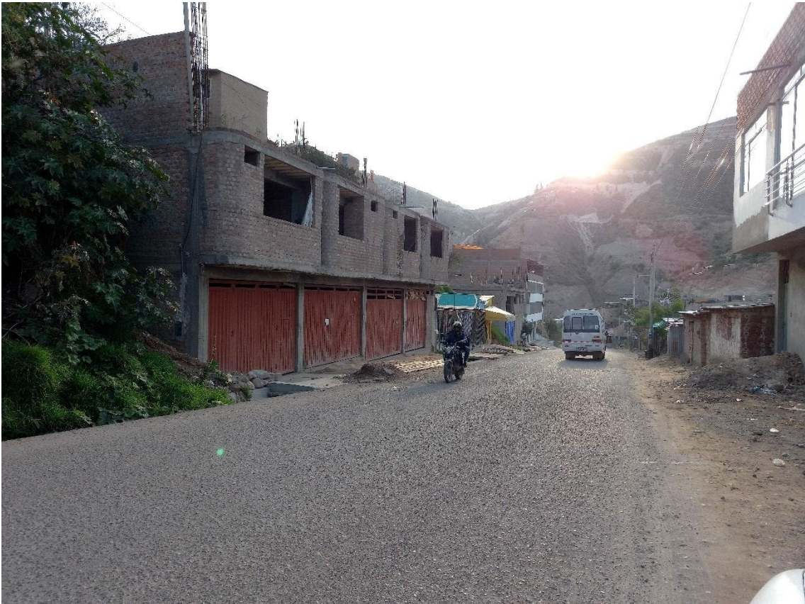
FOTO N°02. LAS ÁREAS DE RIESGO ALTO FUERON REDUCIDOS POR LA CONSTRUCCIÓN DE VIVIENDAS DE MATERIAL NOBLE AL LADO IZQUIERDO.
