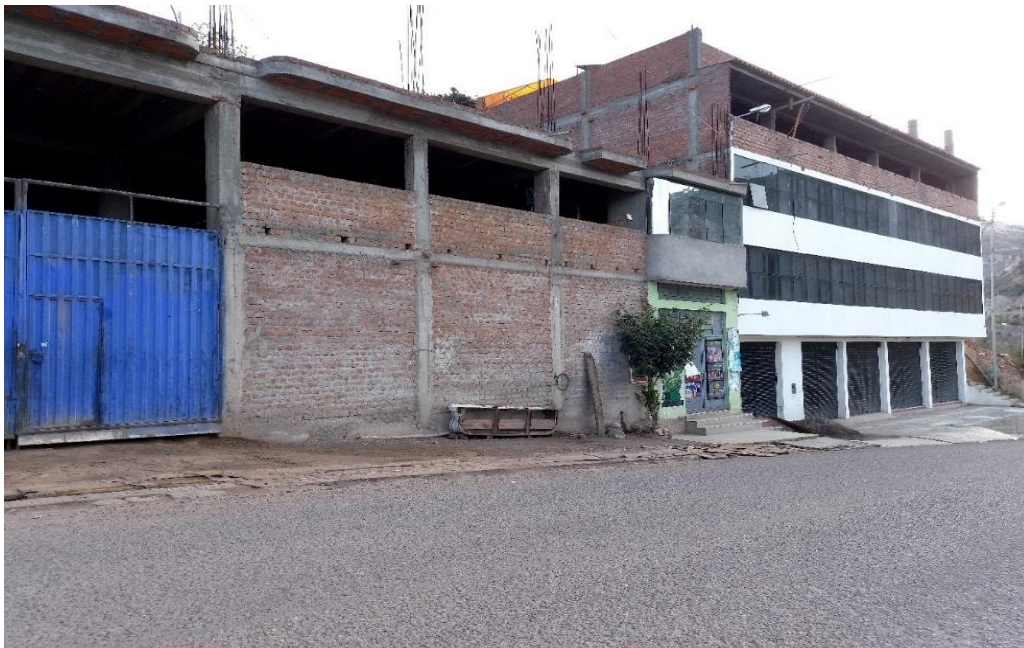
FOTO N°03. LAS ÁREAS DE RIESGO ALTO FUERON REDUCIDOS POR LA CONSTRUCCIÓN DE VIVIENDAS DE MATERIAL NOBLE AL LADO IZQUIERDO.
