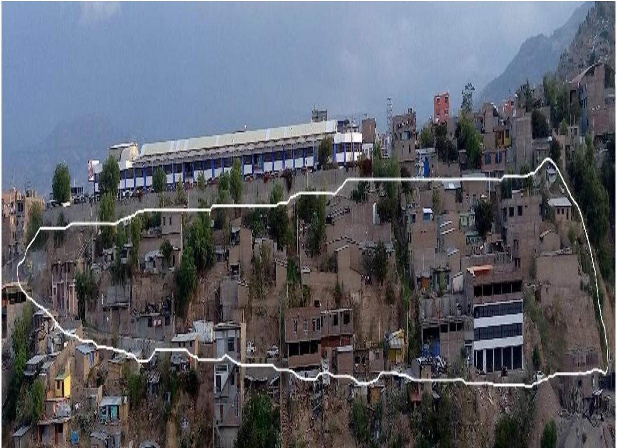
FOTO N°07.DELIMITACIÓN DEL ÁREA DE EVALUACIÓN DONDE LAS ÁREAS DE RIESGO ALTO FUERON REDUCIDOS POR LA CONSTRUCCIÓN DE VIVIENDAS DE MATERIAL NOBLE EN LA AVENIDA A MOLLEPATA.
