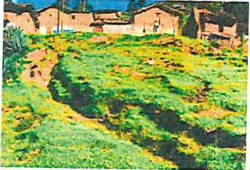
Fotografía N° 02.: Viviendas afectadas por el proceso de Movimientos en Masa.
