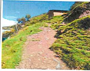
Fotografía N° 01. Área Viviendas expuestas a laderas inestables en el sector Chucho.
