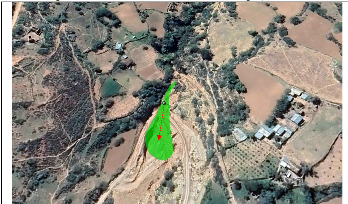
Imágen satelital N° 7: Huaicos en la Quebrada Gangran, distrito de Aczo.
