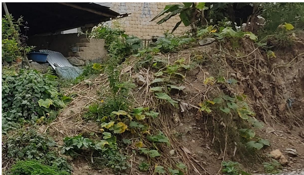
Fotografía 8. Depósito conformado por gravas, bloques de origen calcáreo de forma angulosos, en matriz arcillo – limosa.
