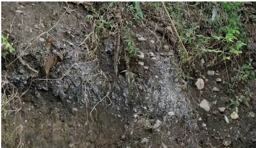
Fotografía 5. Observamos gravas y bloques angulosos a subredondeados, en matriz arcillo limosa. Coordenadas UTM WGS84, Norte: 9301824 – Este: 753934.
