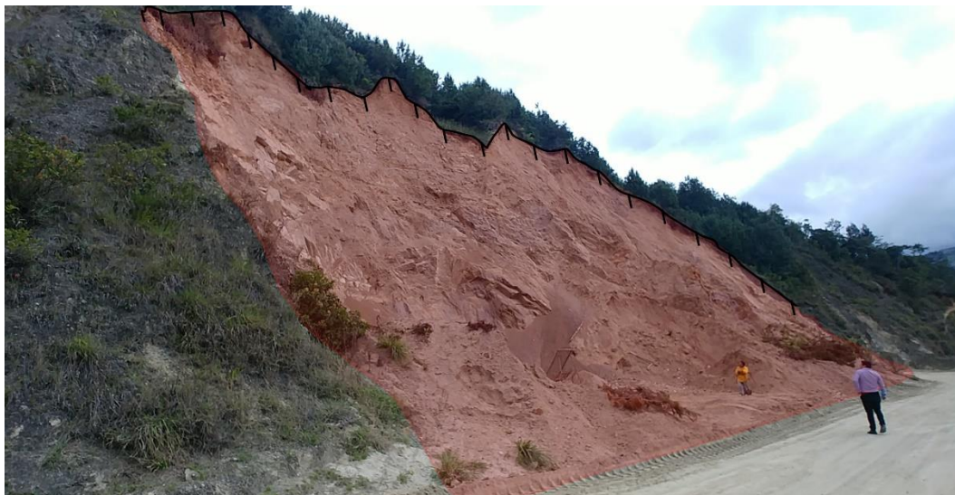
Figura 11. Se observa el derrumbe en el talud de corte de la carretera (Sócota – Cutervo), el cual aumenta su volumen debido a la explotación de material para afirmado. Coordenadas UTM WGS84, Norte: 9301995 – Este: 755160.
