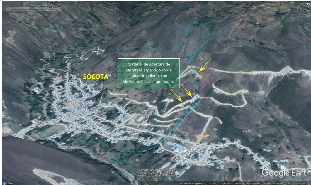
Figura 22. En la imagen del 2017, se observa que el material del corte de la ladera para la apertura de la trocha carrozable, es esparcido en el talud de relleno. Fuente: Google Earth.
