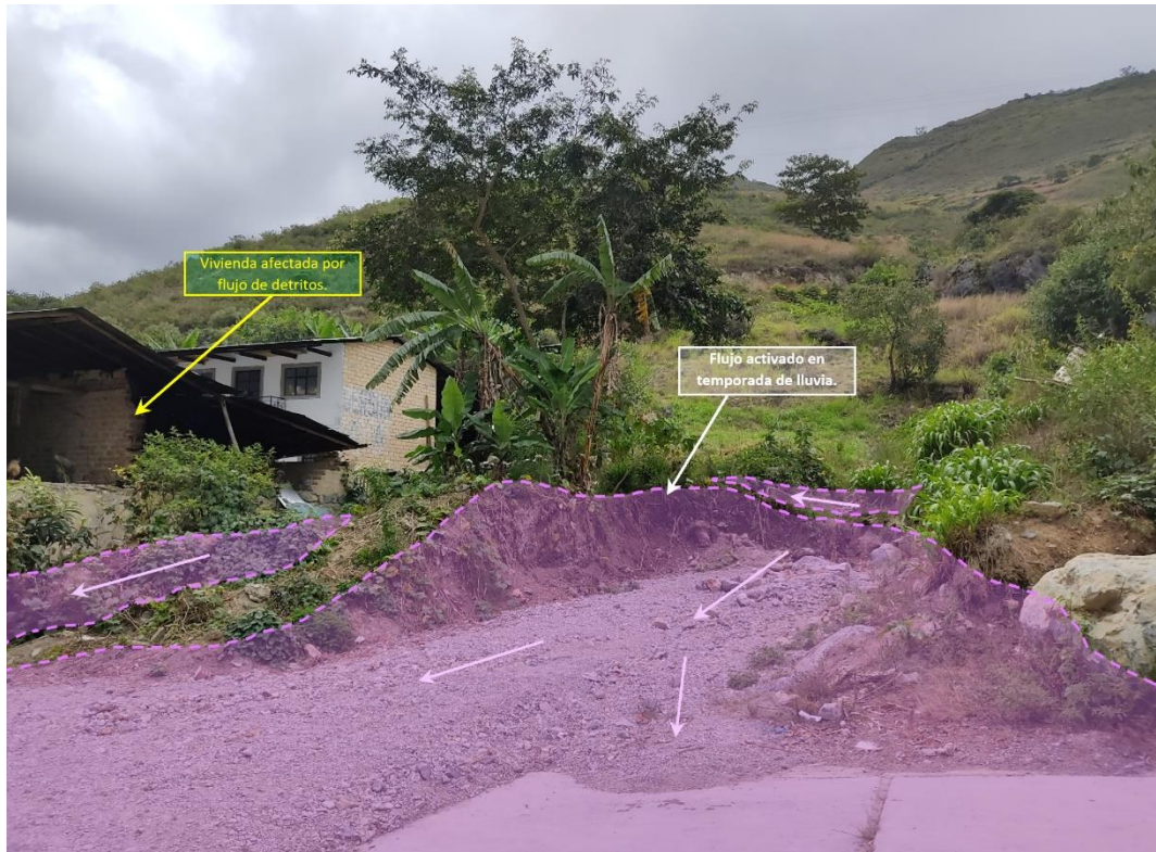
Figura 26. El flujo de detritos afectó una vivienda y obstruyó el Jr. Dos de enero de manera temporal.
