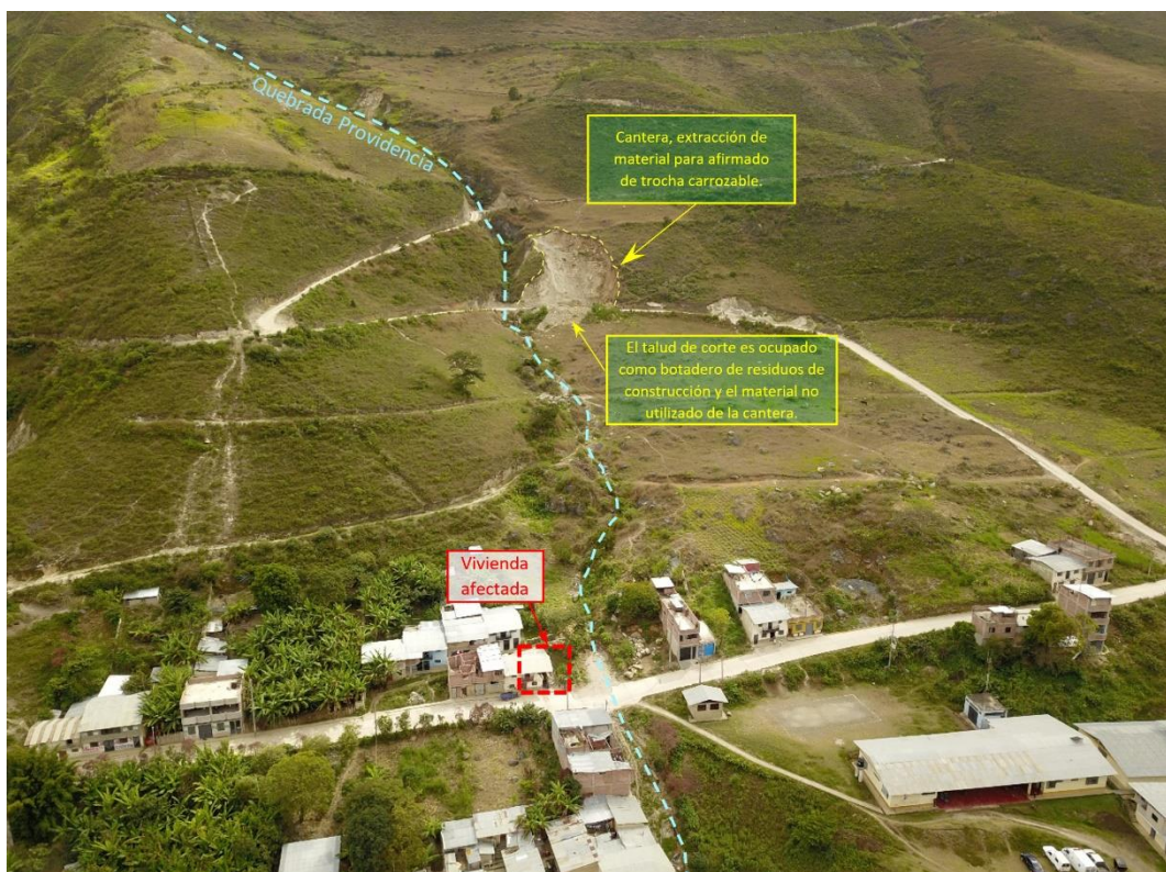
Figura 25. En la imagen tomada en el 2021 con el dron, se observa una cantera, del cual extraen material para afirmado de la trocha carrozable, parte del material extraído es ubicado en el talud de relleno, y en temporada de lluvia es arrastrado hacia la quebrada.
