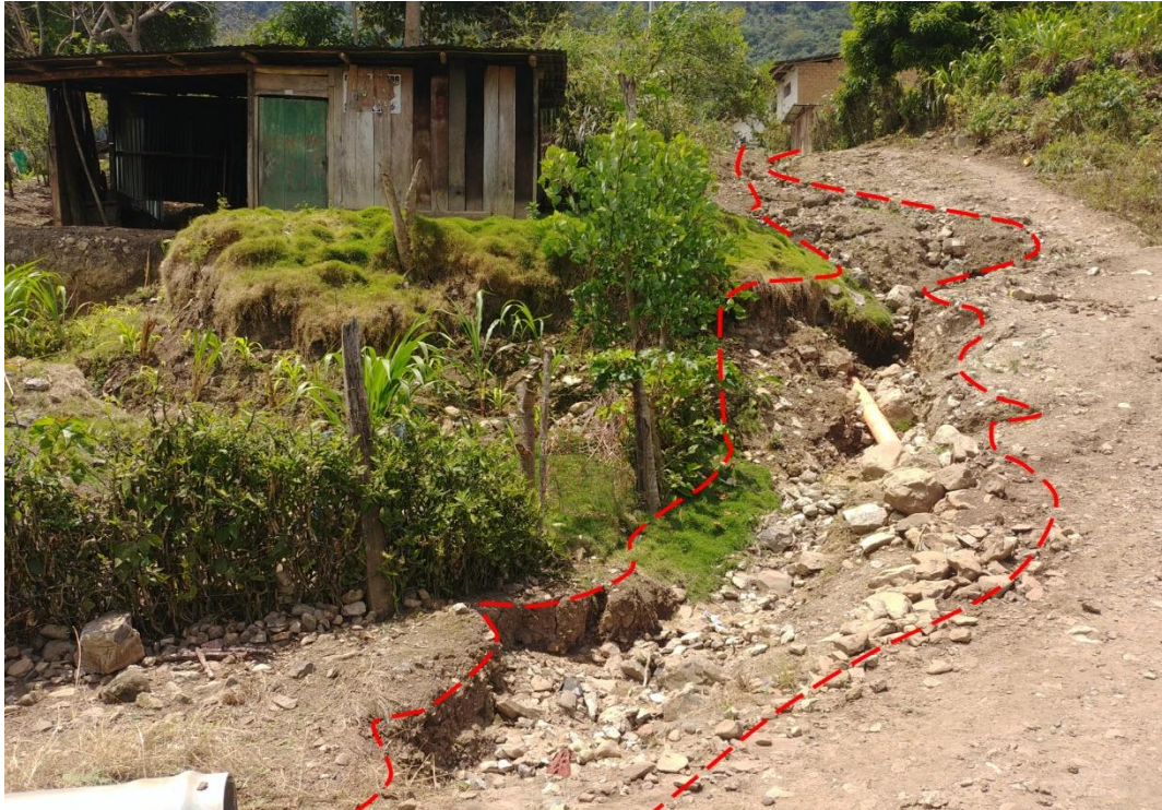
Figura 12. Grieta en el flanco izquierdo del deslizamiento, afecta trocha carrozable Los Patos – San Cristóbal, quedando intransitable. Coordenadas UTM WGS84, Norte: 9351876 – Este: 813457.
