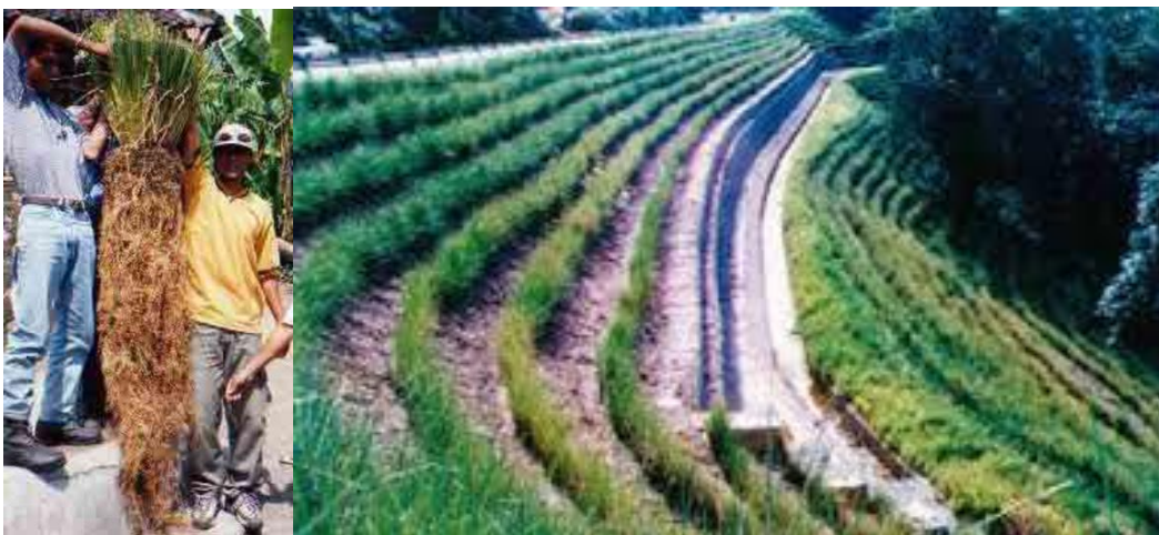
Figura 2. Ejemplo de bioingeniería con arbusto (vetiver) en taludes de materiales sueltos.
