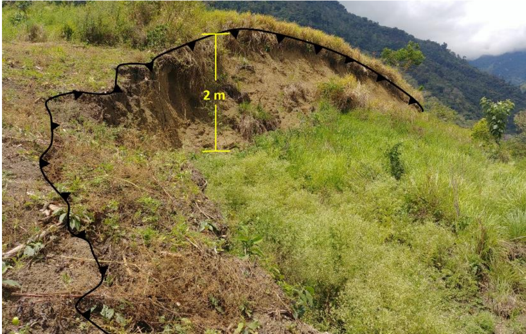
Figura 5. Escarpe principal, tiene un salto promedio de 2 metros Coordenadas UTM WGS84, Norte: 9351923 – Este: 813329
