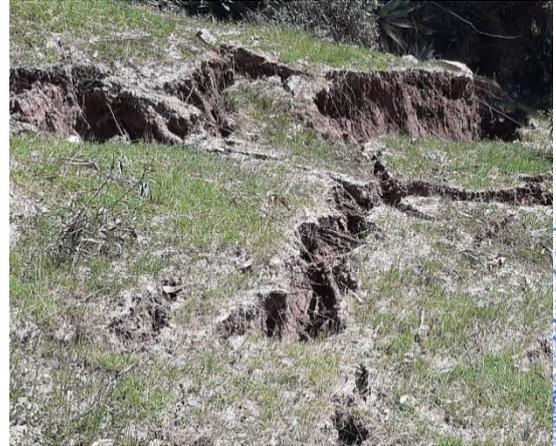
**Figura N° 18:** Se observa escarpa de deslizamiento rotacional.
