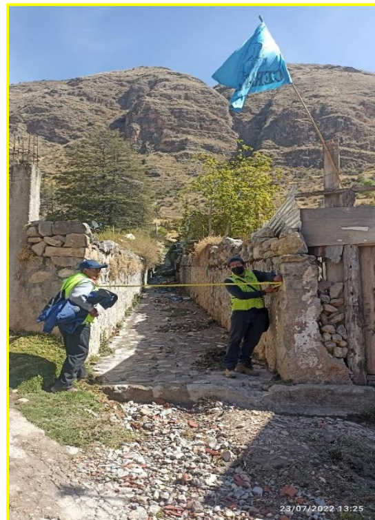
Fotografía 02: Sección del canal de la Qda Sasaiya, ancho de 2.10 m y altura de 1.60 m.
