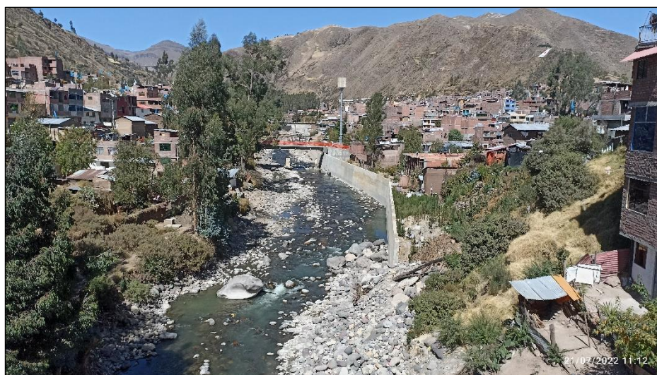
Figura N° 011. Depósitos fluviales del río Sicra.
