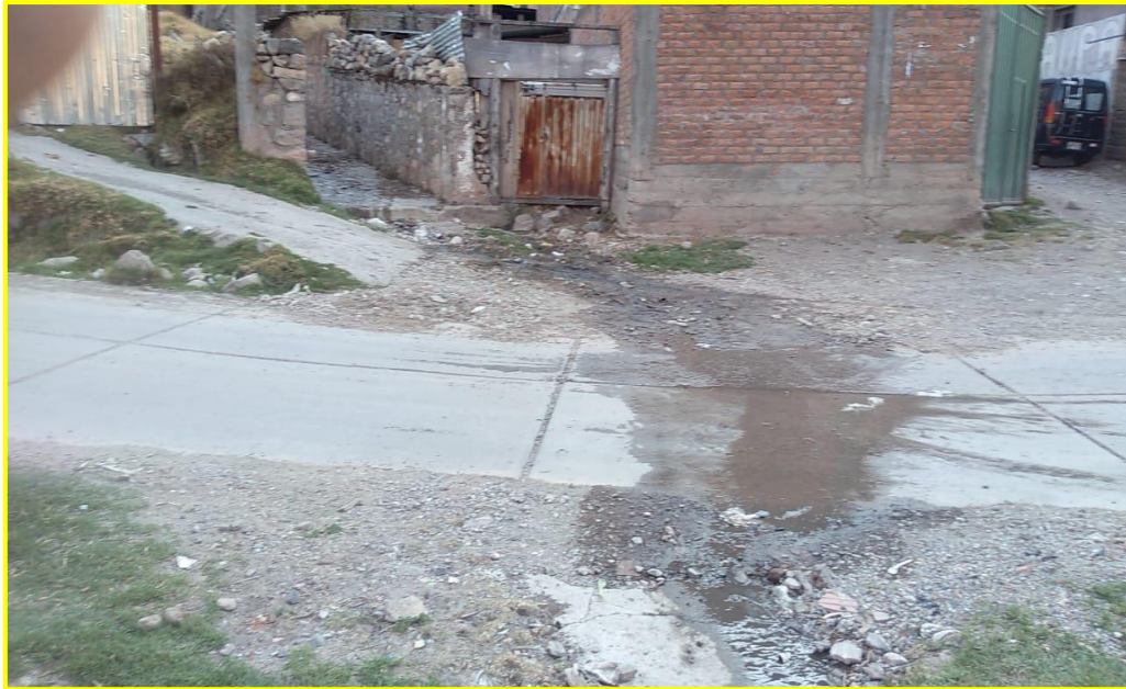
Fotografía 01: Se observa la parte inferior vista hacia el oeste del cruce de la quebrada Sasaiya con una de las principales vías de acceso al distrito de Lircay
