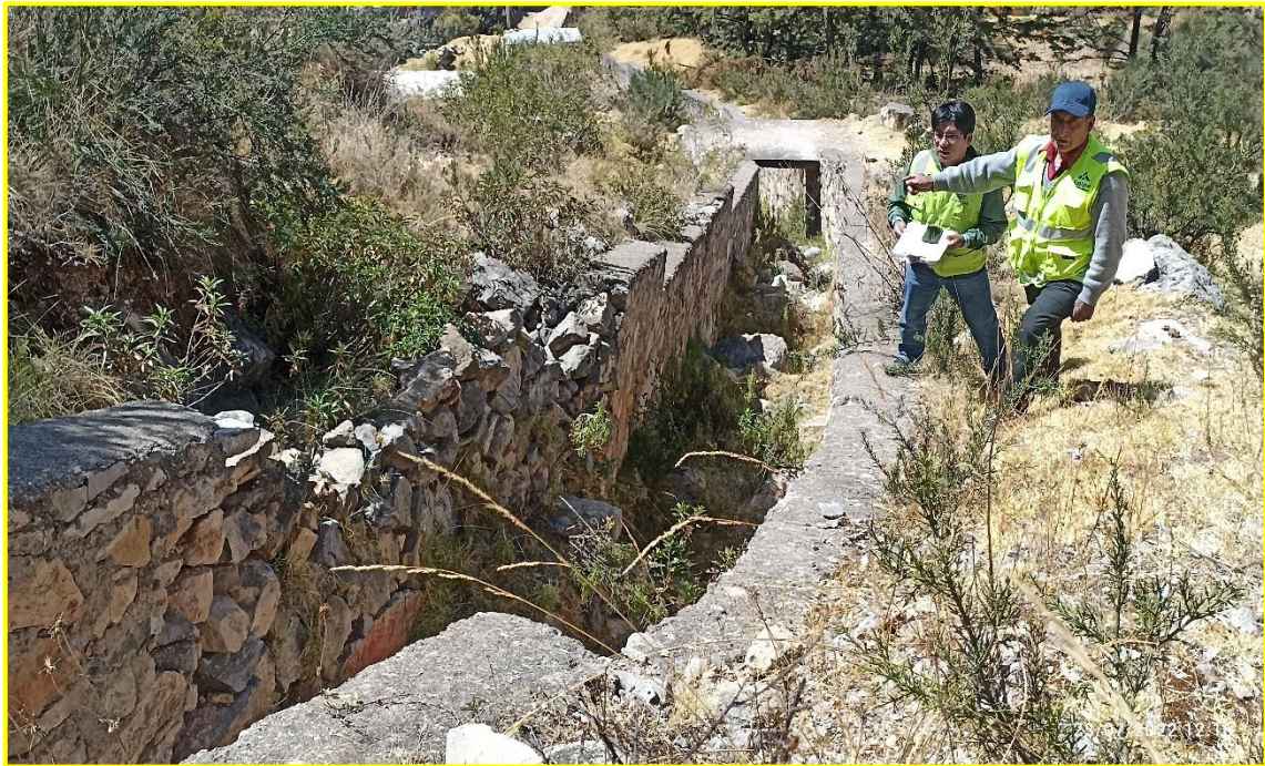
Fotografía 13: Ubicación de puntos críticos, parte media Qda Sasaiya
