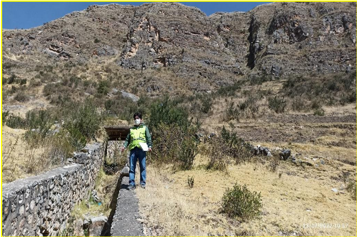
Fotografía 07: Vista de la zona superior del cauce de la Qda Sasaiya donde se puede apreciar la presencia de rocas de gran tamaño dentro del cauce lo cual perjudica su rendimiento.
