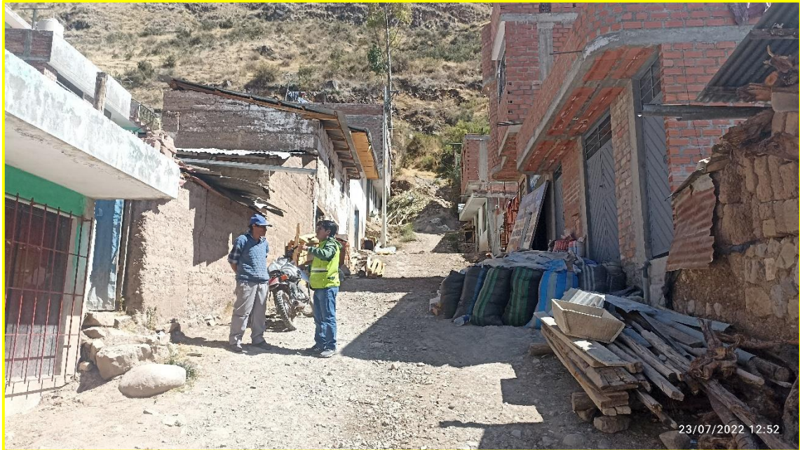
Fotografía 19: Viviendas construidas en base a ladrillo y cemento.
