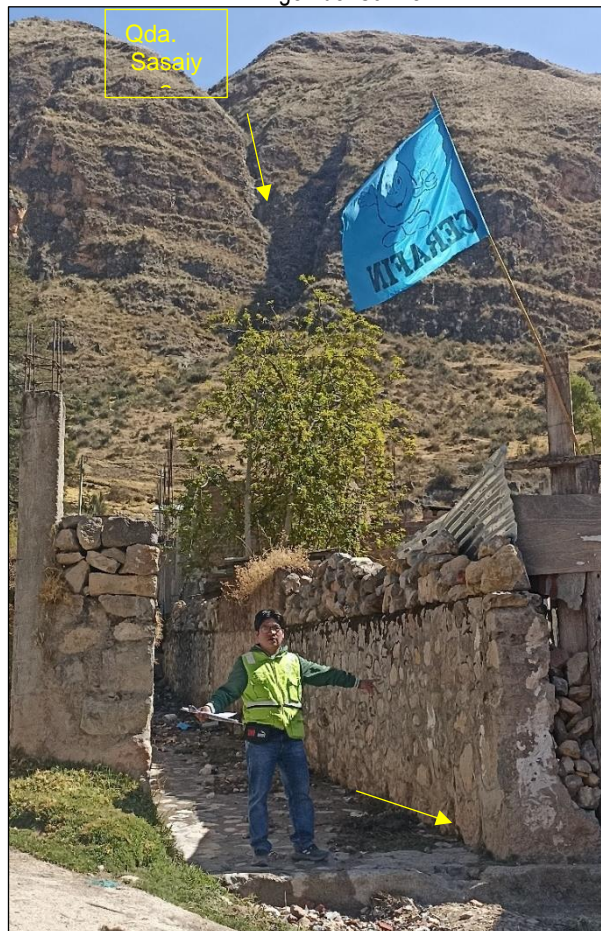
Figura N° 016. Vista del tramo final de la quebrada Sasaiya, colindante a viviendas del barrio Virgen del Carmen.
