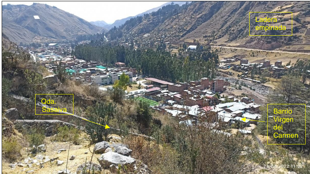
Figura N° 015. Vista de la unidad terraza desde la parte media de la quebrada Sasaiya.
