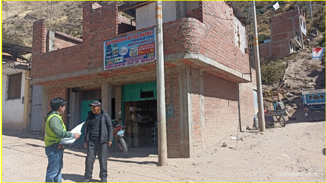
Fotografía 21: Vivienda comercio, construidas en base a material de ladrillo y cemento.
