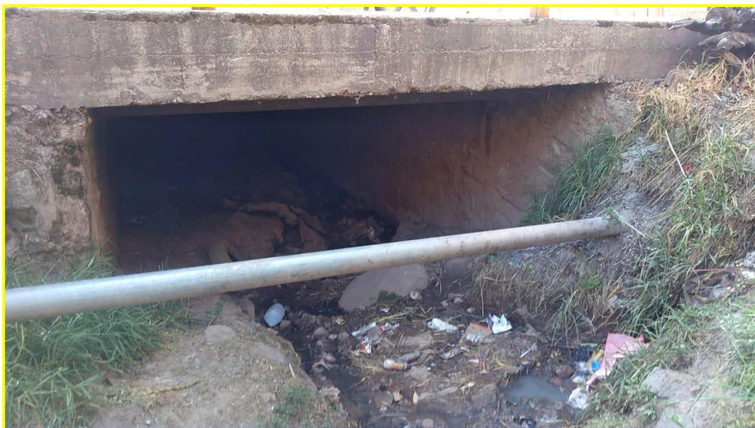
Fotografía N° 08 Vista de pontón con muy reducida sección de cauce, en la imagen se puede observar la reducida sección, debido al acumulamiento de rocas, sedimentos y residuos sólidos; además se puede ver elementos expuestos como tuberías de agua.
