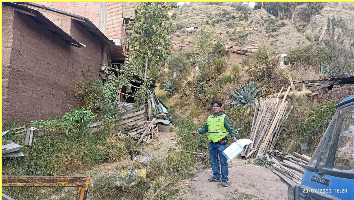
Fotografía N° 07 Vista de viviendas expuestas, altamente vulnerables, debido a la cercanía al eje del cauce y el material predominante de construcción de las viviendas.
