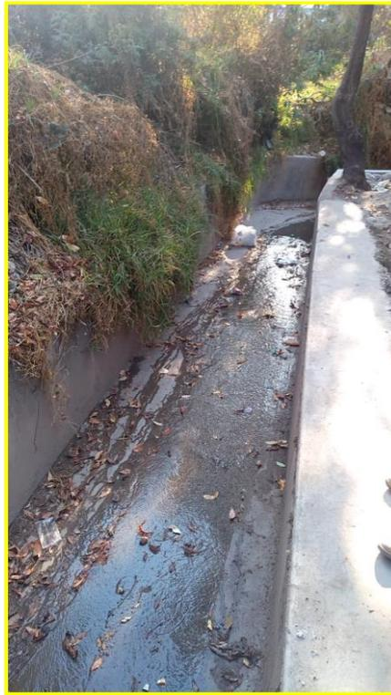
Fotografía N° 09 Vista de tramos encauzadas con estructuras de concreto de la quebrada Jatun Waiqui, en la imagen se observa secciones de la quebrada, que fueron encauzadas para evitar inundaciones
