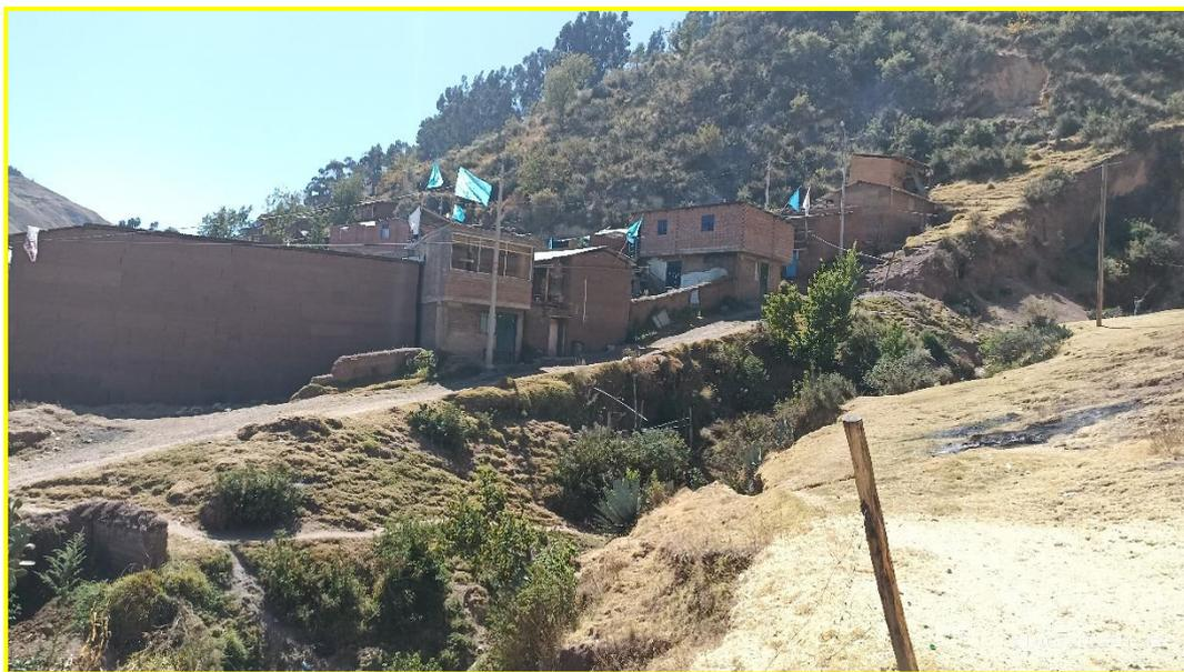
Fotografía N° 06. Vista del cauce de la parte media con pendiente fuerte, lo cual origina erosión debido a las altas velocidades que alcanza el agua; también se observa elementos expuestos (viviendas).
