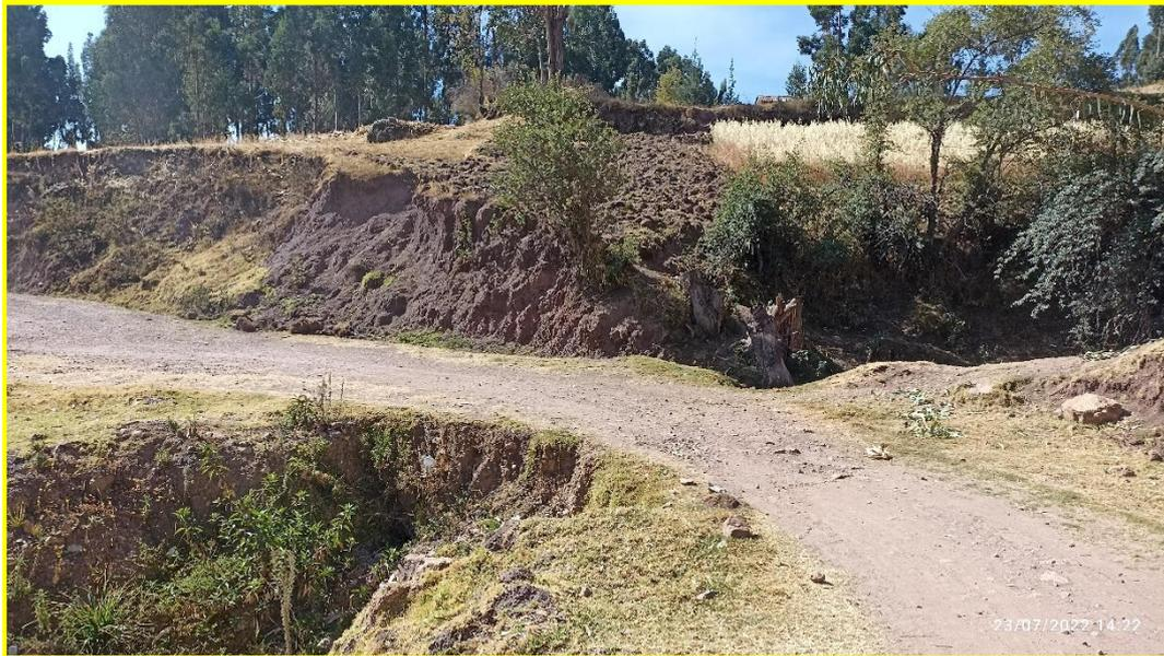
Fotografía N° 03 Vista del camino en la zona de estudio, en la imagen se puede observar que los caminos existentes atraviesan el cauce principal de la quebrada Jatun Waiqui, disminuyendo su sección efectiva.
